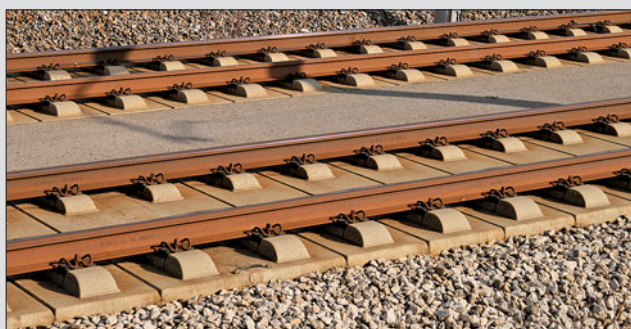
Heute baut man die Festen Fahrbahnen aus Betonfertigteilplatten, hier Bauart Porr auf der Strecke Nürnberg–Ingolstadt.
