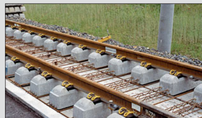
Heute baut man die Festen Fahrbahnen aus Betonfertigteilplatten, hier Bauart Porr auf der Strecke Nürnberg–Ingolstadt.
