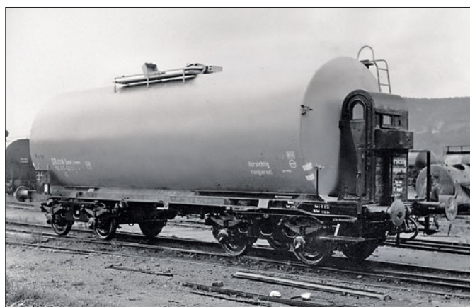
Die DR vermietete viele Drehgestell-Kesselwagen Uerdinger Bauart für den Transport von Ölen; zu ihnen gehörte auch der im Sommer 1961 fotografierte ZZ 52-40-02 [P] mit Heizung und zwei großen Einstellertafeln (unten links). Hingegen war der im September 1953 im RAW Jena untersuchte ZZ 52-43-42, ebenfalls mit Heizung ausgestattet, anfangs noch nicht vermietet. Fotos: Slg. SC
