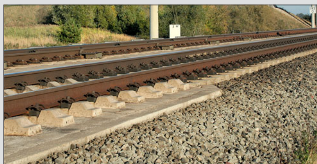
Hier ist der Übergang vom System Rheda mit Betontrog (vorne) zu Rheda 2000 ohne Trog im Hintergrund zu erkennen.
