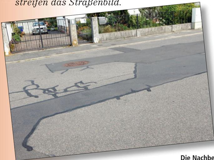
Die Nachbesserungen für Kanalarbeiten haben eine dunklere Teermischung, ein Kanaldeckel liegt selten mittig und überall sollen Teerfüllungen in den Rissen ein weiteres Auffrieren verhindern.
