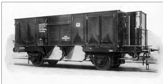
Talbot beteiligte sich an dem Wettbewerb zur Entwicklung eines Universalwagens, den die K.P.E.V. 1907 ausgeschrieben hatte, gleich mit drei Wagen. Dazu gehörten auch die beiden links gezeigten offenen Wagen mit unterschiedlicher Anordnung der Türen und Entladeklappen. Werkfotos Talbot, Slg. Klaus Holl
