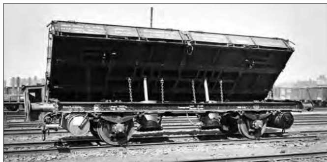
Oben und unten: Der von Both und Tillmann Anfang der 20er-Jahre gebaute Flachboden-Selbstentladewagen war vermutlich der erste in Deutschland gebaute Wagen dieser Art mit pneumatischer Betätigung der Pritsche. Zwar ließ sich der Hersteller das System patentieren, eine nennenswerte Verbreitung fanden die Wagen jedoch nicht.
