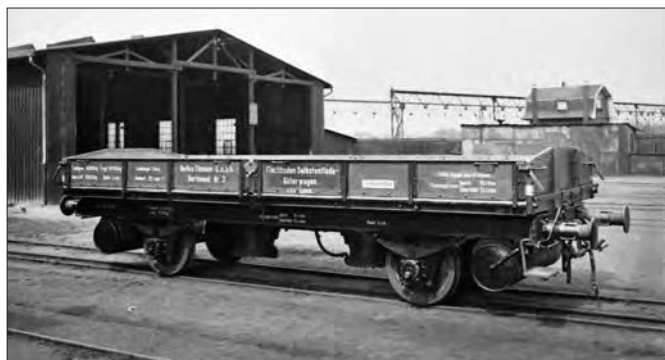
Oben und unten: Der von Both und Tillmann Anfang der 20er-Jahre gebaute Flachboden-Selbstentladewagen war vermutlich der erste in Deutschland gebaute Wagen dieser Art mit pneumatischer Betätigung der Pritsche. Zwar ließ sich der Hersteller das System patentieren, eine nennenswerte Verbreitung fanden die Wagen jedoch nicht.
