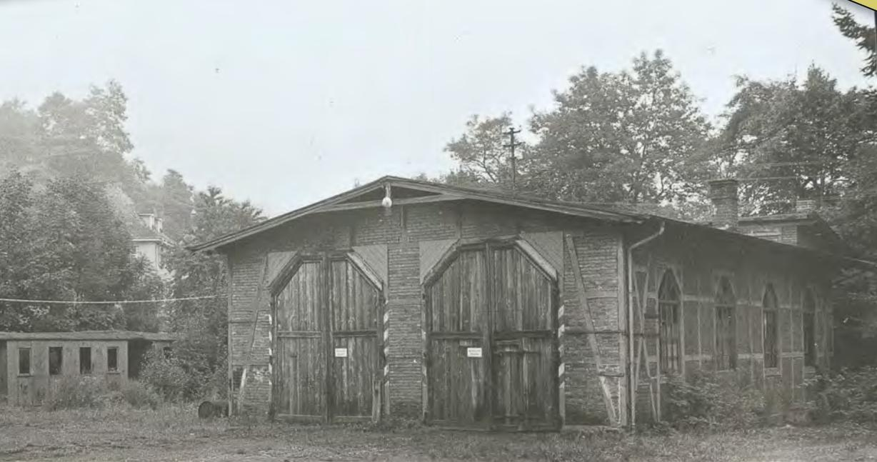
Bereits ohne Gleise präsentierte sich der Lokbahnhof des Bahnhofs Sulzburg dem Fotografen am 20.9.1975. Bei dem schmutzigweißen Gebäude links im Bild handelt es sich um die Dreherei mit einer Achsbank. Hinter dem Lokschuppen spitzt noch das Dach der Werkstatt hervor. Foto: Dipl.-Ing. Herbert Stemmler
