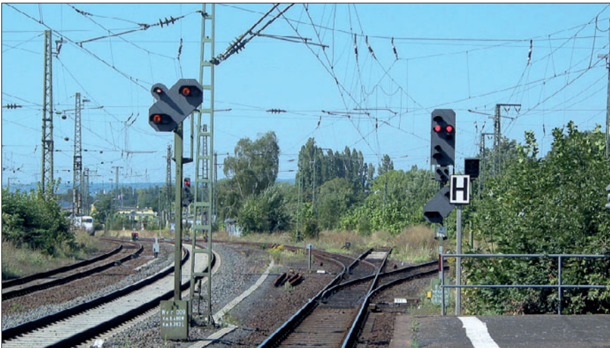
Rechts steht, ein wenig von der H-Tafel verdeckt, ein Hauptperrsignal mit Vorsignal am Mast und dem Signalbild Hp 00. Am Vorsignalwiederholer – links mit dem Signalbild Vr 0 – befindet sich keine Vorsignaltafel, die nur alleinstehende „richtige“ Vorsignale erhalten.
