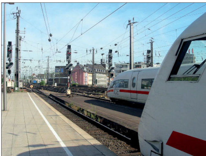
HI-Signale der zweiten Bauform (Einzellichtoptiken) mit Schleuderbetonmasten in einem Bahnhof der ehemaligen DR. Die Firmen Erbert und Siba vertreiben in ihrem Signalprogramm verschiedene Ausführungen.
