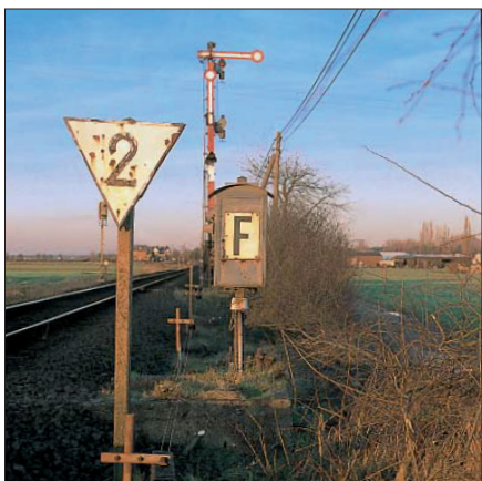
Die ortsfeste Geschwindigkeitstafel mit dem Signalbegriff Lf 4 kündigt für den nachfolgenden Streckenabschnitt eine dauernde Geschwindigkeitsbegrenzung auf 20 km/h, dem Zehnfachen des auf der Tafel stehenden Wertes, an.
