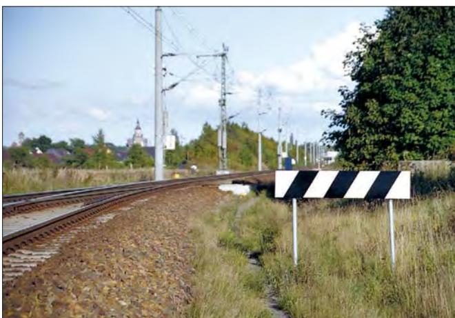
zeichen K 18 „Pflugschar senken“ eine weiße, nach unten zeigende Pfeilspitze mit schwarzem Rand. Die entsprechenden Signalbegriffe bei DB und DR lauten Ne 7a bzw. So 7a „Pflugschar heben“ und Ne 7b bzw. So 7b „Pflugschar senken“.
