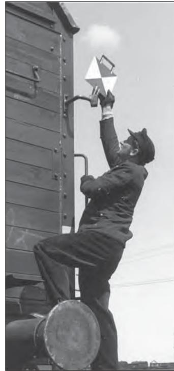
weder das Signal Zg 1a noch Zg 1b zeigen konnten, als Nachtzeichen auf mehrgleisigen Strecken nur ein weißes Licht. Hierfür lautete der Signalbegriff **Zg 1c**. Auf eingleisigen Strecken führten sie nach beiden Seiten ein rotes Licht. Im Signalbuch von 1935 trug das Signal die Bezeichnung: **Kl** – Kleinwagen-Signal –, vor 1935 das **Signal 24**.
