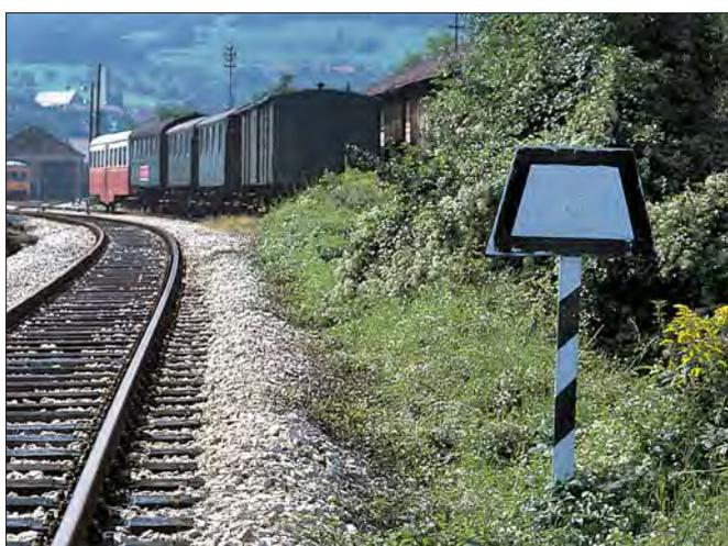
Trapeztafel an der Einfahrt zum Bahnhof Neuffen. Das Signal weicht – wie viele Signale an privaten Nebenbahnen – in den Abmessungen von der Regelausführung der DB ab.
