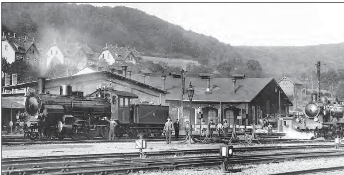
Das Bw Elm um 1910. Links wartet die G5<sup>4</sup> Frankfurt 4191 auf den nächsten Einsatz. Im Vordergrund Weichensignale, deren Kastenlaternen zwar schon die Signalbilder der Einheitsignale zeigen, jedoch noch nicht der Einheitsform entsprechen. Die Prellböcke sind mit beleuchteten Sperrsignalen ausgerüstet.
