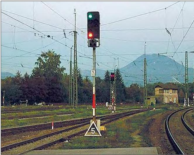
Geschwindigkeitsanzeiger als Signaltafel in Verbindung mit Lichtsignalen im Bahnhof Freilassing im Oktober 2003. Die Anordnung unten vor dem Signal ist in Verbindung mit Lichtsignalen eher ungewöhnlich und wurde vermutlich gewählt, um sicherzustellen, dass die Signale durch das Spitzenlicht der Lokomotiven angestrahlt werden und somit ausreichend beleuchtet sind. Foto Alexander Lindner
