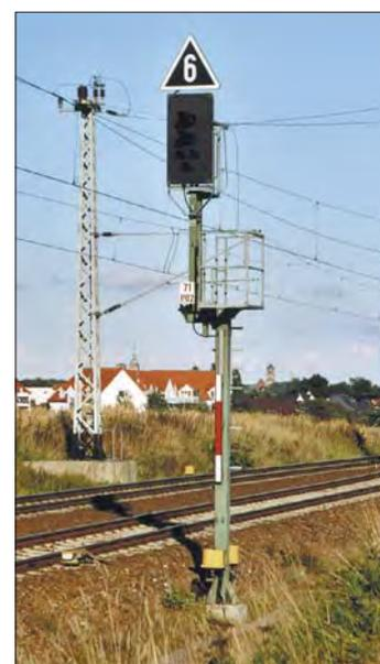
schirm montierte Signaltafeln, wenn hinter dem Signal stets die gleiche Geschwindigkeit einzuhalten ist und wenn eine Signaltafel auch bei Dunkelheit zu erkennen ist.
