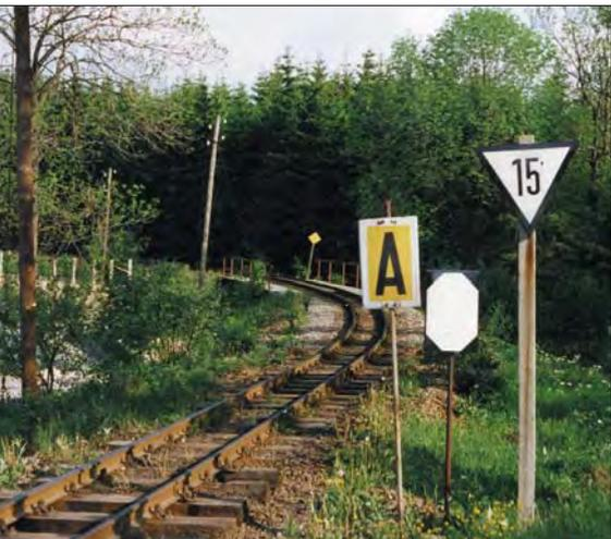
Lf-Signale am Haltepunkt Vierenstraße (Strecke Cranzahl–Oberwiesenthal) im Mai 1992. Die mit der Geschwindigkeitstafel angezeigten 15 km/h sind von der daneben stehenden Trapeztafel an einzuhalten. Daneben eine Anfangtafel, da wegen Bauarbeiten die Geschwindigkeit auf 10 km/h reduziert werden muss (zuvor durch ein Lf 1-Signal angezeigt).
