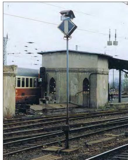
Mit Anstrahlleuchten beleuchtetes „Bügel-an“ (von der Rückseite „Bügel-ab“-) Signal mit Zuordnungstafel im November 1991 im Bahnhof Berlin Hbf
