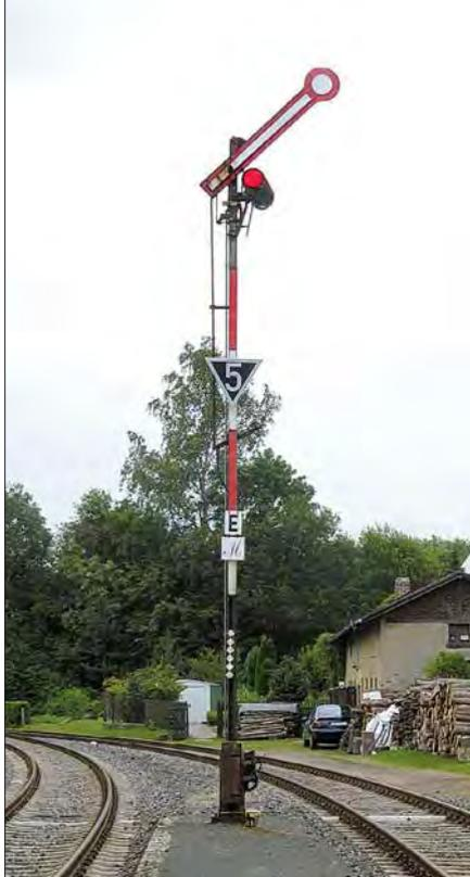
Das Foto zeigt gleich drei Zusatzsignale an einem Hauptsignal im Bahnhof Berthelsdorf (Erzgeb.) im Juli 2004. Oben ein Geschwindigkeitsanzeiger für 50 km/h (im Zusammenhang mit dem Signal Hp 2 nur auf Nebenbahnen zulässig), unter dem Mastbezeichnungsschild eine M-Tafel und darunter eine Rautentafel.
