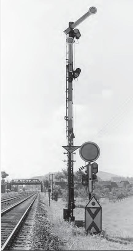
Das 10 m hohe Einfahrsignal des Bahnhofs Kreinsen mit Negativflügeln und einem bei der Einfahrt in das durchgehende Hauptgleis weggeklappten Signal Fw 101 (Vorläufer des Geschwindigkeitsanzeigers) sowie daneben das Ausfahrersignal im Juni 1952.
