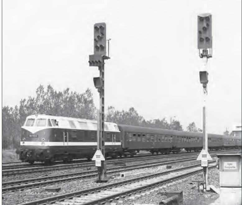
118 170-0 fährt am 18. Mai 1976 mit einem Schnellzug in den Bahnhof Trebbin ein. Im Vordergrund zwei HI-Signale mit roten Mastschildern für permissives Fahren und Wegübergangstafeln. Foto DR, Slg. SC
