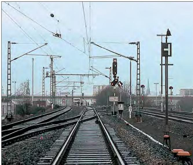
**Ts 1-Signal in Hamburg-Rothenburgsort im Dezember 1984.** Damit es wegen der in der Nähe stehenden Lichtsignale bei Nacht nicht übersehen wird, ist es mit einer Anstrahlleuchte ausgerüstet. Am Hauptsignal leuchten ein Richtungs- und ein Gleiswechselanzeiger auf, die anzeigen, dass die eingestellte Fahrstraße auf dem linken Streckengleis in Richtung Hgbf führt.
