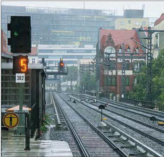
Zum Abschluss des Kapitels über Zusatzsignale zwei Fotos, auf dem eine Reihe dieser Signale zu finden sind. Das Bild links zeigt einen Geschwindigkeitsvoranzeiger für 50 km/h an einem Ks-Blocksignal am S-Bahn-Haltepunkt Savignyplatz im Berlin im Juli 2005. Im Hintergrund ein weiteres Signal mit dem angekündigten Geschwindigkeitsanzeiger.
