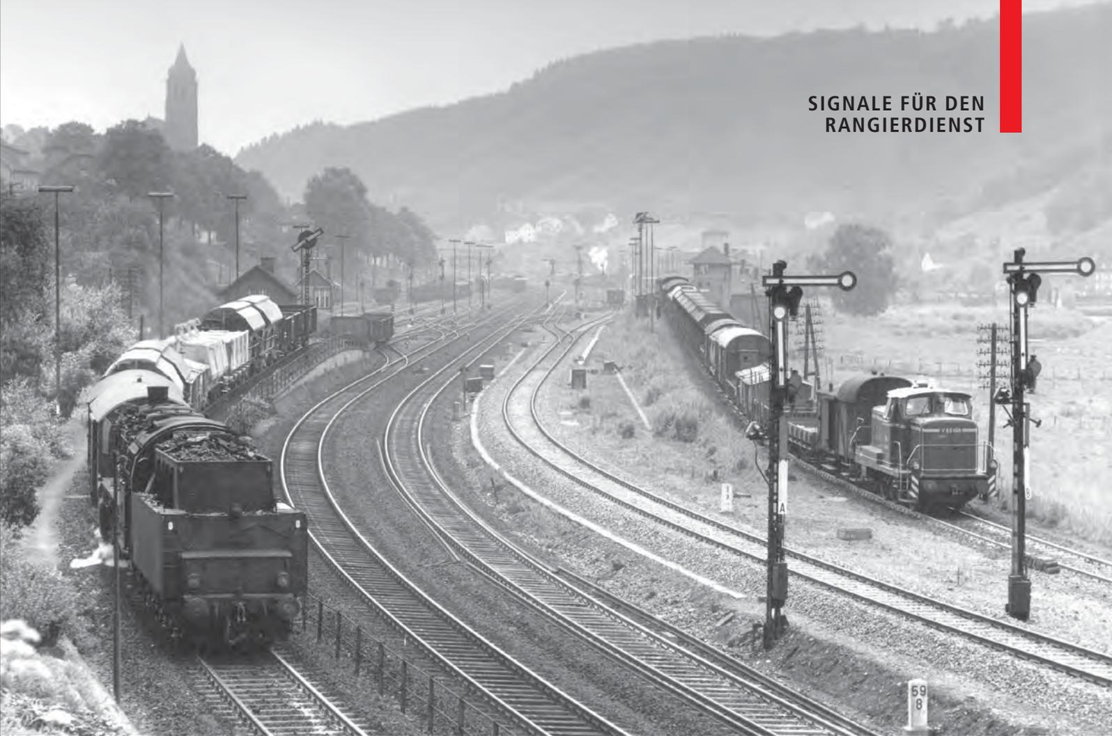
50 1132 und V60 450 rangieren im August 1961 im Bahnhof Finnentrop. Beide Abdrücksignale zeigen durch den schrägstellenden Balken „Langsam abdrücken“ an. Im Vordergrund die Einfahrsignale aus Richtung Hagen und Wennemen. Foto Ludwig Rotthowe
