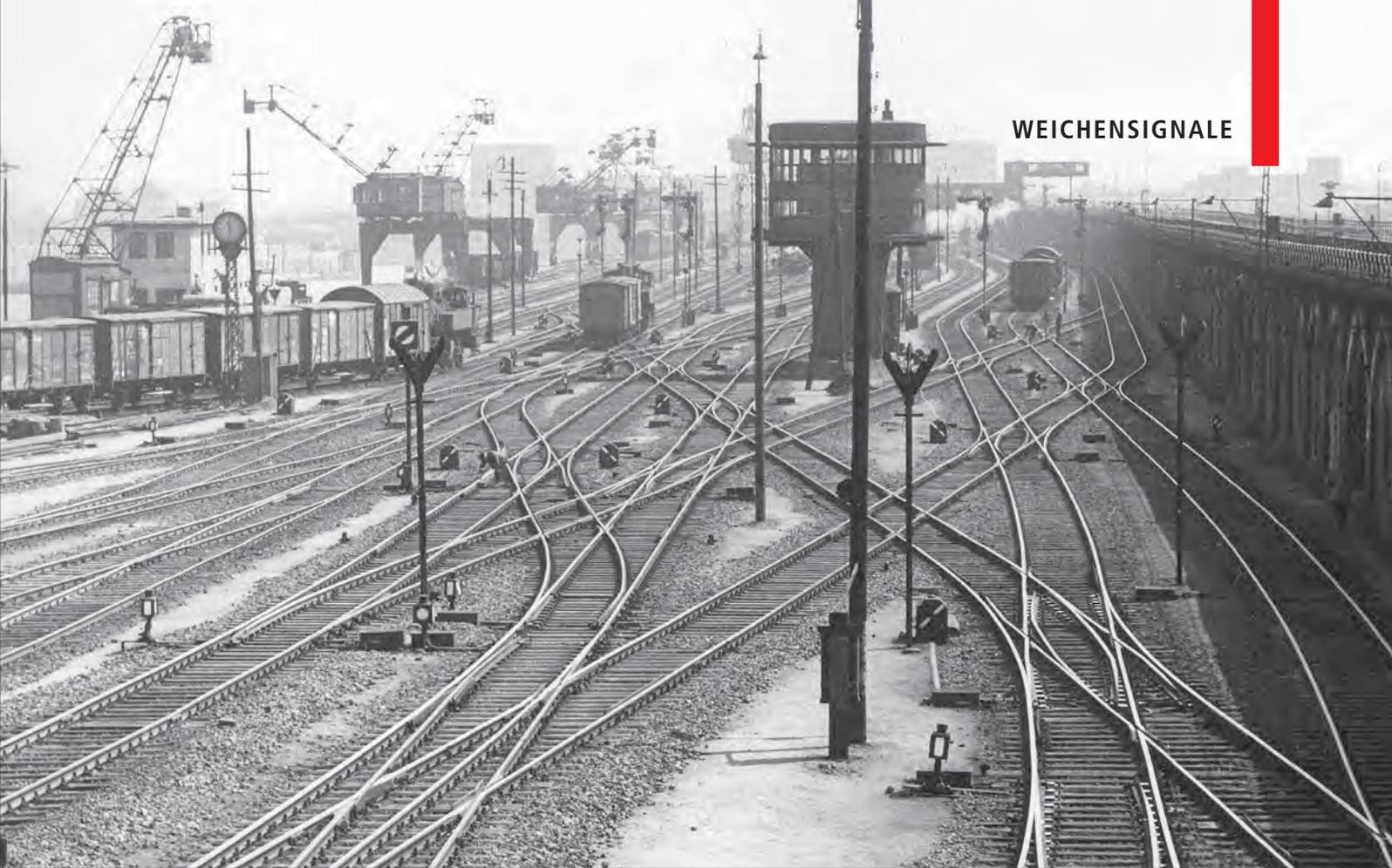
Bahnhof Hamburg Hgbf, ehemals Hannöverscher Bahnhof, im Jahr 1951. Im Hintergrund zwei rangierende Lokomotiven der Baureihe 91<sup>3</sup>. Von den Anlagen auf dem Bild – Stellwerke, Kräne, diagonal über den Bahnhof verlaufende, parallele Weichenverbindungen mit allein 14 auf dem Bild zu zählenden DKW – ist heute nichts mehr zu finden. Foto Hollnagel, Sammlung SC
