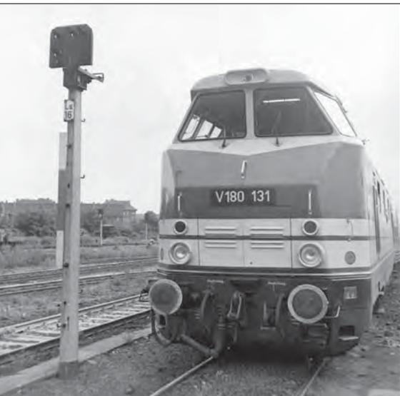
V 180 131 mit „Plastevorbau“ Neben der Lok ein DR-Lichtsperrsignal der WSSB-Bauform.
