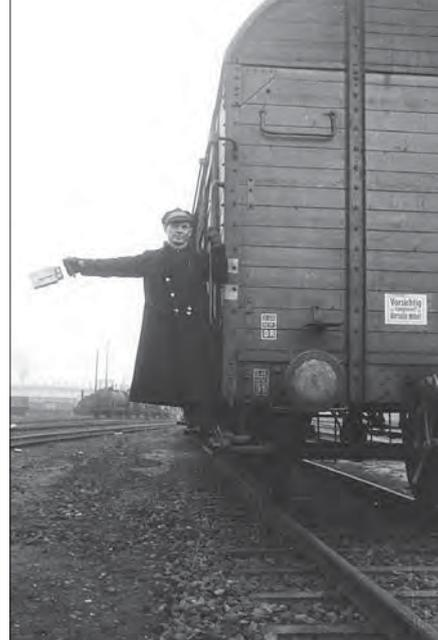
Mitte war. Bei Rangierabteilungen, bei denen die Lokomotive an einem Ende war, bedeutete das Signal Ra 1 bei der DRG „Ziehen“.
