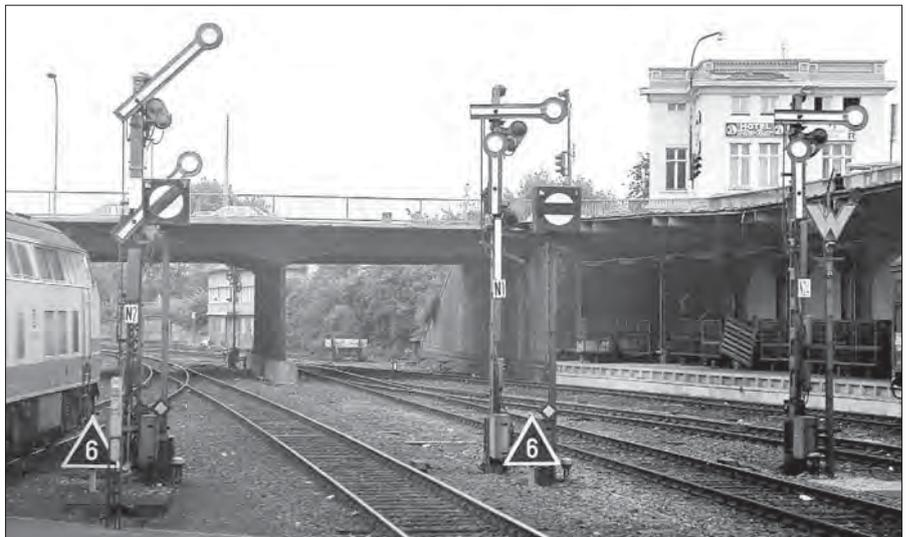
Vor den beiden linken Ausfahrtsignalen in Lübeck Hbf stehen Hauptsperrsignale sowie niedrige Geschwindigkeitsanzeiger; die Weichen in diesen Fahrstraßen lassen auch im abzweigenden Strang 60 km/h zu. Vor dem rechten Ausfahrtsignal kann auf ein Gleissperrsignal verzichtet werden, da es hier nicht zum Flankenschutz erforderlich ist. Seine Funktion für die Regelung der Rangierfahrten übernimmt hier ein Wartezeichen.
