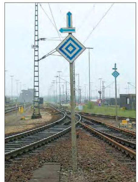
Reflektierende Ausführung des Signals „Halt für Fahrzeuge mit Stromabnehmern“ mit Richtungspfeilen nach links und für den geraden Strang für die im Hintergrund sichtbaren Weichen im Rbf Maschen im Juni 2004
