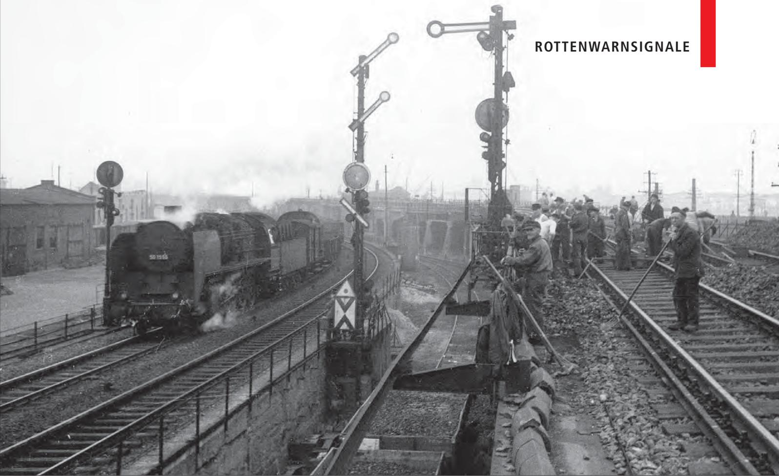
Bei Bauarbeiten im Gleisbereich ist – sofern die Gleise nicht gesperrt sind – die Warnung vor herannahenden Zügen unerlässlich. Das Foto zeigt den Wiederaufbau des Zollviadukts im Zuge der Hamburger Pfeilerbahn. Links auf dem Bild vom 24. Oktober 1948 nähert sich 50 1553 mit einem nordwärts fahrenden Güterzug auf den Gz-Gleisen von Hamburg Hgbf dem Hamburger Hbf. Foto Hollnagel, Sammlung SC
