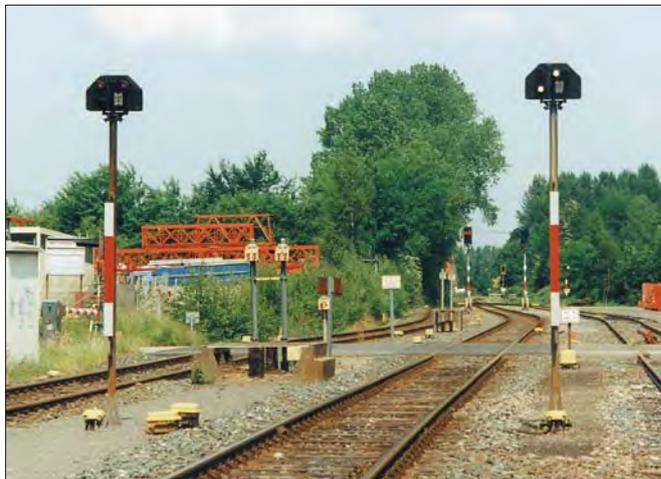
Tages- und Nachtzeichen **Ve 3** und **Ve 4** bzw. **Sh 0** und **Sh 1** von Formsperrsignalen unterschiedlicher Bauart
