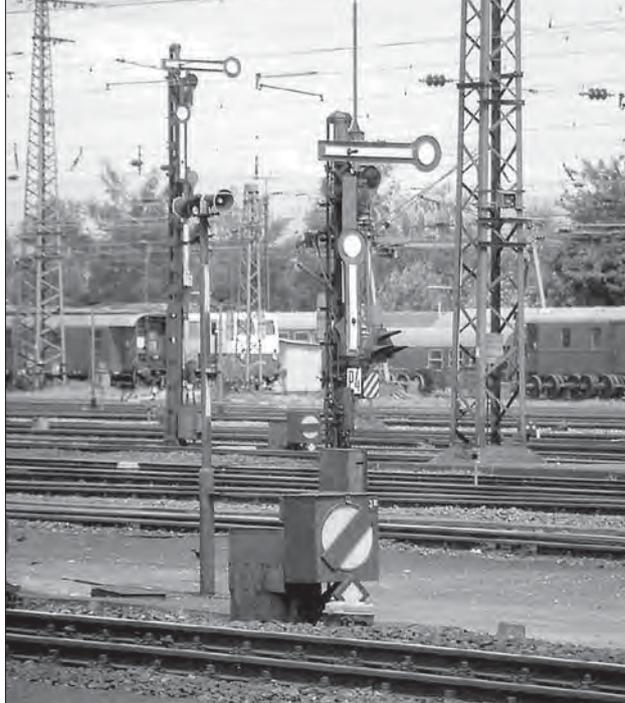
In Offenburg Hbf standen 1981 kleine Gleissperrsignale, um die Signalsicht auf die wegen der Bahnsteigdächer niedrigen Hauptsignale nicht zu behindern (wobei vor dem Signal im Bildhintergrund auch ein hohes Signal hätte aufgestellt werden können). Für die von der Regelzeichnung abweichende Anbringung der Rückstrahlschilder unterhalb des Signals gibt es allerdings keinen zwingenden Grund.
