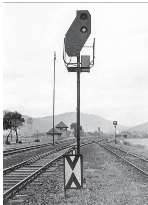
Rechts: Lichtvorsignal der DRG-Bauform 1943 im ÖBB-Bahnhof Niklasdorf. Ähnlich wie bei der DR, sah die Signalordnung der ÖBB für Vorsignale Signaltypen mit nur einem gelben oder grünen Licht für die Begriffe „Halt erwarten“ bzw. „Fahrt erwarten“ vor. Foto Pfeiffer, Slg. Heless
