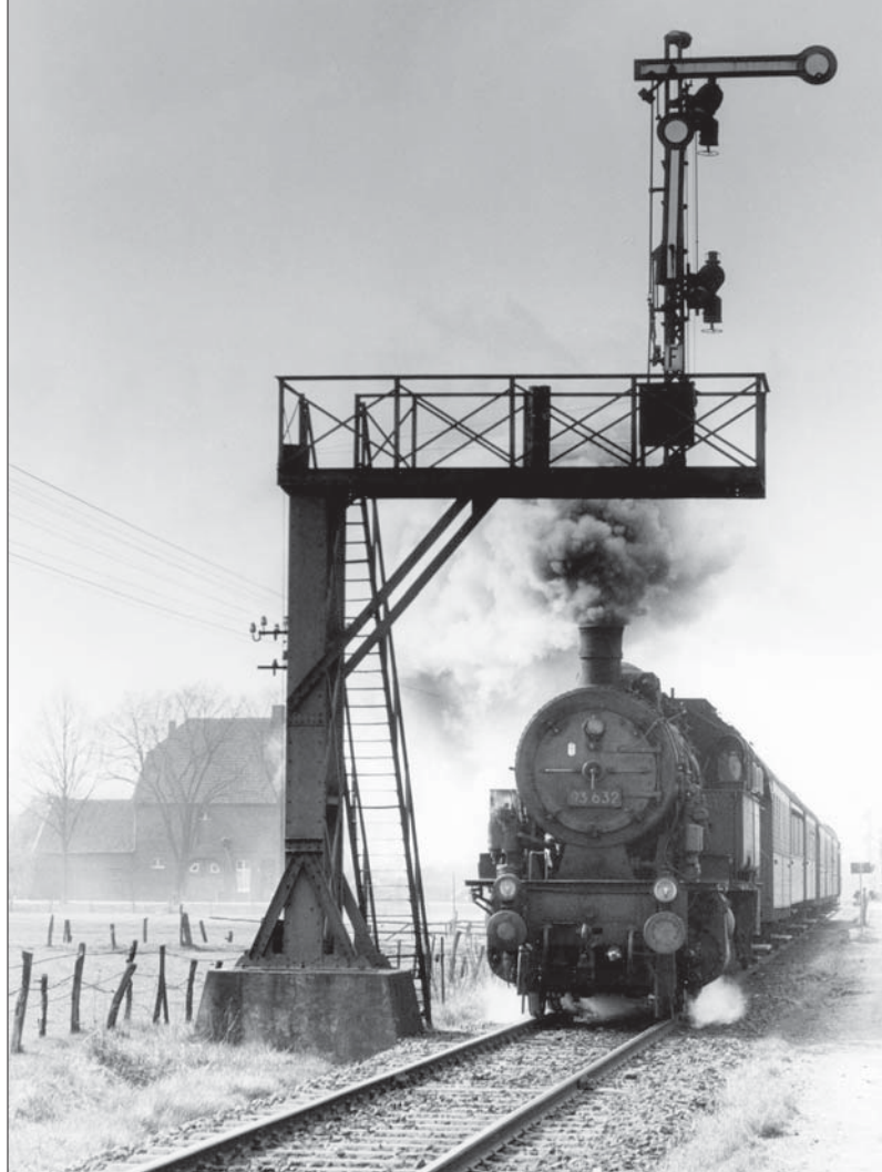
Da in Telgte dicht neben der Bahnstrecke eine Straße verläuft, konnte das Einfahrsignal hier nicht rechts aufgestellt werden. Um die Linksstellung zu vermeiden, baute die Preußische Staatsbahn einen Signalausleger. Das Foto vom April 1957 zeigt einen von 93 632 gezogenen, nach Warendorf fahrenden Personenzug. Foto Ludwig Rotthowe
