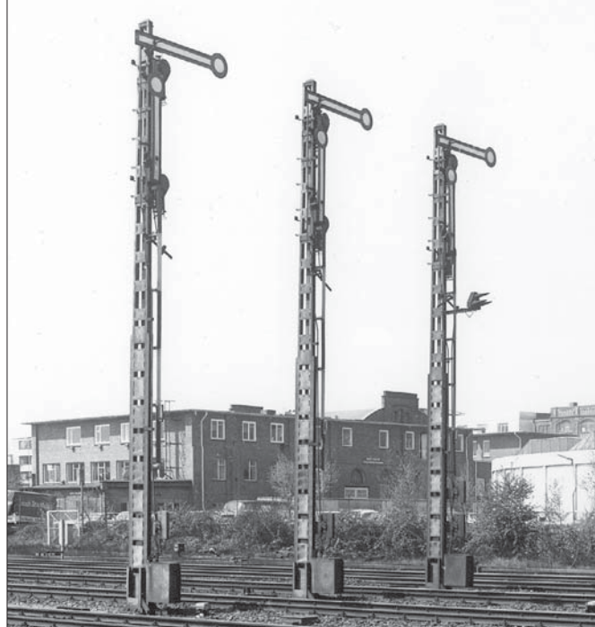
Rechts: Geschweißte, 10 m hohe Schmal-mast-Signale in Hamburg-Wandsbek im Sommer 1977. Die beiden linken Signale haben gekuppelte Flügel, das rechte ist ungekuppelt und kann sowohl Hp 1 als auch Hp 2 zeigen.
