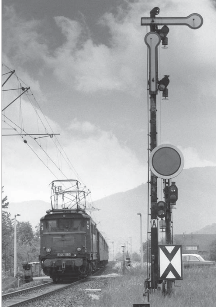
E 44 1180 verlässt im Mai 1967 mit einem Personenzug nach Basel den Bahnhof Fahrnau. Das Einfahr- und Ausfahrsvorsignal für die Gegenrichtung sind ebenfalls beide badischen Ursprungs. Fotos Ludwig Rotthowe
