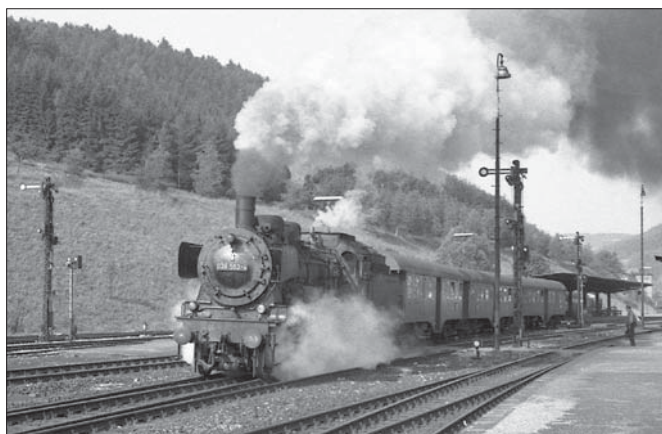
Nicht immer lassen sich Ausfahrtsignale in einer Reihe aufstellen. Das Bild aus Horb zeigt den von 038 553-4 geführten P 4135 nach Freudenstadt, der am 14. Juli 1971 den Bahnhof in Richtung Eutingen verlässt. Links ein Ausfahrtsignal an der Strecke nach Tübingen.
