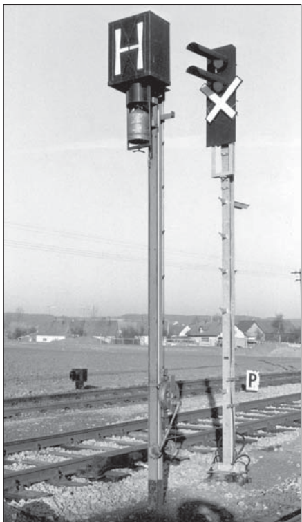
Die 1972 neuentwickelten Nebenbahnlicht-signale als Betriebsversuch auf der Strecke Neufahrn–Straubing im Bf Laberweiting. Vor den noch ungültigen Lichtsignalen stehen die alten Haltetafeln. Foto Gerhard Scholtis
