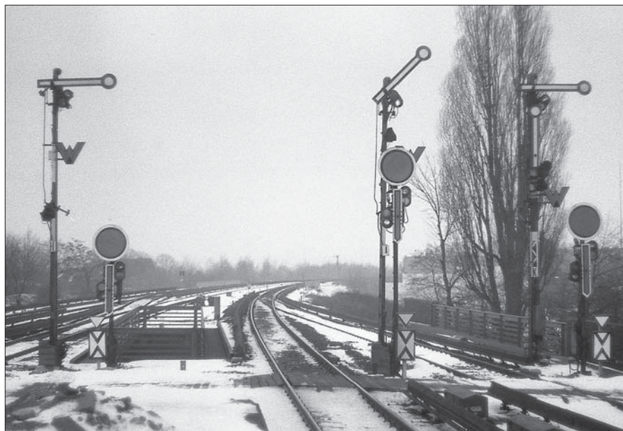
Niedrige und hohe Vorsignale im Dezember 1979 im Bf Hamburg-Bergedorf. Im Ostkopf des Bahnhofs (Bild links) erforderte dies 10 m hohe Hauptsignale, da andernfalls der untere Signalflügel durch das Vorsignal tw. verdeckt gewesen wäre. In der westlichen Ausfahrt stand ein hohes Vorsignal nur vor einem einflügeligen Ausfahrtsignal, sodass hier 8 m hohe Signalmaste ausreichend waren. Beachtung verdienen auch die Wartezeichen (im Ostkopf mit Vorrücksignal, auf der Westseite ohne Sh 1-Signal), die an den Hauptsignalmasten angebracht waren.
