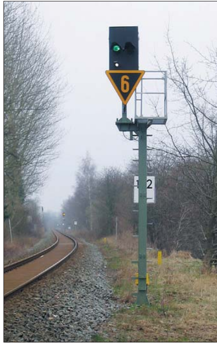
Vorsignalwiederholer vor dem Bahnhof Bad Segeberg im März 2005. Unter dem Signalschirm ist ein Geschwindigkeitsvoranzeiger, das Signal Ks 1 blinkt daher.
