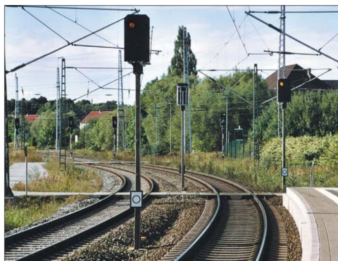
Auch die Vorsignalwiederholer in Rostock Hbf sind neu aufgestellt, zu erkennen an den verzinkten Arbeitsplattformen.
