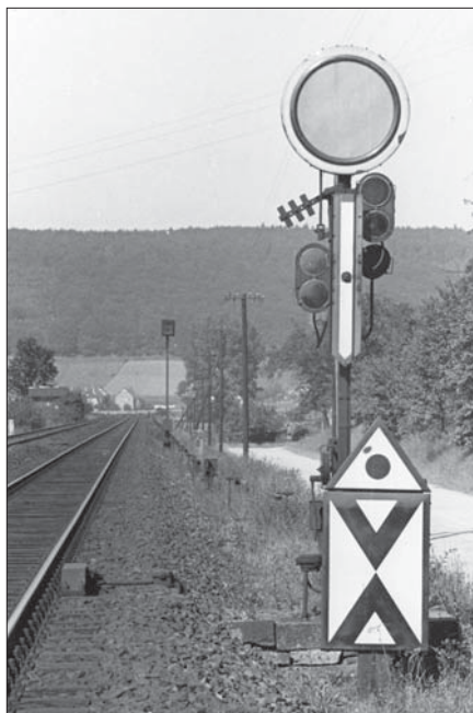
Das elektrisch beleuchtete Einfahrsvorsignal des Bahnhofs Kreiensen im Juli 1952. Zum Anzeigen des Signalbegriffs Vz 3 hat es keinen Spiegelkasten, sondern eine separat anschaltbare dritte Lampe. Foto Bustorff, Slg. SC
