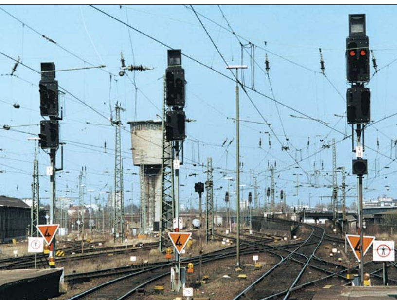
Ausfahrtsignale des Bahnhofs Hamburg-Altona im April 2004. Alle Signale besitzen Vorsignale und sind mit Richtungsanzeigern ausgerüstet. Die Abfahrtauftrags-signale haben „Ampelgehäuse“. Vor den Hauptsignalen stehen Lf-Signale zur Ankündigung einer Langsamfahrstelle im nachfolgenden Gleisabschnitt.
