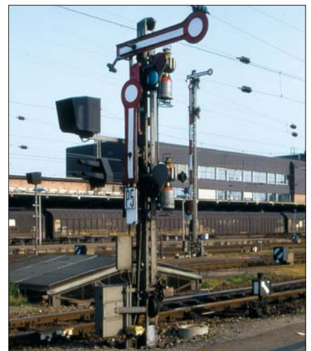
Niedriges Ausfahrtsignal mit Ersatzsignal und Abfahrtrafagsignal sowie 12 m hohes Signal im Hintergrund im Juli 1982 im Bahnhof Offenburg. Foto Günter Berg
