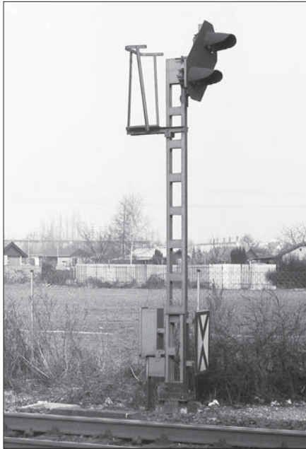
Links: Auch dieses bei Mannheim stehende Vorsignal der Bauform 1951 weicht in den gleichen Details von der Ursprungsform ab (längere Schuten sowie abweichendes Mastoberteil und geänderte Arbeitsplattform). Foto Günter Berg
