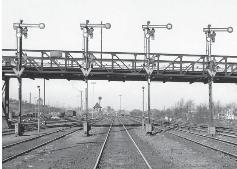
Zwischensignale im Rbf Hamburg-Harburg im März 1959. Alle Signale besitzen Schalmaste für die Aufstellung bei 4,50 m Gleisabstand und sind mit Wartezeichen mit Vorrücksignalen ausgerüstet. Foto Hollnagel, Sammlung SC
