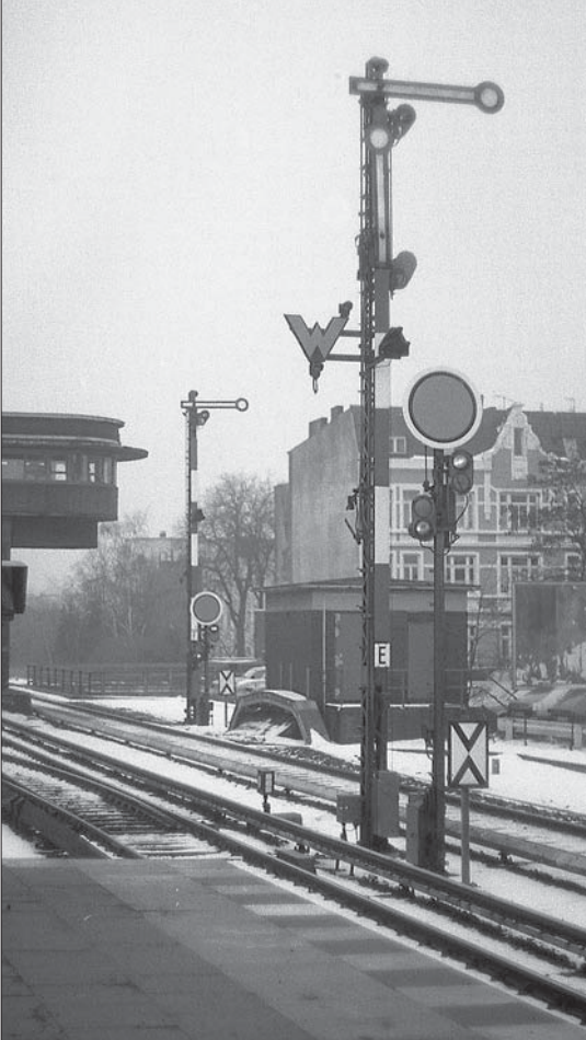
Niedrige und hohe Vorsignale im Dezember 1979 im Bf Hamburg-Bergedorf. Im Ostkopf des Bahnhofs (Bild links) erforderte dies 10 m hohe Hauptsignale, da andernfalls der untere Signalflügel durch das Vorsignal tw. verdeckt gewesen wäre. In der westlichen Ausfahrt stand ein hohes Vorsignal nur vor einem einflügeligen Ausfahrtsignal, sodass hier 8 m hohe Signalmaste ausreichend waren. Beachtung verdienen auch die Wartezeichen (im Ostkopf mit Vorrücksignal, auf der Westseite ohne Sh 1-Signal), die an den Hauptsignalmasten angebracht waren.
