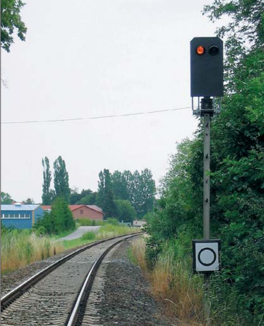
HI 10 „Halt erwarten“ an einem Vorsignalwiederholer vor dem Einfahrsignal des Bahnhofs Malchin im Juli 2004
