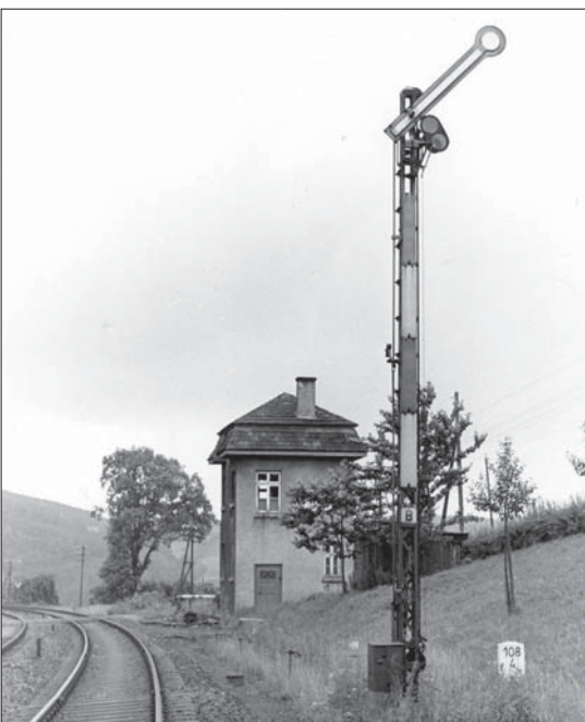
Zweimal die Blockstelle Poppenburg (bei Kreiensen) im Juni 1952. Während der markante Baum auf dem linken Bild 1976 noch stand, gehören die Blockstelle und der Bahnübergang längst der Vergangenheit an. Die Signale hatten damals noch Petroleumbeleuchtung. Fotos Bustorff, Sammlung SC
