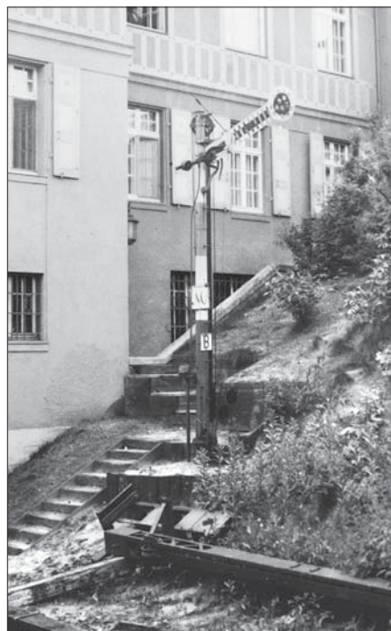
Das auf einem Podest neben dem Gleis stehende Blocksignal der S-Bahn-Haltestelle Pichelsdorf hatte die typischen Merkmale der von Siemens & Halske gebauten Signale. Foto Kroll, Sammlung Hermann Hoyer
