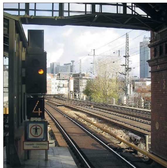
Wegen der dichten Zugfolge und kurzer Durchrutschwege auf der Berliner S-Bahn haben viele Ks-Signale zusätzlich Geschwindigkeitsanzeiger. Das Bild entstand ebenfalls im November 2004 am Hackeschen Markt.
