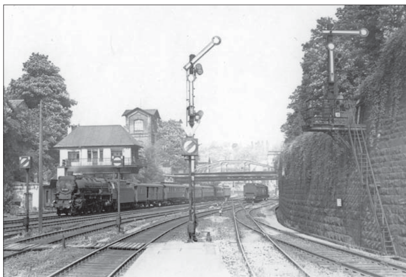
01 1066 im Jahr 1950 mit D 32 in Wuppertal Hbf. Weil zwischen Gleis und Stützmauer der Platz für ein Signal nicht ausreichte, ist an der Mauer ein Ausleger montiert. Foto Bellingrodt, Slg. Gerd Neumann
