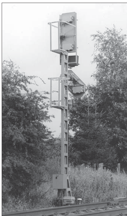
Rückansicht des Einfahrsignals des Bahnhofs Tornesch im September 1991 (mit einem von der Regelform abweichenden Schaltkasten)
