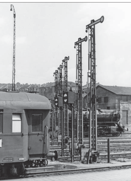
Ausfahrtsignale des Bahnhofs Büchen in Richtung Schwanheide im Juni 1983. Am durchgehenden Hauptgleis (rechts) steht ein einflügeliges Signal mit Gittermast, an den Güterzuggleisen gekuppelte Schmalmastsignale.
