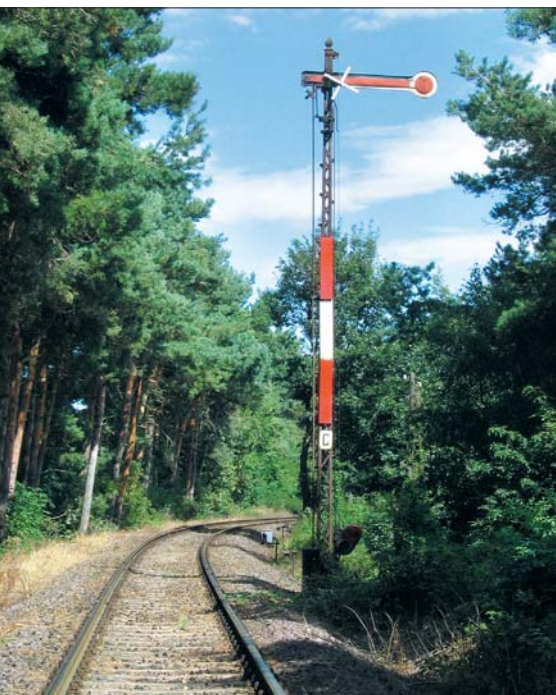
Drei Signale preußischen Ursprungs mit Negativflügeln: Das Deckungssignal am Abzweig Süplingen. Im August 2004 waren die Drahtzugleitungen gekappt und das Signal als ungültig gekennzeichnet. Foto Niels Kunick
