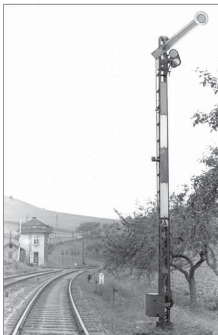
Zweimal die Blockstelle Poppenburg (bei Kreiensen) im Juni 1952. Während der markante Baum auf dem linken Bild 1976 noch stand, gehören die Blockstelle und der Bahnübergang längst der Vergangenheit an. Die Signale hatten damals noch Petroleumbeleuchtung. Fotos Bustorff, Sammlung SC
