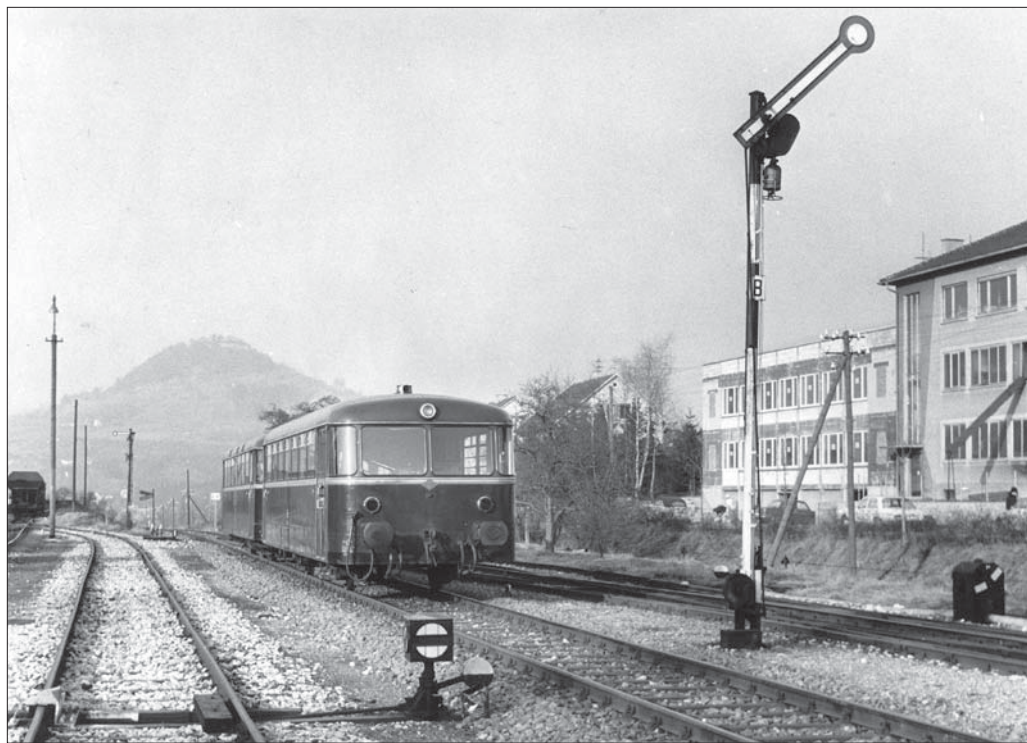
Ein Schienenbus verlässt am 7. Februar 1969 den Bahnhof Pfullingen. Während das Einfahrtsignal im Bildhintergrund ein Signal der Einheitsbauart ist, ist das Ausfahrtsignal noch württembergischen Ursprungs. Foto Herbert Stemmler
