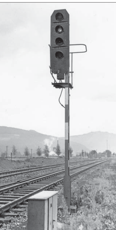
Links und oben Mitte das der Bauform 1943 entsprechende Einfahrtsignal des Bahnhofs Niklasdorf. Foto Pfeiffer, Slg. Heless. Oben rechts ein Ausfahrtsignal des Bahnhofs Wien-Hütteldorf im August 1964. Foto Hermann Heless
