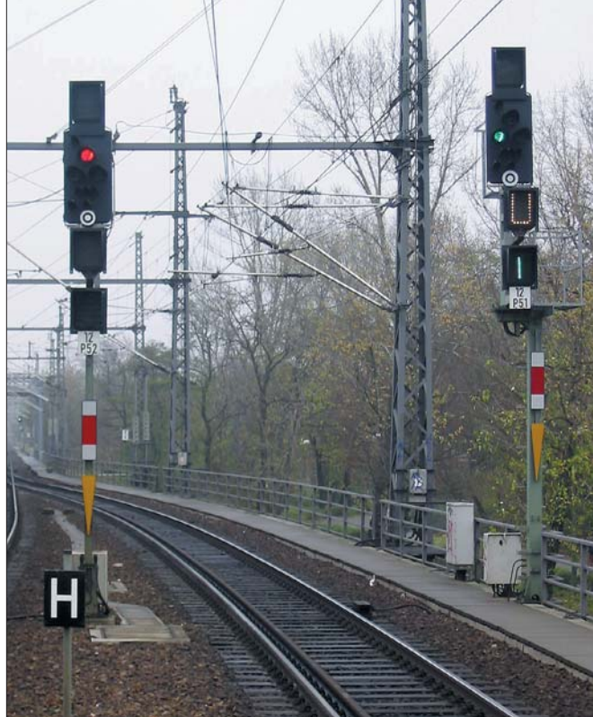
Ks-Signale im November 2004 im Bf Berlin-Zoo. Beide Mehrabschnittssignale, das rechte hat einen Mast mit kleinem Ausleger, sind mit drei Zusatzanziegern ausgerüstet. Rechts leuchten die Signale Ks 1, ein Richtungsanzeiger und der Abfahrtauftrag auf.
