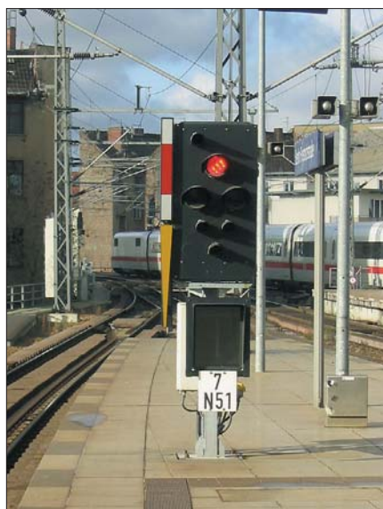
Hinter Bahnsteigdächern müssen häufig besonders niedrige Signale aufgestellt werden. Das Bild zeigt ein solches Mehrabschnittssignal mit einem Aufsetzmast im November 2004 im Bahnhof Berlin-Friedrichstraße.
