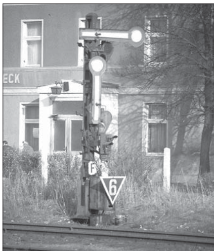
Ausfahrtsignal des Bahnhof Haldensleben im Oktober 1977. Auch hier war, um die Sichtbarkeit trotz eines Bahnsteigdachs zu gewährleisten, ein Zwergsignal erforderlich.
