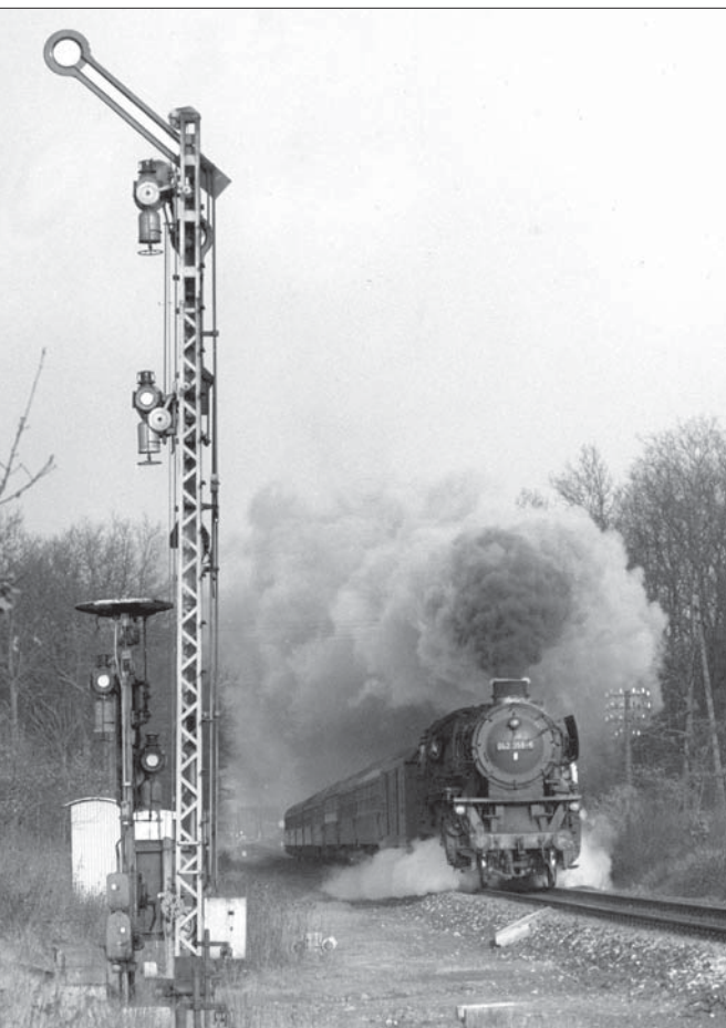
Zwischensignale im Rbf Hamburg-Harburg im März 1959. Alle Signale besitzen Schalmaste für die Aufstellung bei 4,50 m Gleisabstand und sind mit Wartezeichen mit Vorrücksignalen ausgerüstet. Foto Hollnagel, Sammlung SC
