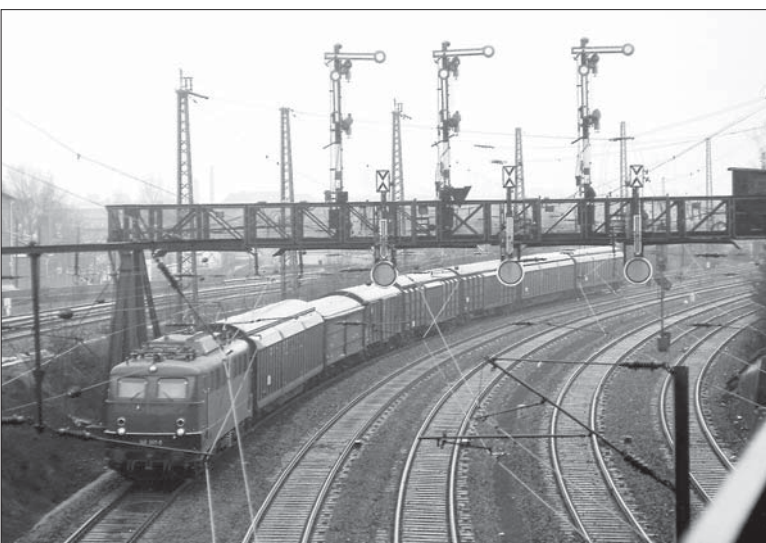
Etwa 1000 m weiter nördlich als die oben abgebildete Signalbrücke überspannt diese Konstruktion die Gleise der Strecke Hamburg–Kiel. 1984 trug sie ebenfalls Formsignale, heute sind es Lichtsignale.
