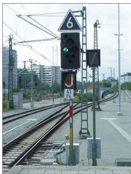
Ks-Mehrabschnittssignal mit Geschwindigkeits- und Richtungsanzeiger – „J“ für Richtung Giesing – im September 2004 im Bahnhof München-Ostbahnhof. Foto A. Lindner
