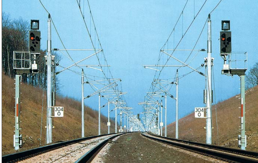
Während heute bei den Ks-Signalen an der freien Strecke in der Regel Auslegermaste aufgestellt werden, erfolgte dies bei den Kompaktsignalen nur an Neubaustrecken, wie hier an der Strecke Hannover–Würzburg bei Rohrach (1990). Foto DB
