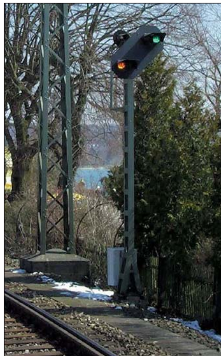
Vorsignalwiederholer der Einheitsbauform im März 2004 im Bahnhof Starnberg. Foto Alexander Lindner
