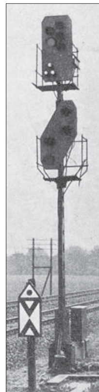
Teilweise retuschierte Fotos der Signale an der Strecke Düsseldorf–Duisburg: Links im Ursprungszustand mit aufleuchtendem Ersatzsignal, rechts in der Form ab 1943.
