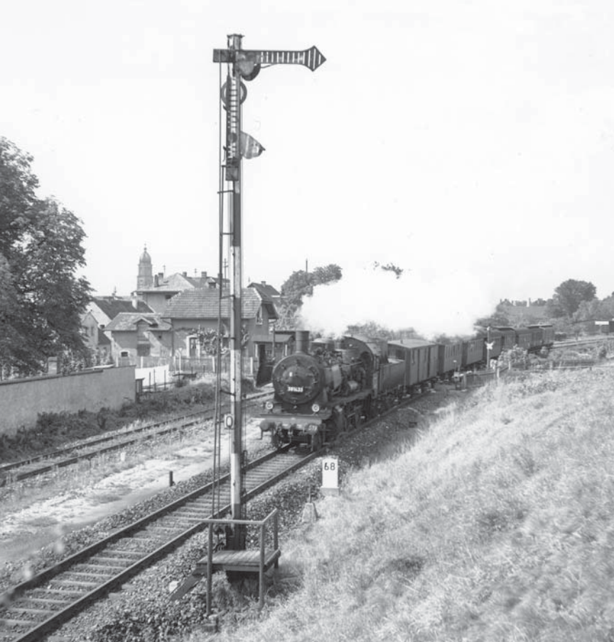
Das zweiflügelige Einfahrsignal des Bahnhofs Amberg aus Richtung Schwandorf besaß einen 10 m hohen Mast. Das Foto aus dem Sommer 1954 zeigt 38 1433 vom Bw Schwandorf mit einem Personenzug. Foto Gottfried Turnwald
