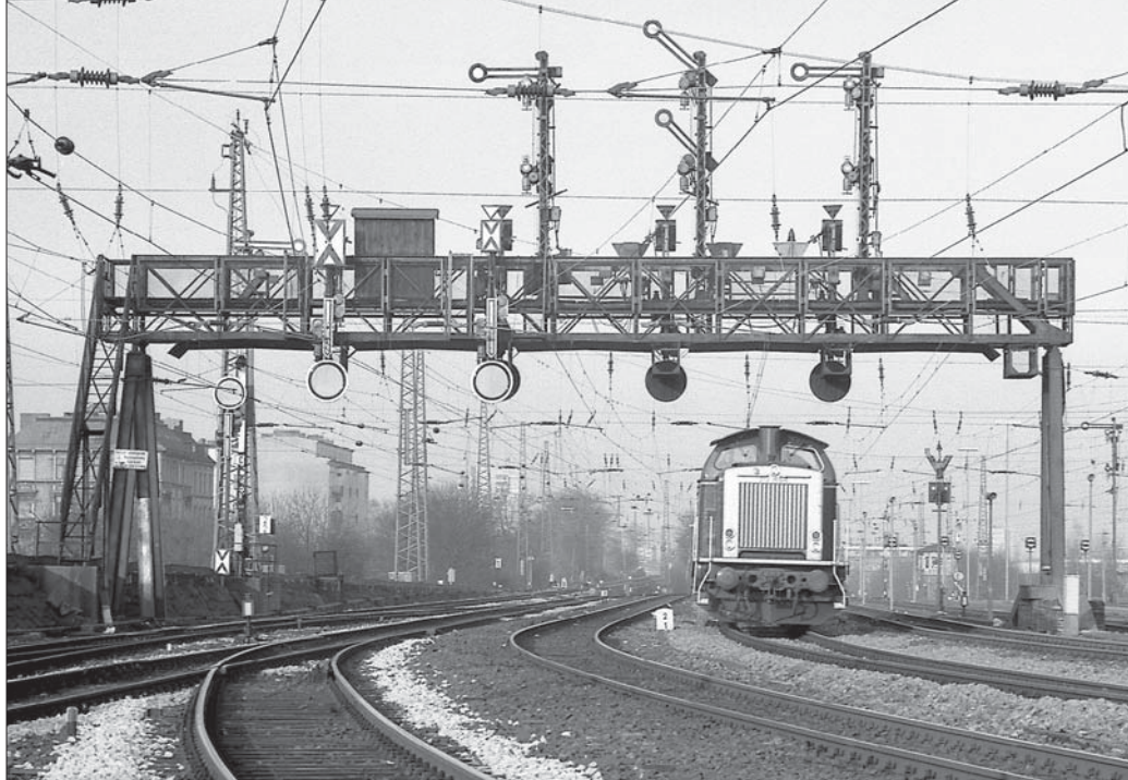
212 155-6 unter einer Signalbrücke im Bahnhof Hamburg-Altona im November 1984. Als Berührungsschutz wurde das Geländer der Signalbrücke im Zuge der Elektrifizierung mit einem engmaschigen Gitter versehen.
