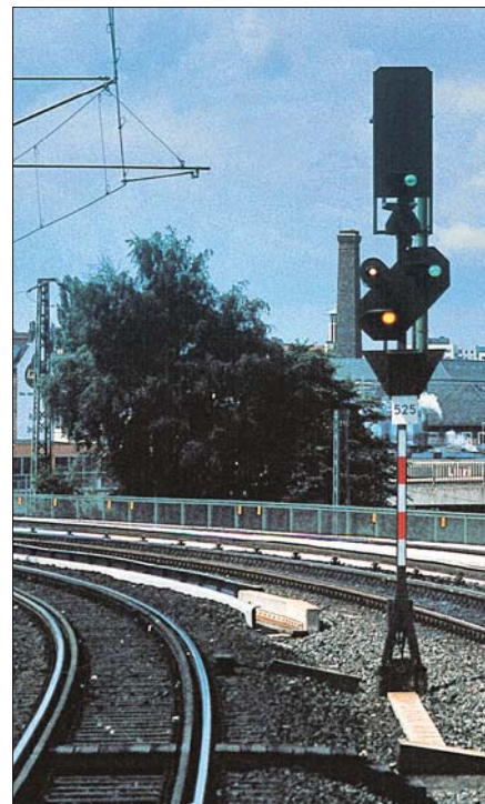
Hp 1 und Vr 2 an einem Selbstblocksignal auf der Hamburger Verbindungsbahn zwischen dem Abzweig Rainweg und Hamburg-Altona im Juli 1991. Das im verkürzten Bremswegabstand stehende Vorsignal kündigt das Einfahrtsignal des Bahnhofs Hamburg-Altona an.
