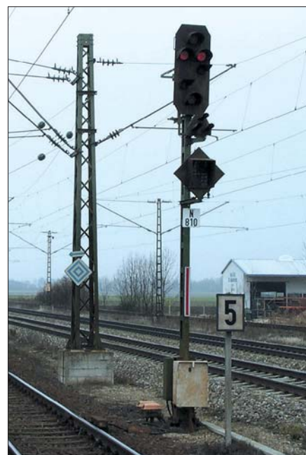
Links: Ausfahrsignale des Bahnhofs Gablingen im Februar 2005. Am Gleis der Gegenrichtung ist ein Kompaktsignal aufgestellt. Im Hintergrund sind die Geschwindigkeitssignale mit der Kennziffer 20 aufgestellt, die für die Fahrt aus dem Überholungs-gleis von Bedeutung sind.
