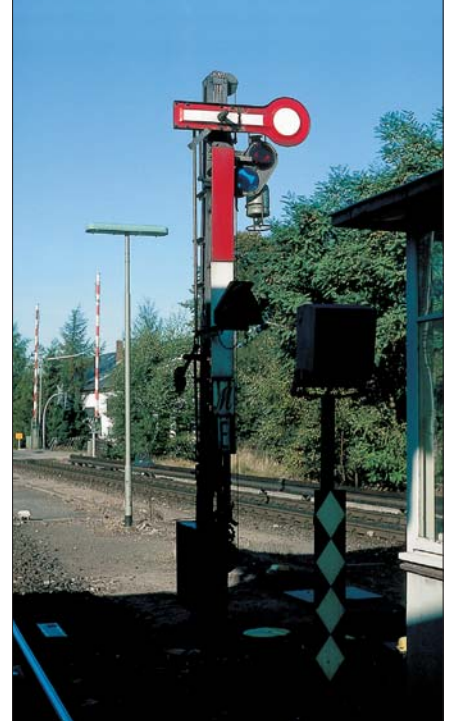
Kürzer gehts nicht: Das Ausfahrtsignal der S-Bahn-Station Sülldorf wurde auf ein Mindestmaß gekürzt, damit es hinter dem unmittelbar davorstehenden Bahnsteigdach zu erkennen ist. Auf dem Foto vom Juli 1983 sind deutlich die Roststellen an der Schweißnaht zu erkennen.
