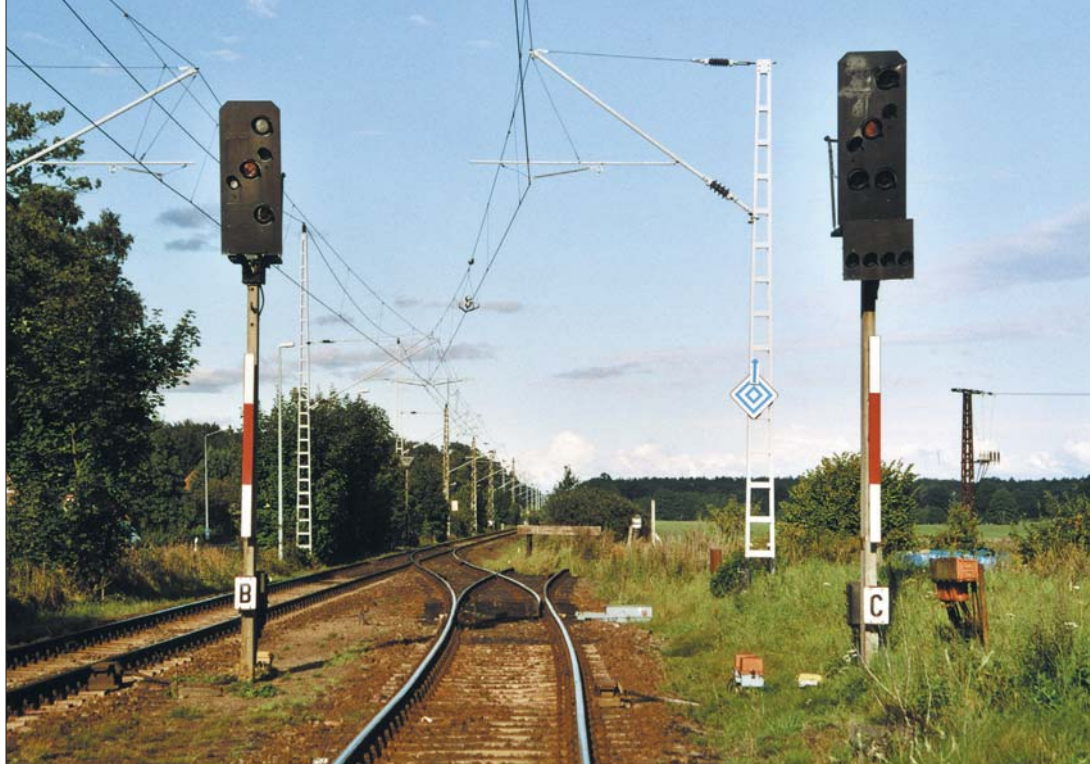
Zwei HI-Signale der WSSB-Einheitsbauform an der Strecke Rostock-Wismar als Ausfahrssignale des Bahnhofs Gelbensande im September 2005. Da die Ausfahrssignale keine Vorsignalfunktion haben, kann das linke nur Hp 0 und HI 1 sowie Ra 12 anzeigen. Das rechte Signal am Überholungsgleis zeigt in der Fahrtstellung HI 3b.
