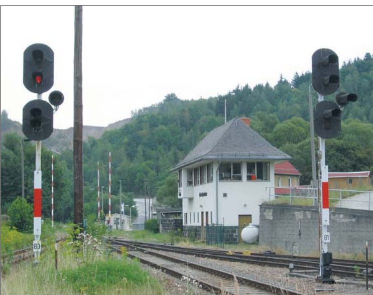
Links: EZMG-Ausfahrtsignale des Bahnhofs Loitsch-Hohenleuben im August 2004. Das linke Signal kann Hp 0, HI 3 sowie Hp 0 zusammen mit dem Rangierfahrtsignal anzeigen, das rechte Hp 0, HI 1 und Rangierfahrtsignal.
