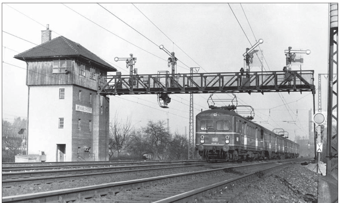
Die Signalbrücke am Bk Karlshöhe bei Ludwigsburg mit 465 007-3 am 15. Dezember 1972. Damit bei Nacht die Lichter der Häuser im Hintergrund die Signalbilder nicht stören, sind hinter den Laternen der beiden rechten Signalen (helle) Tafeln zur Abschirmung montiert. Foto Herbert Stemmler
