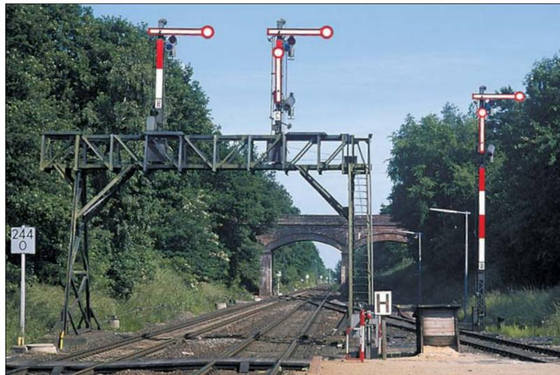
Erst nach dem Zweiten Weltkrieg gebaut: Die Signalbrücke im Bahnhof Müssen, im Juni 1973 fotografiert. Erforderlich wurde die Signalbrücke, da das 2. Gleis abgebaut und damit das linke Gleis zum durchgehenden Hauptgleis wurde und außerdem der Platz zwischen den Gleisen für die Aufstellung eines Signals nicht ausreichte.
