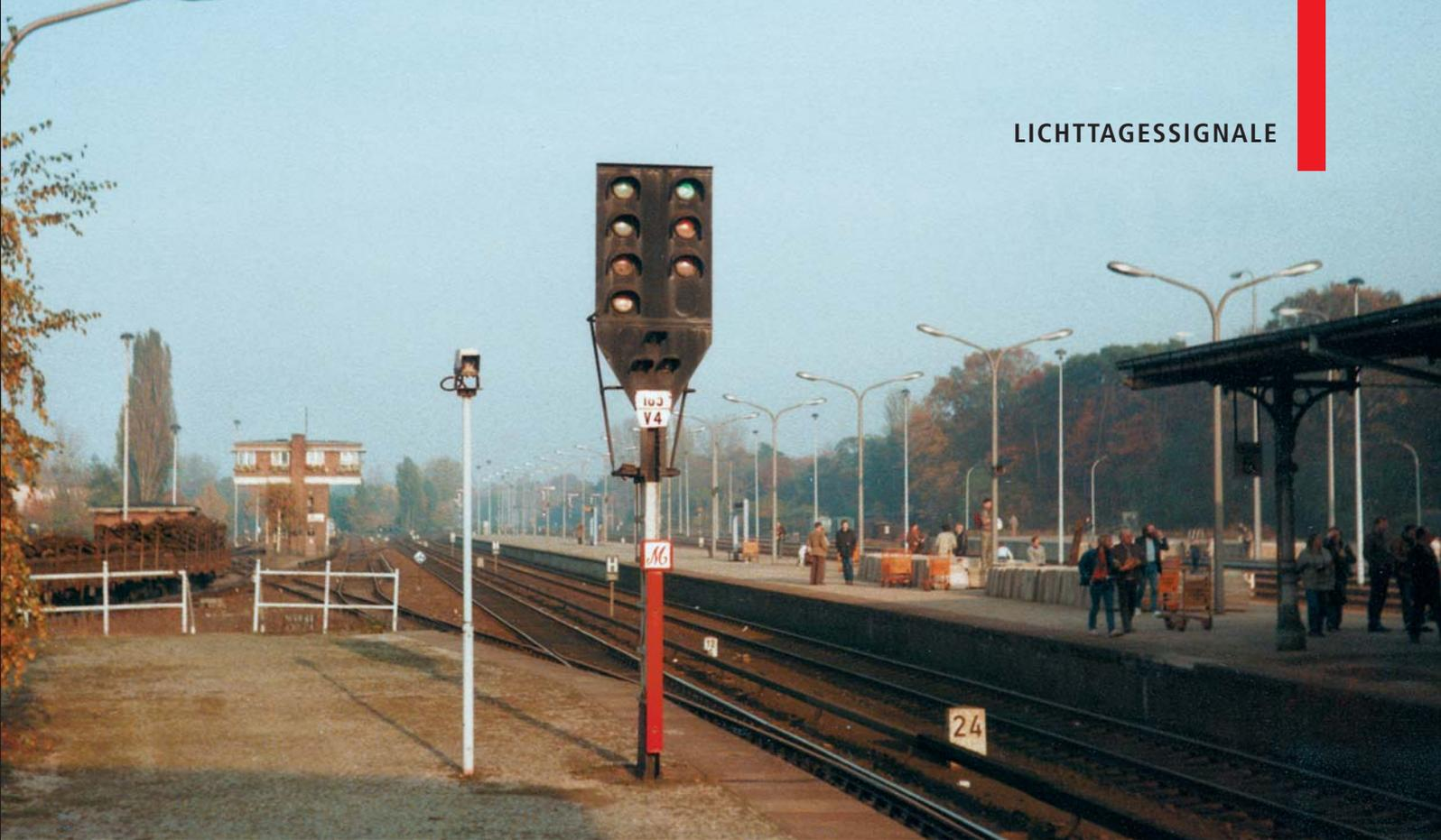
Reichsbahn-Atmosphäre in den 80er Jahren. Sv-Signal der Bauart O&K nahezu mit Maximalbestückung: Sieben Lampen in vier Reihen und Ersatz-/Rangiersignal. Das rote Mastschild, das bei Störung die Vorbeifahrt und „permissives Fahren“ gebietet, ist eine spätere Zutat. Das Foto entstand im November 1984 im Bahnhof Berlin Wannsee. Foto Alexander Lindner
