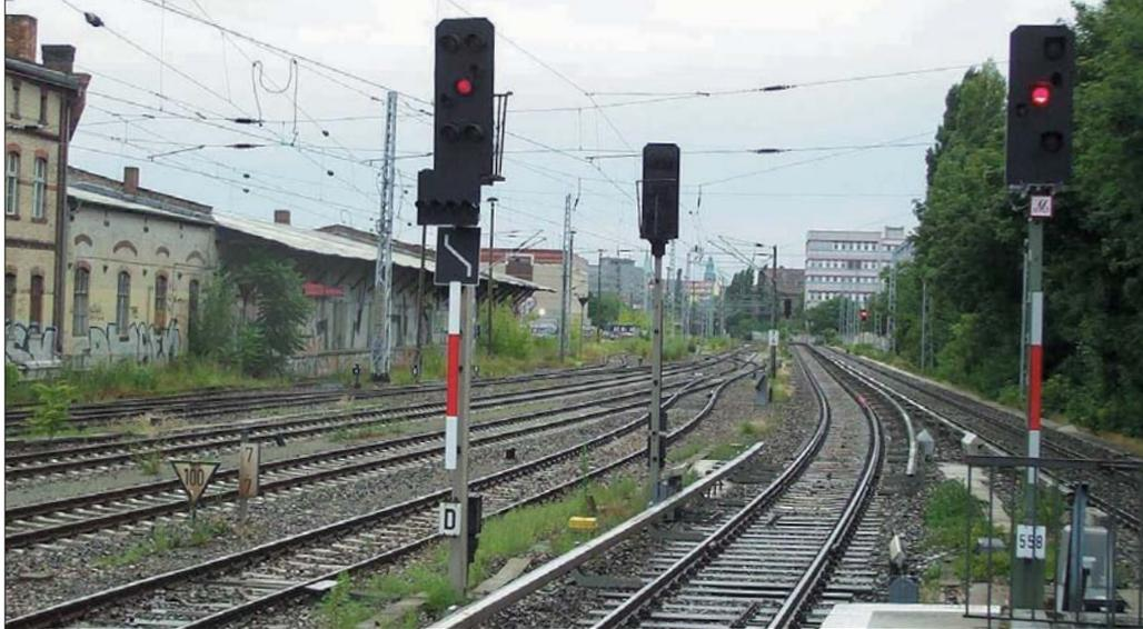
Da der Fahrweg hinter dem links stehenden HI-Signal stets ins Gegengleis führt, ist er mit einer Gleiswechselanzeiger-Tafel ausgerüstet, Berlin Greifswalder Straße, Juli 2003.
