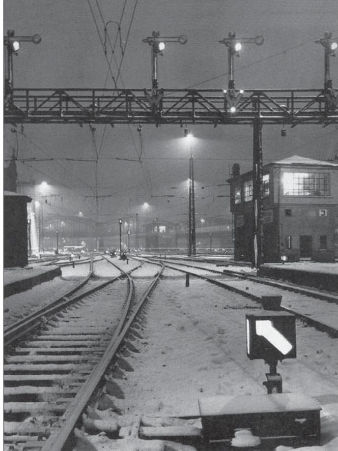
München Hbf um 1950: Im Vordergrund die heute noch gebräuchliche Bauform der Weichensignale, die 1907 in das Signalbuch aufgenommen wurde. Beachtung verdient die Signalbrücke mit Signalen bayerischer Bauform, jedoch mit der Einheitsbauart entsprechenden Flügeln, und die hohen Sperrsignale preußischer Bauform. Sammlung SC
