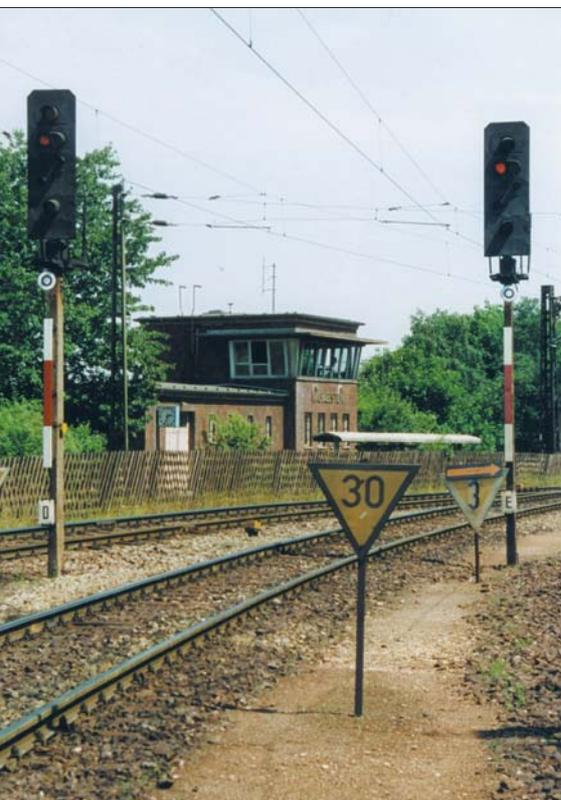
HI-Signal der 1962 entwickelten Ursprungsbauforn mit Doppellaternen im Juli 1972 im Bahnhof Michaelstein. Im Vordergrund eine (weiße) Geschwindigkeitstafel für 30 km/h. Außerdem stehen unmittelbar vor den Signalen Langsamfahrtafeln, die mit dem 1971 eingeführten Richtungspfeil auch für die Strecke nach Rübeland eine La 30 ankünden. Fotos Niels Kunick
