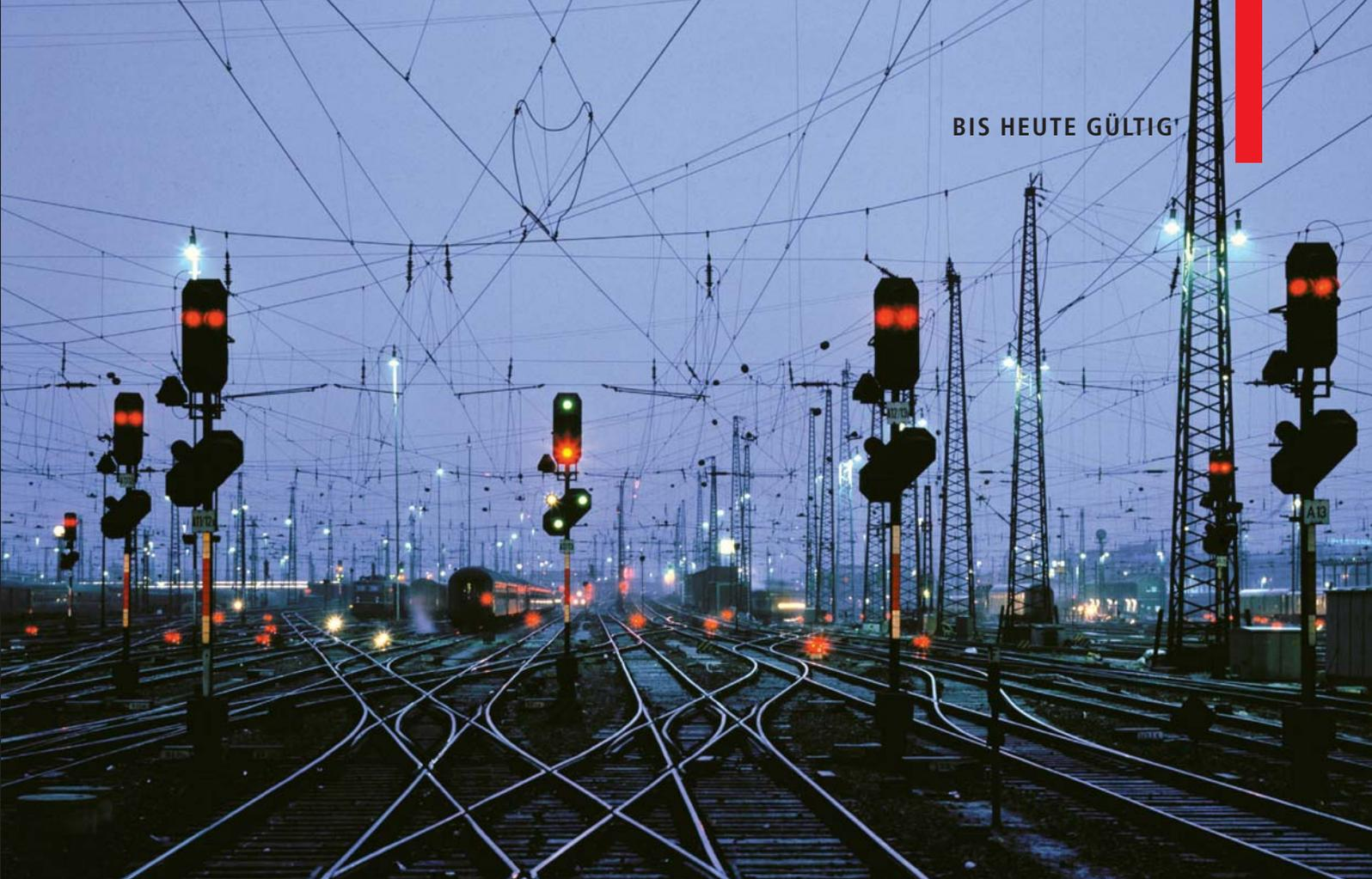
Lichtsignale der Bauform 1951 im Gleisvorfeld des Bahnhofs Frankfurt (M) Hbf im Jahr 1979 fotografiert, die Halt zeigenden Hauptsignale zeigen das Signalbild Hp 00. Foto DB AG
