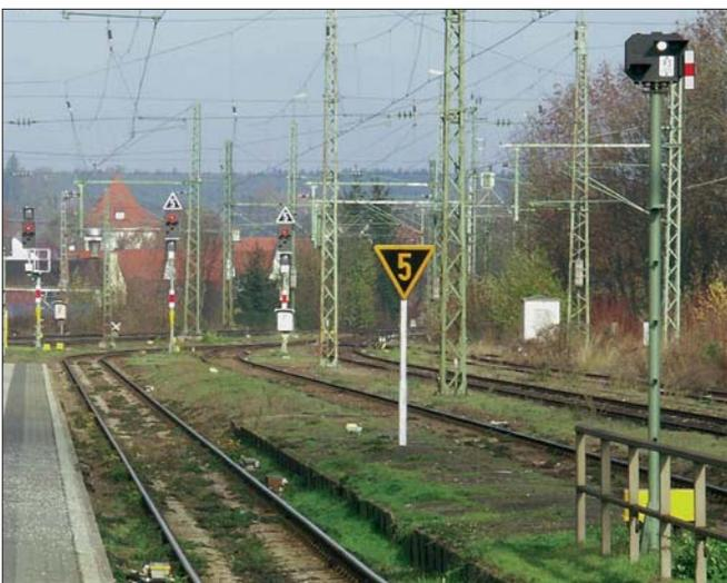
Links: Im Zusammenhang mit den Ks-Signalen wurden Geschwindigkeitsvoranzeiger auch als Signaltafeln eingeführt. Daneben ein Kennlicht zeigendes hohes SEL-Sperrsignal mit einer roten Laterne und kleinem Mastschild, Neufahrn, November 2004.
