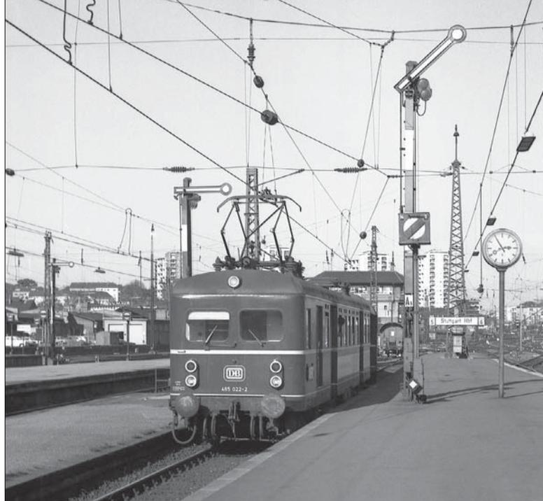
Hingegen standen bis zur Inbetriebnahme des Spurplanstellwerks im Jahr 1977 in Stuttgart Hbf an den Bahnsteiggleisen einflügelige Ausfahrtsignale. Das Foto zeigt sie mit dem ausfahrenden 465 022-2 am 10. Oktober 1971. *Foto Günter Berg*
