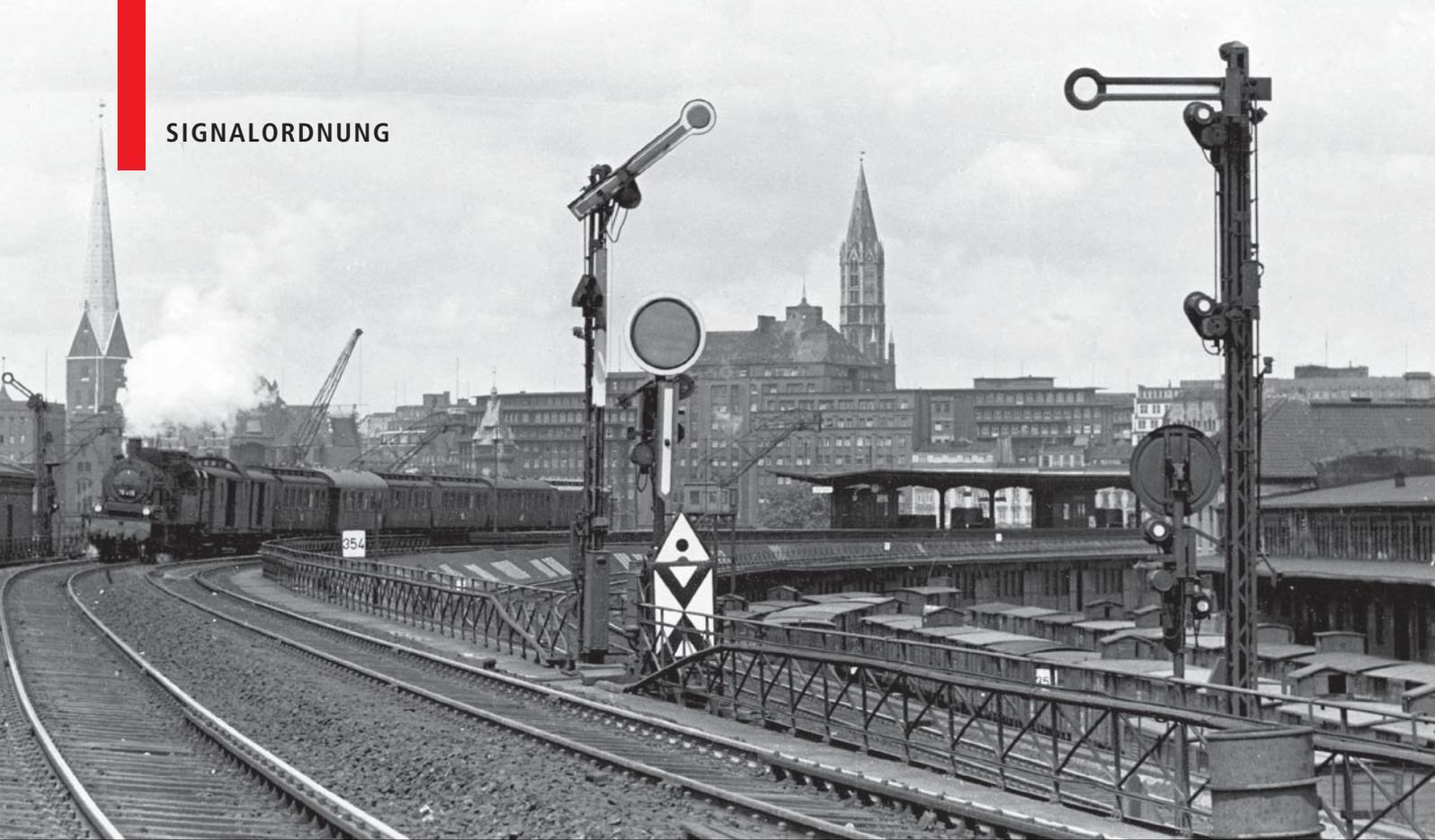
Auf der Hamburger Pfeilerbahn waren die Signale bereits vor dem Zweiten Weltkrieg mit Ersatzsignalen ausgerüstet. Das Foto zeigt 78 415 um 1936 mit einem Personenzug nach Lüneburg am ehemaligen Hp Oberhafen. Im Hintergrund die Türme von St. Petri und St. Jakobi. Das Hauptsignal in Bildmitte, das noch nicht der Einheitsbauform entspricht (abweichende Flügel- und Blendenanordnung), ist bereits mit einem Ersatzsignal ausgerüstet. Foto Hollnagel, Sammlung SC
