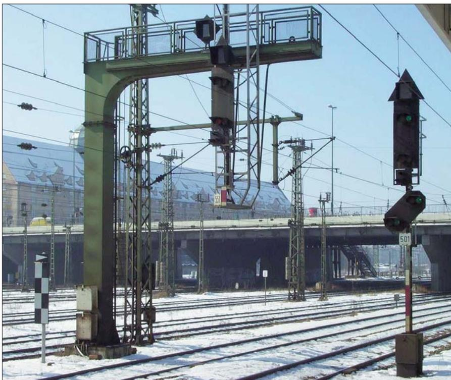
Da das Signal für den GWB an einem Ausleger rechts über dem dazugehörigen Gleis hängt, muss ab 2002 an seinem Standort eine Schachbretttafel aufgestellt sein. Zur eindeutigen Zuordnung besitzt sie hier eine Zuordnungstafel, München-Donnersbergerbrücke, Februar 2003.
