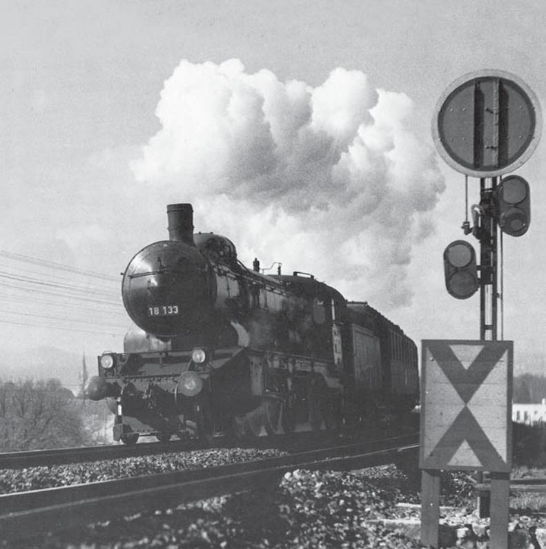
**Einfahrsvorsignal des Bf Bad Cannstatt im Oktober 1934. Vor dem Signal eine hölzerne Vorsignaltafel. Das Signal selbst hat zwar noch die alte Mastform und eine ebene Vorsignalscheibe mit Verstärkungsprofilen, besitzt aber bereits eine Hakenhebelsteuerung. Daneben 18 133, die mit einem Schnellzug die Steigung erklimmt. Foto: Alfred Ulmer, Sammlung Dietrich Braitmaier**
