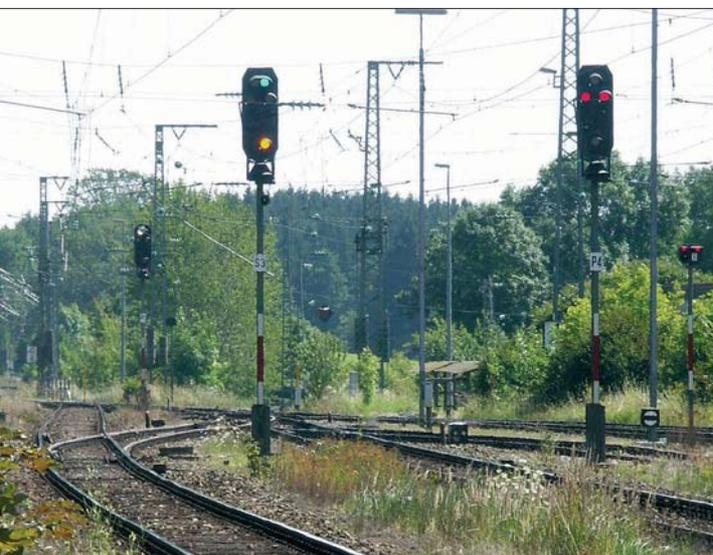
Links: Die Ausfahrtsignale des Bahnhofs Geltendorf am 12. August 2005. Die beiden linken Signale können Kennlicht anzeigen und besitzen daher oben eine Doppeloptik.
