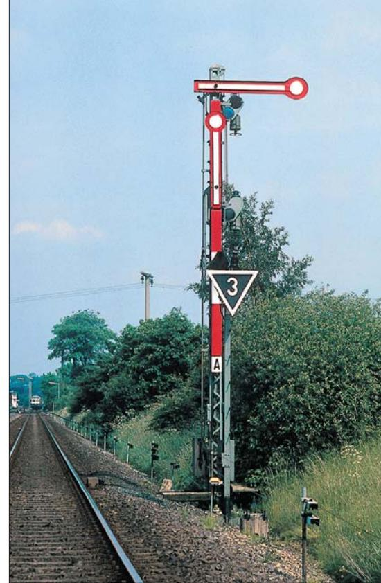
Das Einfahrtsignal des Bahnhofs Ascheberg aus Richtung Neumünster mit einem verstellbaren Geschwindigkeitsanzeiger für die Einfahrt in ein Stumpfgleis im Juni 1983
