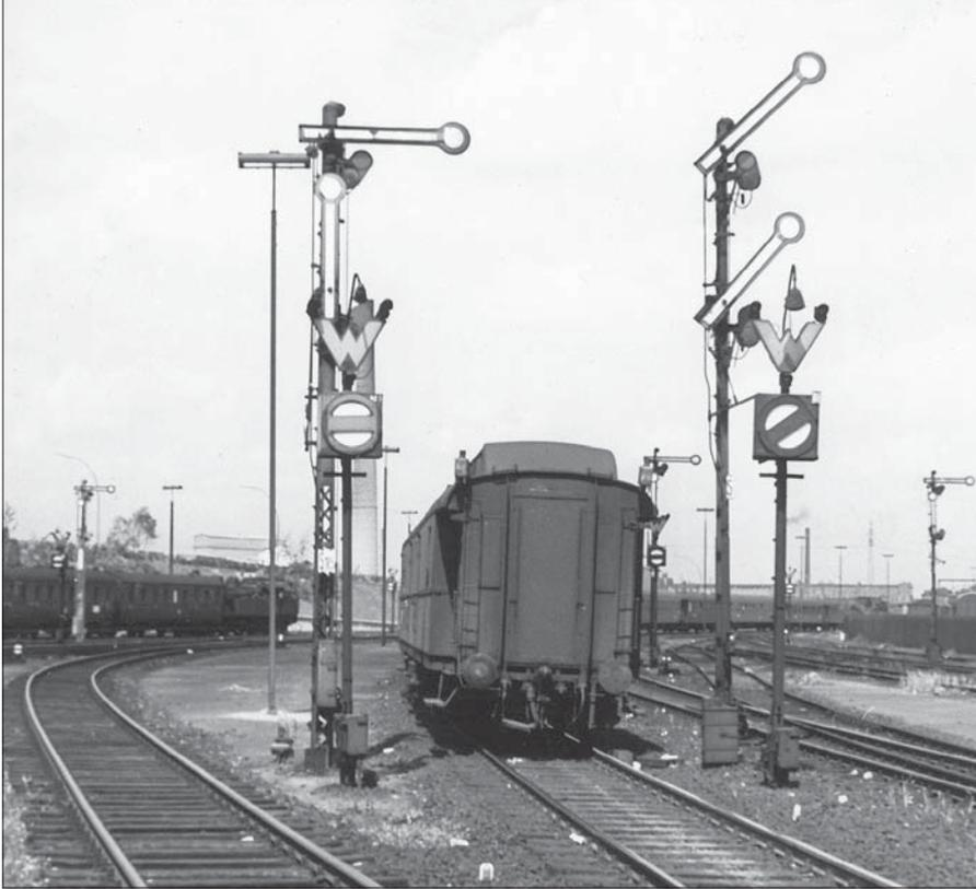
Um anzuzeigen, dass für ein Sperrsignal die „Wartevorschrift“ galt, erhielten diese ab 1933 ein gelbes, anfangs noch unbeleuchtetes „W“ auf bzw. über dem Laternenkasten. Der Fahrauftrag wurde an diesen Signalen durch das Aufleuchten des Vorrücksignals erteilt. Das Foto vom Nordkopf des Bahnhofs Hamburg-Harburg zeigt mehrere solche Sperrsignale im Juli 1958. Foto Hollnagel, Sammlung SC
