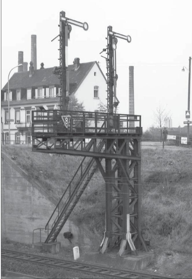
Auch das Aussehen von Signalbrücken und -auslegern hat sich im Laufe der Jahrzehnte gewandelt. Während diese anfangs ausschließlich genietete Fachwerkkonstruktionen waren, werden heute neu, in der Regel geschweißte Fertigteil-Ausleger und -Brücken mit Hohlkästen gebaut (Näheres hierzu s. Band 2). Die Fotos auf dieser Seite zeigen:
