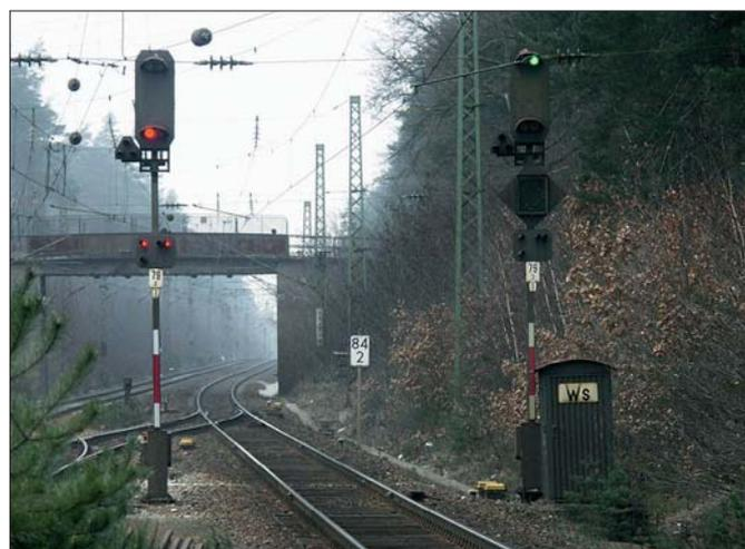
Ausfahrtsignale mit Gleissperrsignalen im Bahnhof Ochsenbruck im Dezember 2004. Das Ausfahrtsignal des durchgehenden Hauptgleises (rechts) ist mit einem Beschleunigungs-/Verzögerungsanzeiger ausgestattet, das Sperrsignal ist bei Fahrtstellung des Hauptsignals dunkel. Fotos Alexander Lindner
