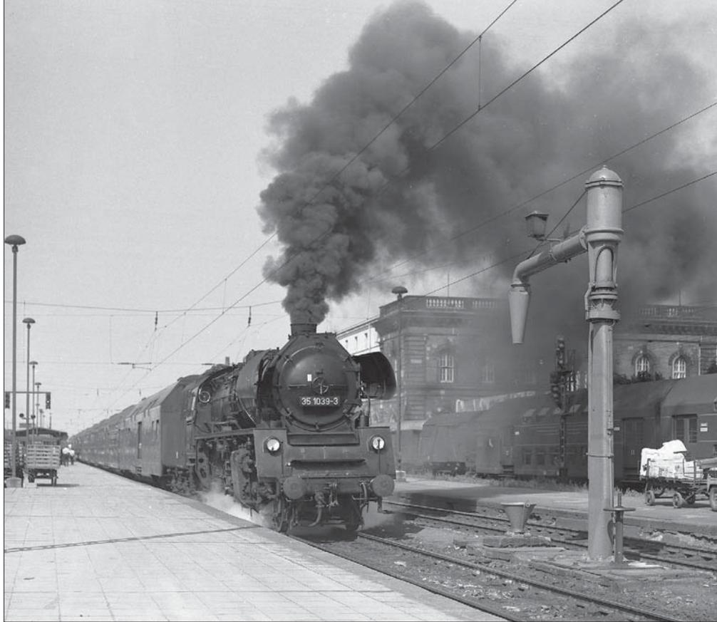
**39 1039-3 vom Bw Halberstadt verlässt mit einem Personenzug im Oktober 1972 Magdeburg Hbf. Rechts neben der Lok ein Wasserkran, der auch bei der DR, da er an einem Hauptgleis stand, mit einem Wasserkran signal ausgerüstet sein musste. Foto Helmut Constabel, Slg. SC**
