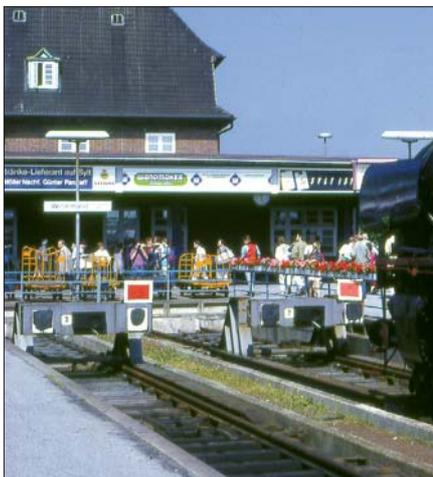
Mit Sh 2-Scheiben versehene Gleisabschlüsse der Einfahrstumpfgleise im Bf Westerland am 28. Juli 1991. Rechts im Bild spitzt 01 1100 hervor, die gerade mit einem Sonderzug aus Hamburg-Altona angekommen ist.
