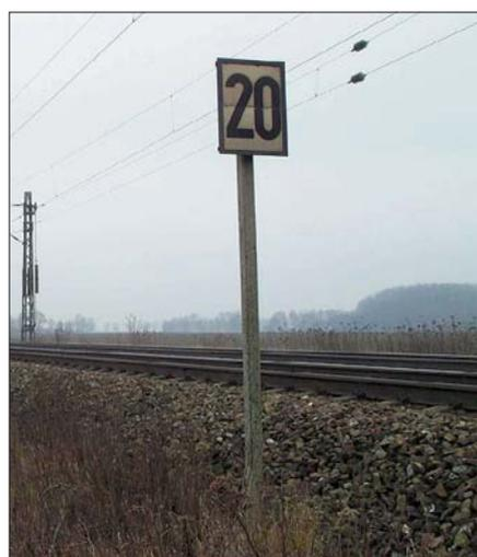
Geschwindigkeitssignale für 200 km/h gibt es bislang nur in der Kombination mit Sk-Signalen; Mertingen, Februar 2004. Links: Sk-Vorsignalswiederholer mit Geschwindigkeitsvoranzeiger im Februar 2005 bei Herbertingen.
