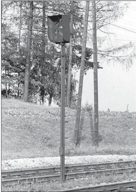
Zwischensignal der Reichsbahn-Bauart an der Semmeringbahn im Bahnhof Breitenstein 1954 fotografiert. Die DB ersetzte solche Signale ab 1949 durch Vorsignalwiederholer.
