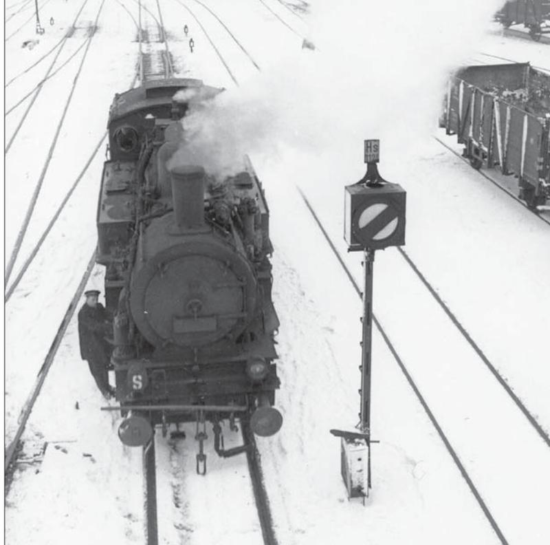
Aufschrift „Halt für Schiebelok“ – Signal 36b – bzw. „Halt für zurückkehrende Schiebelok“ – Signal 36c – aufgestellt. Die Aufschriften hatten den Nachteil, dass sie trotz beträchtlicher Tafelgröße selbst auf geringe Entfernung nicht mehr zu lesen waren.
