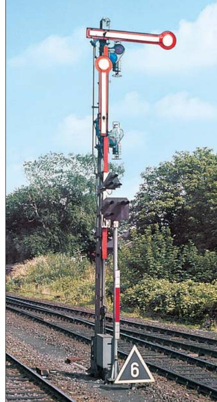
Formhauptsignal mit Ersatzsignal, Lichtsperrsignal der 1944 entwickelten Bauform und Geschwindigkeitsanzeiger für die Ausfahrt in Richtung Westerland mit 60 km/h im Juli 1991 im Bahnhof Niebüll.
