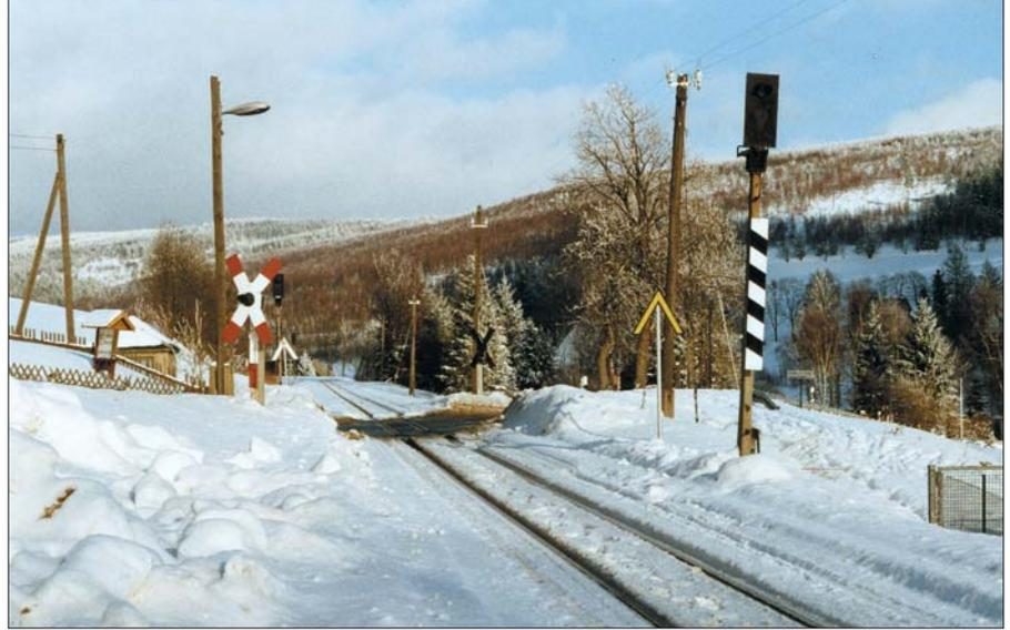
Blinklichtüberwachungssignal der von der DR 1959 eingeführten Bauform bei Hammerunterwiesenthal im Januar 2004. Dahinter eine Schneepflugtafel, die bei der DR ab 1984 gelb sein sollte. Fotos Michael Schnippering
