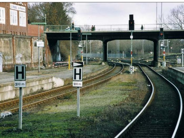
Die Zuordnungstafel wurde ursprünglich von der DR eingeführt, um links stehende Signaltafeln dem rechten Gleis zuzuordnen. Inzwischen wird sie sowohl bei der DB – wie hier an der zweiten H-Tafel im April 2004 in Lübeck Hbf – als auch bei der DR verwendet, um Signale eindeutig zuzuordnen.
