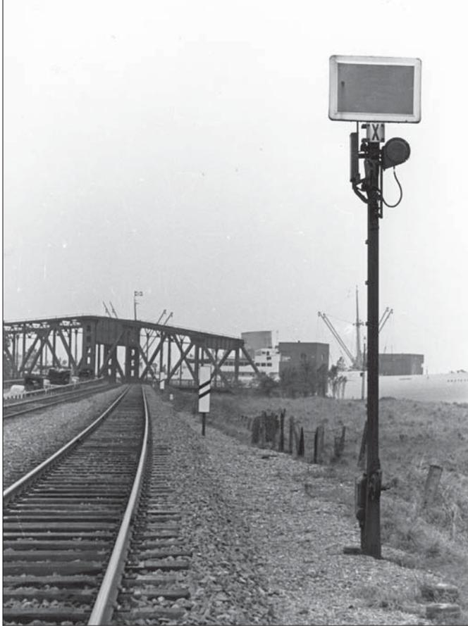
Links: Hohes Brückendeckungssignal vor einer Drehbrücke in Bremerhaven. Auf dem Foto vom 30. September 1952 gibt die Brücke gerade die Durchfahrt für die MS Proteus frei.
