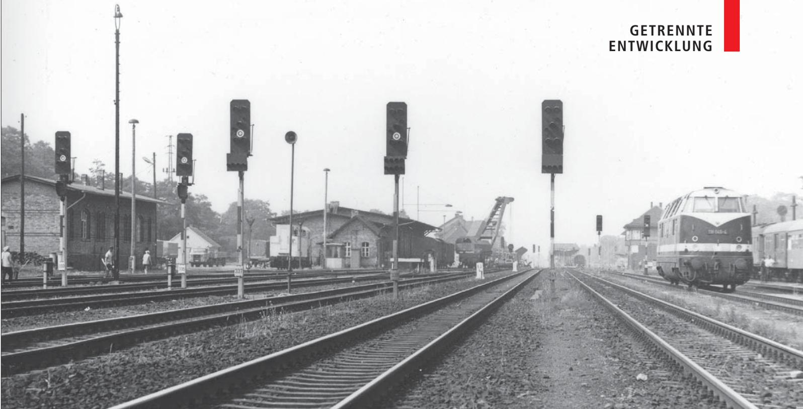
HI-Signale der Einheitsbauform und 118 045-4 1976 im Bahnhof Ludwigsfelde aufgenommen. Auffällig ist die unterschiedliche Ausstattung mit Zusatzanzeigern (Signale ganz links), ein bzw. zwei Lichtstreifen für die Anzeige von 60 bzw. 100 km/h und mit Kreisscheiben, die anzeigen, dass das Signal Ra 12 als Fahrauftrag gilt. Foto DR, Sammlung SC
