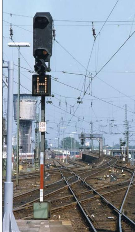
**Ausfahrtsignal mit Richtungsanzeiger „H“ für die Fahrt Richtung Hamburg Hbf im September 1991 im Bf Hamburg-Altona. Gegenüber 1952 hatte sich der Signalstandort geändert, die Technik war jedoch unverändert.**
