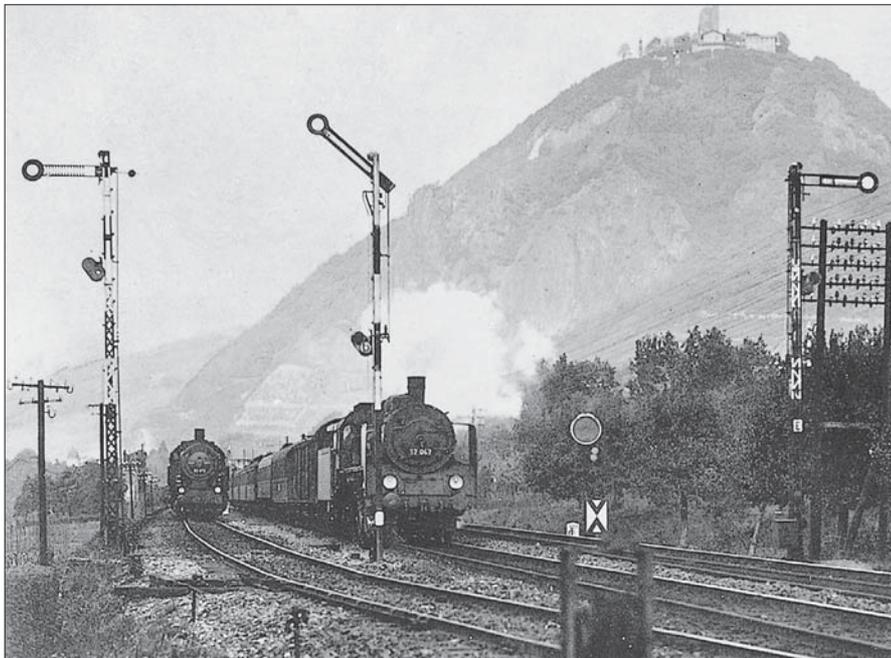
17 047 überholt mit einem Schnellzug 93 672 im Bf Rhöndorf. Interessant auf diesem um 1930 entstandenen Bild: Die unterschiedlichen Signalformen, das dicht hinter einem Hauptsignal stehende Vorsignal und das einflügelige Ausfahrtsignal am Überholungsgleis. Foto Kroll, Slg. Hoyer
