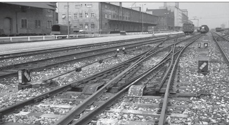
Zwar ist diese DKW in Mannheim Hafen mit Weichensignalen mit Rückstrahlschildern ausgerüstet, die Anordnung der einfachen Weichensignale entspricht hingegen noch der ursprünglichen Form vor Einführung besonderer DKW-Signale. Foto Günter Berg
