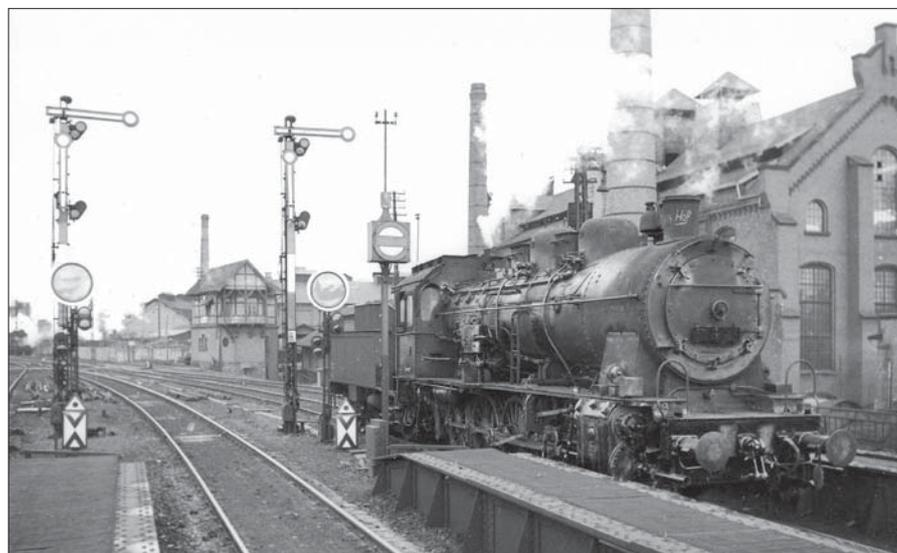
Achse drehbaren Signalkörper aufgestellt. Diese zeigten bei gesperrtem Gleis das Signal 14, war die Gleissperrung aufgehoben, das Signal 12.
