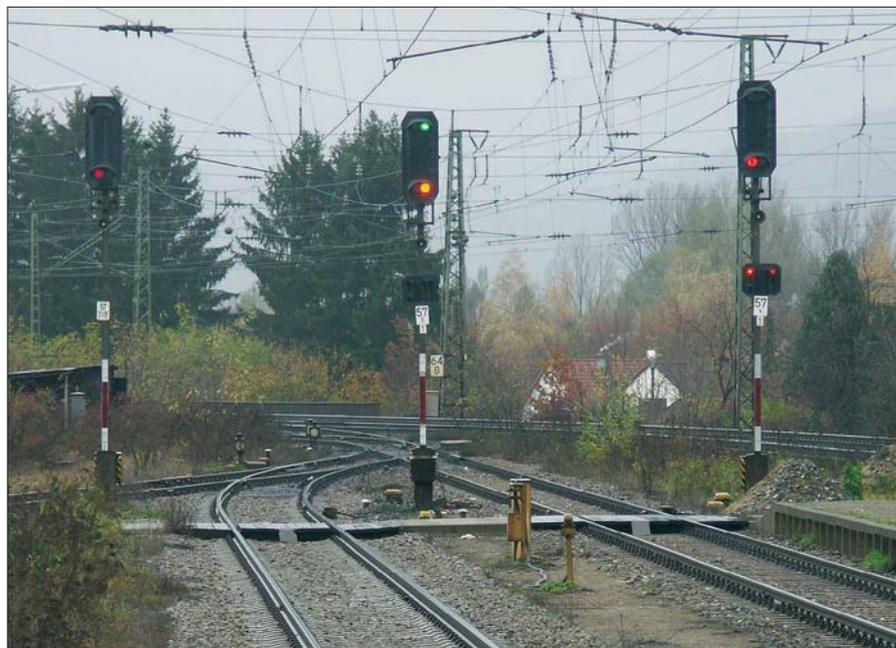
Ausfahrtsignale des Bahnhofs Neumarkt in der Oberpfalz in Richtung Nürnberg ebenfalls im November 2004. Interessant ist an dem Foto, dass nicht alle Signale der Signalgruppe mit Gleisperrsignalen ausgerüstet sind. Obendrein haben die Hauptsignale – für Lichtsignale eher ungewöhnlich – keine Ersatzsignale.
