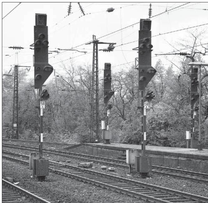
**Kombinierte Haupt- und Vorsignale mit vereinigttem Signalschirm im Raum Köln: Links ein „Halt erwarten“ zeigendes Selbstblocksignal in verkürztem Vorsignalabstand (das Hauptsignal ist dunkel), rechts Ausfahrtsignale im Bahnhof Köln-Deutz im April 1972. Fotos Günter Berg**
