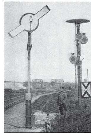
**Dreibegriffs-Vorsignal von Roudolf (in Warnstellung und zur Ankündigung einer Abzweigung) neben einem Doppellicht-Vorsignal 1910 auf dem Verschiebebahnhof Tempelhof. Für die Fahrtstellung stand der Flügel des Roudolfschen Signals senkrecht.**
