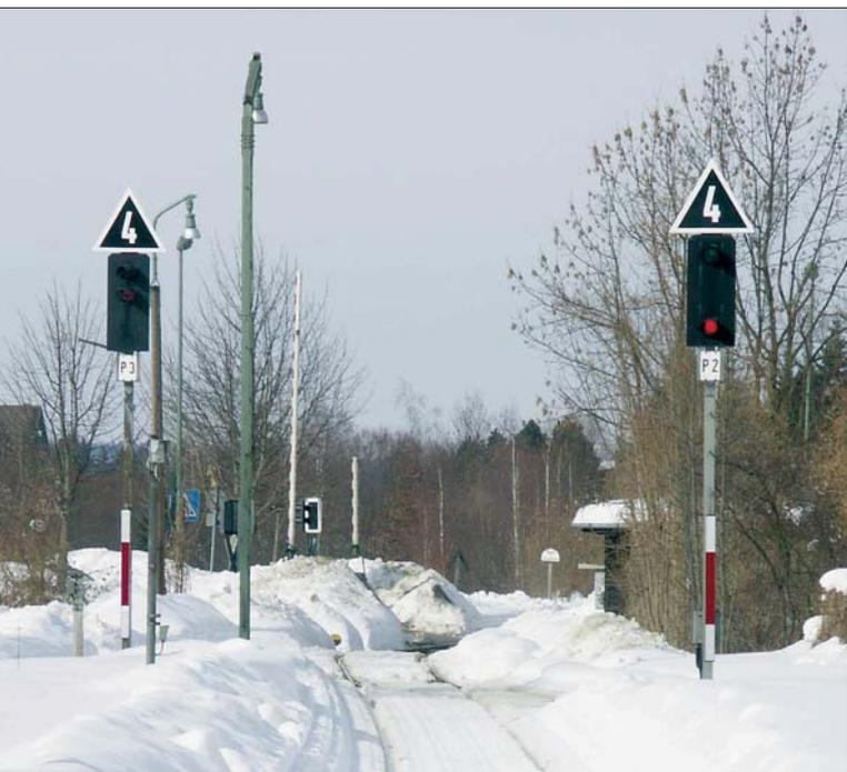
Nebenbahn-Lichtsignale im Bahnhof Lenggries im März 2005. Während das linke Signal einen Originalschirm für ein zweibegriffiges Hauptsignal hat, wurde rechts anscheinend ein Signalschirm eines Blinklicht-Überwachungssignals verwendet.
