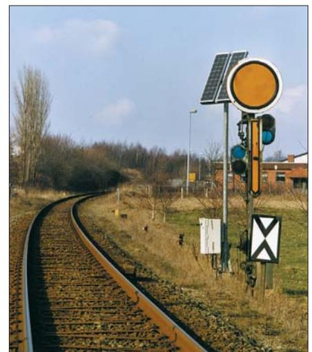
Das Einfahrvorsignal des Bahnhofs Heide aus Richtung Neumünster im Februar 2004. Auch hier erfolgt die Stromversorgung der Leuchtdioden über Sonnenkollektoren.
