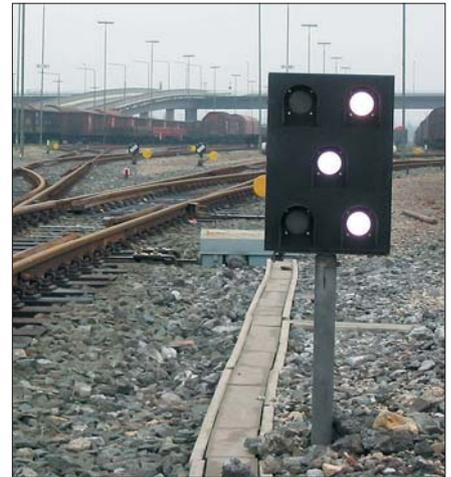
Während in Lübeck Hbf im Zusammenhang mit dem Bau des ESTW eine komplette Gleisgruppe mit EOW's ausgerüstet wurde, erhielt im Rbf Maschen nur diese DKW 2003 einen elektrischen Antrieb. Die Weichen im Hintergrund werden weiterhin manuell bedient.
