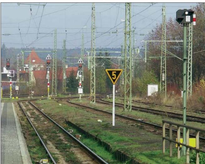
Links: Im Zusammenhang mit den Ks-Signalen wurden Geschwindigkeitsvoranzeiger auch als Signaltafeln eingeführt. Daneben ein Kennlicht zeigendes hohes SEL-Sperrsignal mit einer roten Laterne und kleinem Mastschild, Neufahrn, November 2004.
