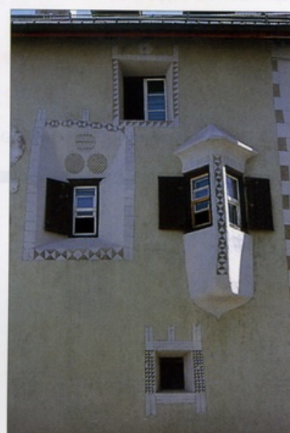
Eine Fassade aus dem Engadin (Pontresina). Regionaltypisch die sich nach außen erweiternden Fensteröffnungen in den dicken Außenwänden und die Fassadenmalerei. Interessant auch der Spitzerker!
