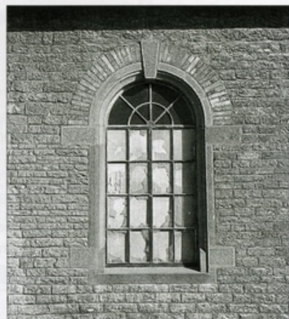
Bad Mergentheim war früher Wechselbahnhof zwischen Baden und Württemberg. Oben das renovierte Empfangsgebäude: Muschelkalk-Mauerwerk mit Ziegelbögen über den Fenstern. Der früher badische Lokschuppen ist dagegen in etwas desolatem Zustand. Unten verschiedene Fensterformen mit Sandstein-Gewänden.
