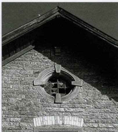
Bad Mergentheim war früher Wechselbahnhof zwischen Baden und Württemberg. Oben das renovierte Empfangsgebäude: Muschelkalk-Mauerwerk mit Ziegelbögen über den Fenstern. Der früher badische Lokschuppen ist dagegen in etwas desolatem Zustand. Unten verschiedene Fensterformen mit Sandstein-Gewänden.
