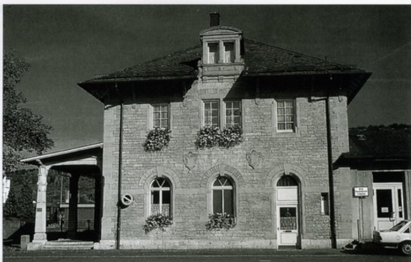
Bad Mergentheim war früher Wechselbahnhof zwischen Baden und Württemberg. Oben das renovierte Empfangsgebäude: Muschelkalk-Mauerwerk mit Ziegelbögen über den Fenstern. Der früher badische Lokschuppen ist dagegen in etwas desolatem Zustand. Unten verschiedene Fensterformen mit Sandstein-Gewänden.
