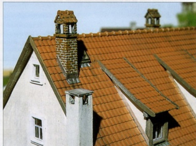
Oben eine Scheune mit angebautem Stall; die Sattelgaube dient als Zugang zum Speicherraum im Dach. Die Kehlen wurden mit eingelegten Blechen (aus Walzblei) versehen. Ein kleines Satteldächlein schützt den Abgang in den Gewölbekeller. Unten Schleppdachgauben und Kamine verschiedener Art an einem Modell-Bauernhaus.
