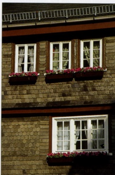
Fenster in schieferverkleideter Fassade (Hachenburg).
