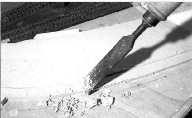
Wenn der Gips etwas ausgehärtet ist, kann man damit beginnen, die Form des Straßenquerschnittes mit einem Stecheisen aus dem Gips herauszuarbeiten.
