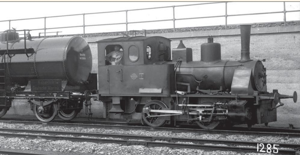
V. l. n. r. noch vor deren Abnahme die Kesselwagen Altona 503 822 bis 503 824 [P] und 503 819 bis 503 820 [P] der Kaiserlichen Deutschen Marine für den Transport von Teer- und Erdöl. Sie entsprachen bereits Verbandsbauartgrundsätzen, hatten aber einen Achsstand von nur 3500 mm und auch die Gesamtlänge war kürzer als üblich. Ungewöhnlich ist die dunkle, vermutlich rote Einstelleranschrift. Slg. Rheinisch Westfälisches Wirtschaftsarchiv (RWWA)
