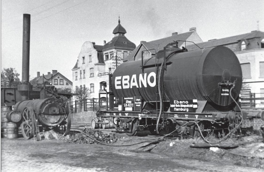
Um mit Teer oder Bitumen beladene Wagen entleeren zu können, mussten diese ggf. mit Dampf beheizt werden. Auf dem Foto des Altona 526 822 [P] der Ebano Asphalt-Werke, aufgenommen vmtl. 1929, geschah dies mit Hilfe eines fahrbaren Dampfkessels. Foto *Slg. SC*
