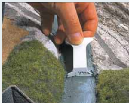
Zum Abziehen der Oberfläche wird der Spachtel immer wieder angefeuchtet, um eine glatte Oberfläche zu bekommen.
