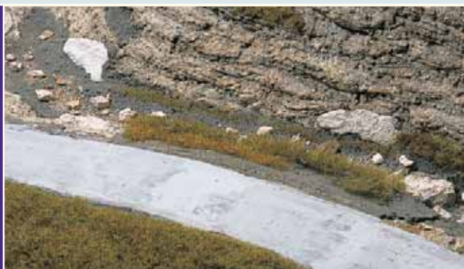
Während das Bachbett trocknet, kann die Zeit genutzt werden, die Böschungen auch mit dem Zellulosematerial zu gestalten.
