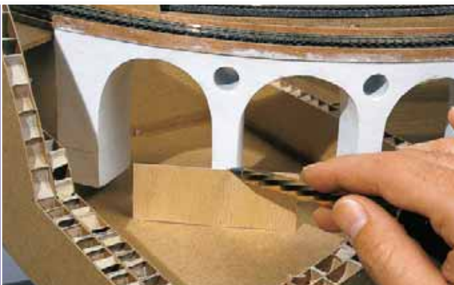
Um waagerechte Fugenverläufe einritzen zu können, wird mit einer Schablone vom Anlagengrund aus eine Hilfslinie übertragen. Die weiteren Fugen werden mit einem Bleistift parallel angezeichnet.
