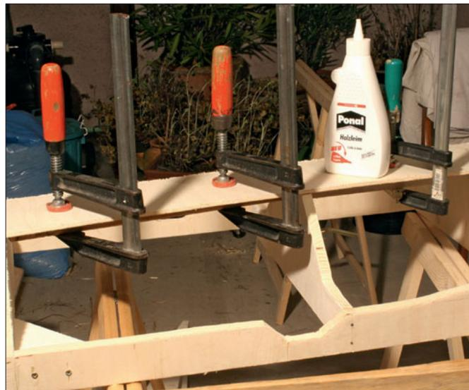
Als Standardmaterial für den Unterbau von Modellbahnanlagen können zweifellos Kanthölzer, Sperrholz und Tischlerplatten gelten. Stichsagen ermöglichen feine und gebogene Schnitte. Zum Kleben dient Holzleim, der tief in die Fasern des Holzes eindringt, wodurch eine dauerhafte Verbindung hergestellt wird.
