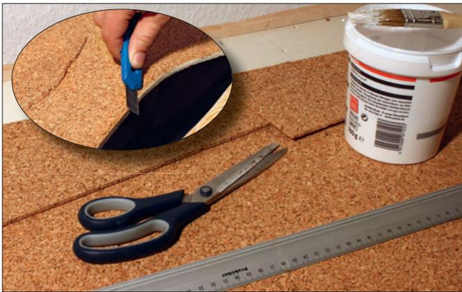
Auch bei Kork handelt es sich um einen Holzwerkstoff. Dank seiner geringen Dichte eignet er sich gut zur Geräuschdämmung unter den Gleisen. Die Korkplatten lassen sich mit einer Schere oder einem scharfen Cutter schneiden. Kork- oder Holzleim dient zum Kleben.
