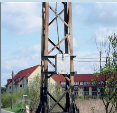
Oben: Im verschließbaren Kasten befindet sich ein Hebel, mit dem eine Stellstange zum Mastschalter betätigt werden kann.
