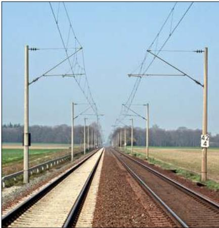
Diese zweigleisige Strecke in der Nähe von Peine ist mit einer Fahrleitung der Bauform Re200 ausgerüstet. Die Ausleger an den Betonmasten sind mit ihren Seitenhaltern so gestaltet, dass sie den Fahrdraht immer von der Gleismitte wegziehen und somit auf Zug belastet werden.
