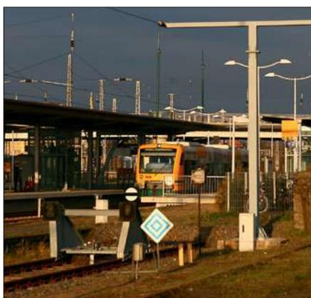
Am Stumpfgleis in Eberswalde wird das Ende des hier einfachen Fahrdrabts ebenfalls signalisiert. Hier ist ein Endmast vorhanden der als Festpunkt fungiert.
