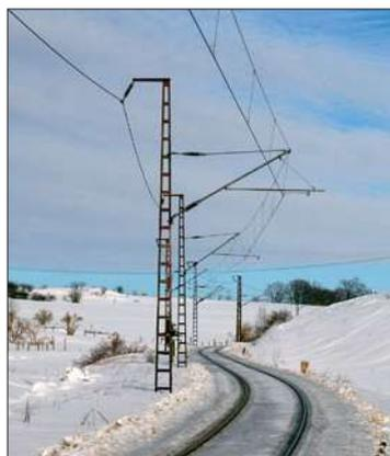
Links: Bei dieser Fahrleitung im Bogen ist sehr gut zu sehen, dass der Fahrdrabt immer zur bogenäußeren Seite angelenkt wird. Stehen die Masten innen im Bogen, kommen lange Ausleger zum Einsatz (Stützpunkt L), außen dagegen kurze Ausleger oder Seitenabzüge (Stützpunkt K).
