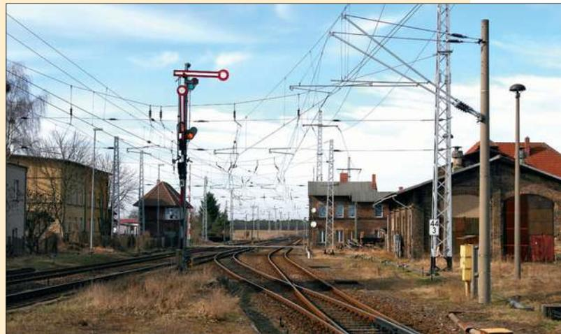
Hier wird der Bahnhof mit einem Querseiltragwerk überspannt. An der Weiche musste ein zusätzlicher Mast mit Doppelausleger aufgestellt werden. Der abzweigende Fahrdraht ist gut zu erkennen.
