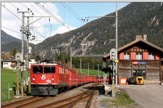
Im Bahnhof Surava der RhB stehen am Schaltposten Einzelmasten, während der übrige Bahnhof von Querjochen überspannt wird.
