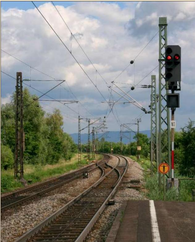
Eine Gleisverbindung einer zweigleisigen Strecke im Bogen. Deutlich ist der Fahrdraht mit der Abspannung für die Gleisverbindung zu erkennen. In der Mitte sitzt ein Fahrleitungstrenner.
