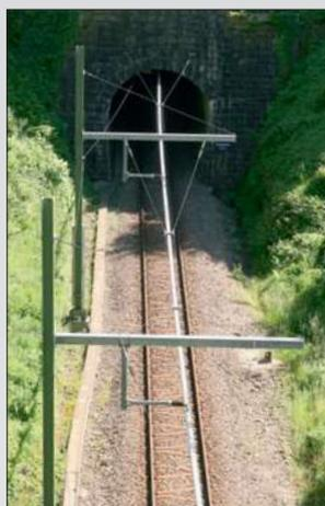
**Auf der Murgtalbahn wurden die niedrigen Tunnelprofile mit Deckenstromschienen ausgerüstet. Bei den Bereichen zwischen den Tunneln wurde die Deckenstromschiene durchgehend geführt. Hier erfolgte die Montage an Stahlmasten mit isolierten Seitenhaltern. Von den Masten aus wurden die Stromschienen zusätzlich abgespannt.**
