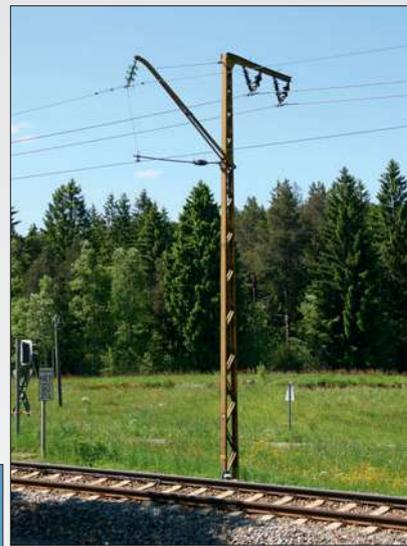
Der Träger von Sommerfeldt für die Speiseleitung wurde von oben auf den Mast gesteckt und anschließend lackiert. Die Speiseleitung entstand im Modell aus dünnem Faden. Zusätzlich sind am Mast ein Schalter und ein Trafo vorhanden.
