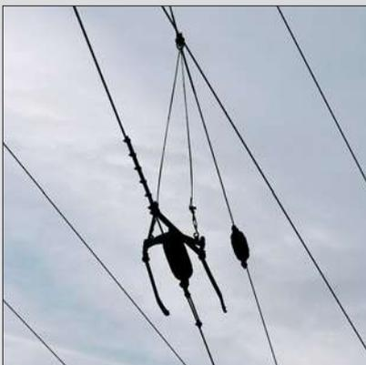
Trenner unterbrechen den Fahrdraht über einen Isolator und führen den Stromabnehmer über Kufen hindurch. Der Trenner ist über eine Rolle und Drähte am Trageseil aufgehängt.
