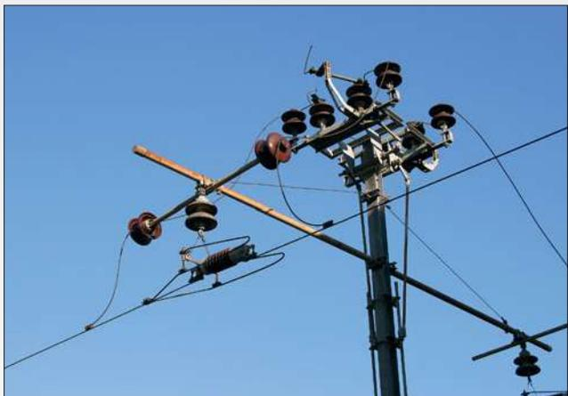
Ein Fahrleitungsmast im österreichischen Übelbach mit Einfachfahrleitung und zuschaltbarem Bahnhofsgleis mit Trenner und Schalter auf dem Fahrleitungsmast.
