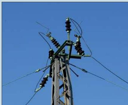
Oben und rechts: Ein geöffneter Schalter. Gut ist zu erkennen, wo Isolatoren feststehen und wo sie abgeklappt wurden.
