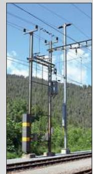
Die Querjochs der Fahrleitungen besitzen den Vorteil hoher Stabilität. Oft sind sie zudem niedriger als Quertragwerke aus Seilen. Die Erdungs- und Speiseleitungen werden den Masten seitlich zugeführt. Im Foto oben rechts ein Schaltposten, von dem aus mehrere Gleise ja nach Bedarf einzeln vom Oberleitungsbetrieb getrennt, mithin stromlos geschaltet werden können.
