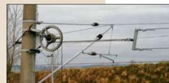
Fahrdraht und Tragseil sind an den Trommeln mit kleinem Durchmesser angebracht, das Gewicht hängt am großen Zahnrad ganz vorne.
