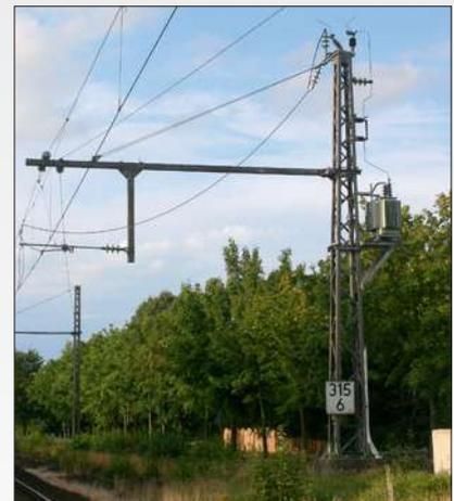
Der Masttransformator im Modell wirkt durch seine feinen Rippen sehr filigran. Von oben kommend wurde die Speiseleitung vom Mastschalter und der Fahrleitung nachgebildet. Nach unten führt die Stromleitung zu den Verbrauchern.
