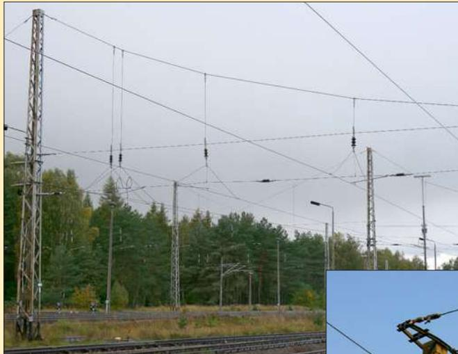
Im Bild links ist eine Einfachfahrleitung zu sehen, deren Aufhängung am Quertragwerk mit zusätzlichen Beiseilen verbessert wird. Das Bild unten zeigt das untere Richtseil mit Seitenhalter. Die Aufhängung besitzt einen Metallwinkel.
