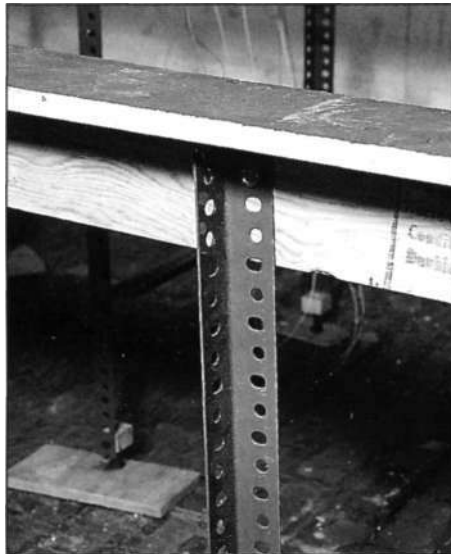
Auch in der Mitte der L-Träger wurden Stützbeine angebracht.
