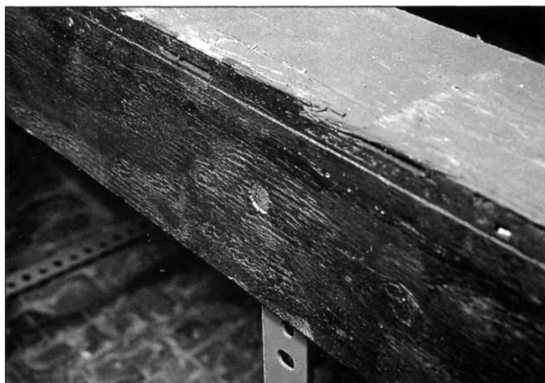
Auch in der Mitte der L-Träger wurden Stützbeine angebracht.
