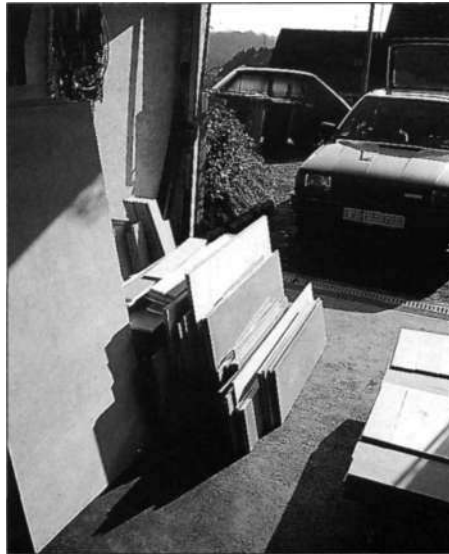
Eine Menge Holz in der Hütte: Zwischenlagerung des angelieferten und zugeschnittenen Holzes in der Garage.
