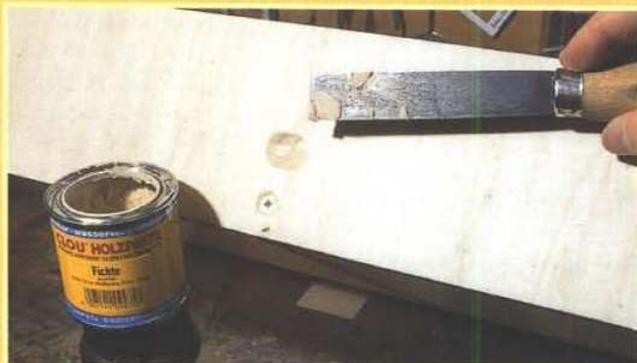
Nach dem Eindrehen der Schrauben werden die Schraubenöffnungen mit Holzkitt zugespachtelt, nach dem Trocknen und vor einem eventuellen Anstrich werden sie verschliffen.
