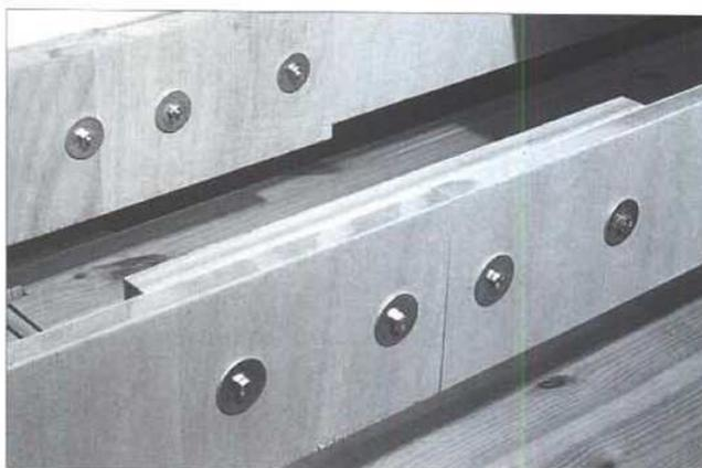
Wenn Holzteile sehr oft gelöst werden, wird die Verbindung am besten mit Maschinenschrauben hergestellt. Bei der Verwendung von Flügelmuttern ist noch nicht mal Werkzeug erforderlich.
