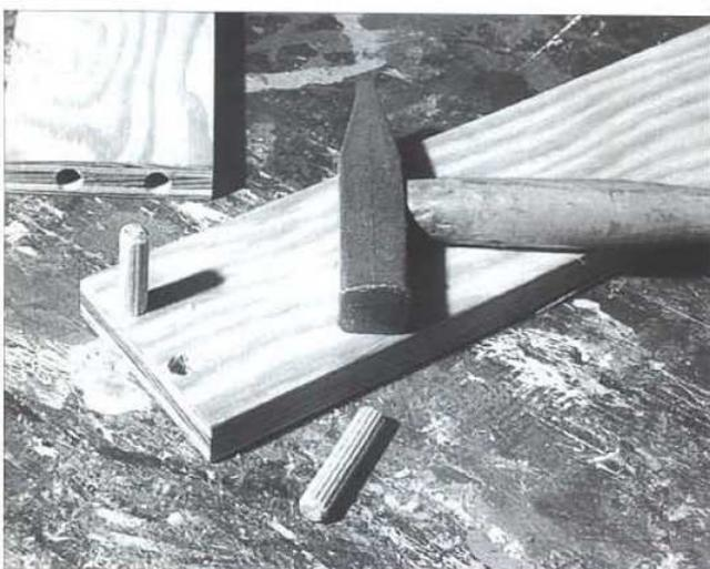
Nun werden die Dübel in das zuletzt gebohrte Holzteil eingesetzt oder eingeschlagen. Das andere Holzteil wird dann mit den Löchern auf die Dübel aufgesetzt und kräftig aufgedrückt.
