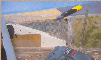
Die Geländebasis wird an die Flügelmauern aus Sperrholz mit Gaze angepasst.
