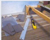
Die hölzerne Grundkonstruktion der Brücke
