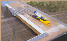
Die Deckschicht der Straße ist bereits verspachtelt, nun kann die Montage der Bürgersteige (Fallor) folgen.
