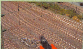
Dem Aufstecken der Isolatoren folgte die Lötverbindung am Querseil. Nach der Montage wurden die Überlängen der Hänger mit dem Seitenschneider abgetrennt.
