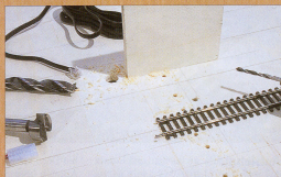
Die Bohrungen für die Verkabelung sollten nach der Gleismarkierung vorgenommen werden. Kurze Abschnitte aus Silberdraht stellen die Verbindung zwischen Schiene und Versorgungsleitung her.
