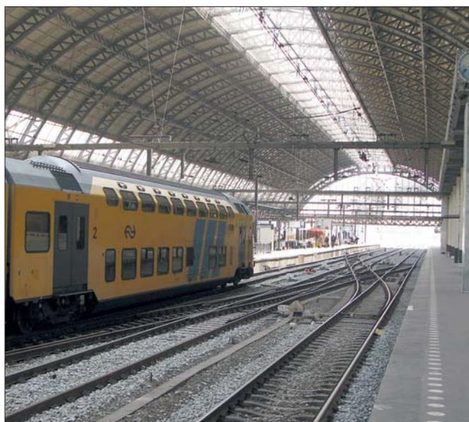
Eine rasante Art der Weichenverbindung findet sich im Amsterdamer Hauptbahnhof. Hier wird die Befahrung von allen drei Gleisen auf die jeweils anderen gewährleistet. Vorderes und mittleres Gleis haben sogar eine Verbindung als „Hosenträger“ in Kombination mit DKWs.
