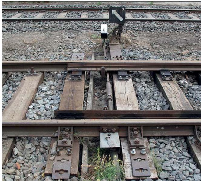
Der Stellmechanismus einer Handweiche hat neben seiner Stellstange, die mit dem Handhebel verbunden ist, auch schon Verschlussklammern. Die Weichenlaterne signalisiert gleichzeitig die Stellung der Weiche.
