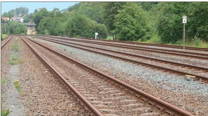
Bei diesen Betonschwellen älterer Bauart ist sehr gut die Mitteldelle zu erkennen, die den Streckengängern ihre Märschen erleichtern sollte.
