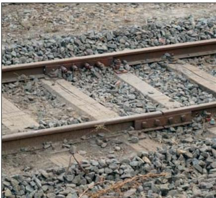
Der feste Schienenstoß auf einer Doppelschwelle aufliegend und mit Schienenlaschen verbunden. Die Doppelschwelle konnte die Druckkräfte am Schienenstoß besser abfangen. Diese Art der Schienenverbindung wurde später durch die Verschweißung der Schienen abgelöst.
