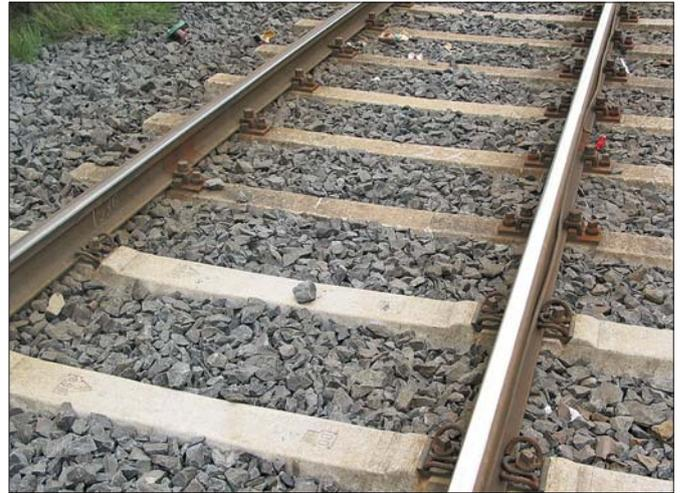
Die neueste Formgebung bei Betonschwellen (B 90) mit einer sichtbaren Engstelle in der Mitte hat den Sinn, die Gleislage im Schotterbett zu verbessern. Schwel-len dieser Bauart werden im Zusammenhang mit einer elastischen Schwel-lensohle verwendet. Dies verringert den Instandhaltungsaufwand beträchtlich.
