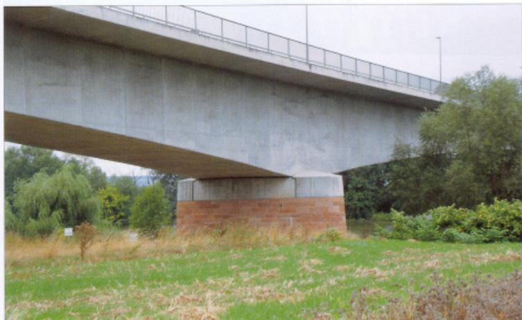
Der Träger einer Straßenbrücke wird hier kräftig von einem Pfeiler gestützt, der mit rotem Mainsandstein verblendet wurde. Die Verdickung des Trägers über dem Pfeiler bezeichnet man als Voute, die (wie hier) gebogen oder eckig sein kann. Diese Gestalt wäre auch für eine moderne Eisenbahnbrücke denkbar.
