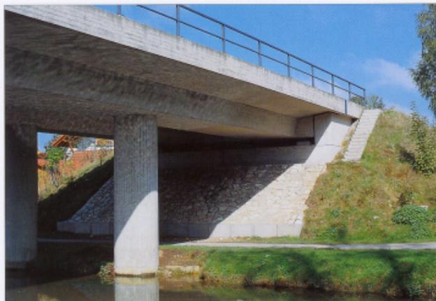
Diese moderne Brücke – sie steht in Neuhaus/Pegnitz – offenbart einige bemerkenswerte Details: Pro Spur ein Balkenträger und zwei Stützen im Fluss, eine Hangverbauung mit Rundstein und eine Treppe, die zur Trasse führt.
