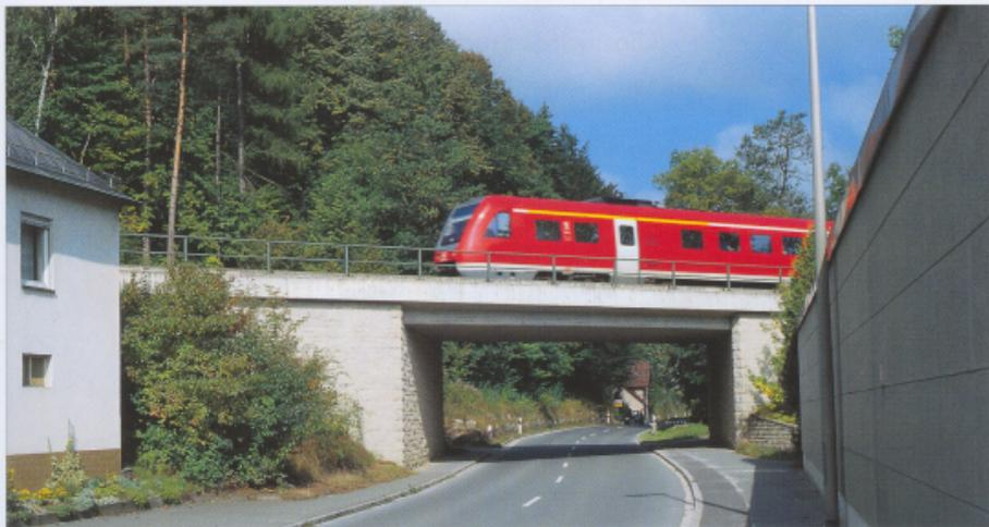
Der Triebwagen verlässt gerade den Bahnhof Neuhaus in Richtung Nürnberg. Die Brücke zeigt ein fast weißes Steinkleid. Die neueren Brückenträger zeigen trotz der hohen Verkehrslasten eine erstaunliche Filigranität.
