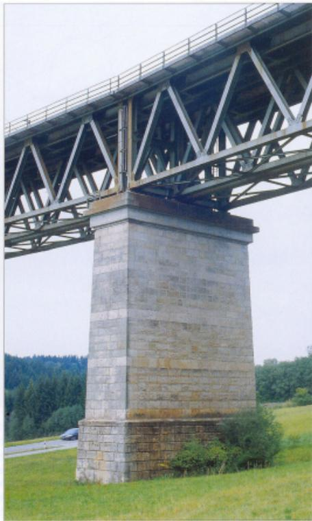
Diese Nahaufnahme zeigt den großen Pfeiler der Deininger Fachwerkbrücke und den „Knick“ der Träger aufgrund der gekrümmten Trasse. Jeweils ein Fachwerk, das nur schräge Streben aufweist, trägt eine Spur.
