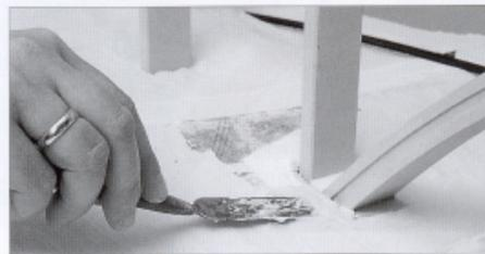
Die Baustelle an den Pfeilern wurde mit Gipsbinden flächig geschlossen, sodass leichter und sorgfältiger gegipst werden kann.
