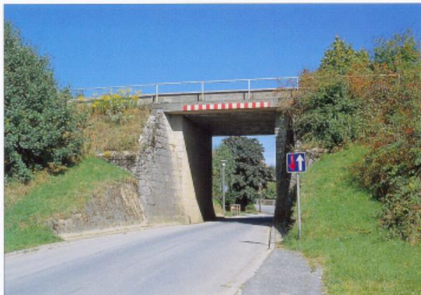
Die „Standardbrücke“ aus der Epoche III, eine Stahlbetonbrücke für kleinere Straßen und Feldwege, zeigt sich hier mit verschiedenen schwach geneigten Stützmauern.
