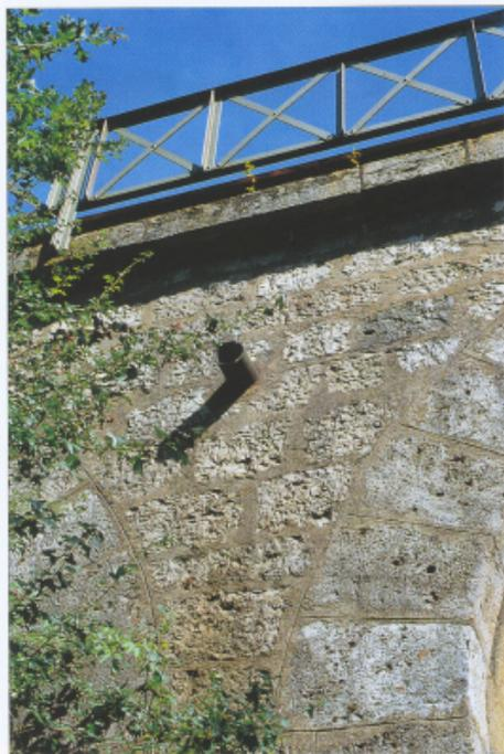
Genau in der Mitte des „Bogenzwickels“, der Fläche zwischen Bogen und Fahrbahn, liegt ein Rohr zur Entwässerung des Schotterbetts. Das feingliedrige Geländer ziert diese einfache Bogenbrücke.
