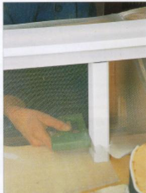
Das Fliegengitter lässt sich mit Schmelzkleber an den Pfeilern befestigen. Bei genügend Platz und ausreichender Stabilität der Pfeiler kann auch getackert werden.
