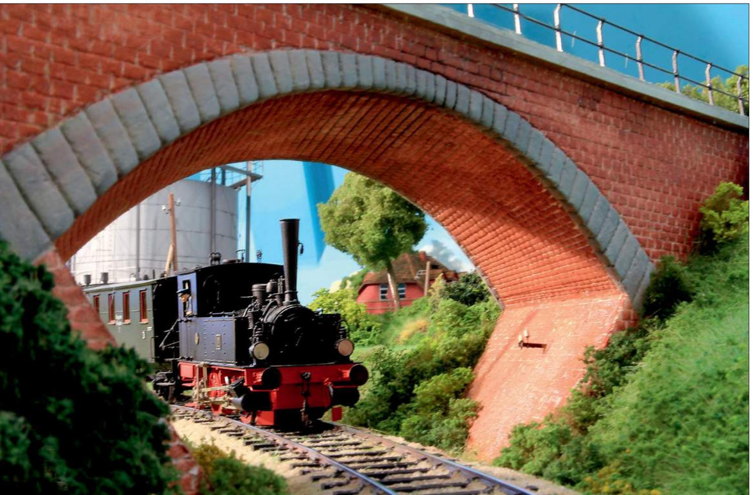
**Da die Straße schräg die Strecke kreuzt, wurde das Viadukt korrekt als „schiefer Bogen“ ausgeführt.**
