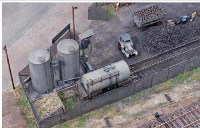
Mit neu entwickelten Rohrleitungen und Pumpen und der Verladeanlage von Weimann ist ein sehenswertes Heizöllager entstanden.
