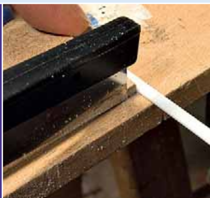
An einem Anschlag wurden die Fugen der Ladestraßeneinfassung leicht eingesägt.
