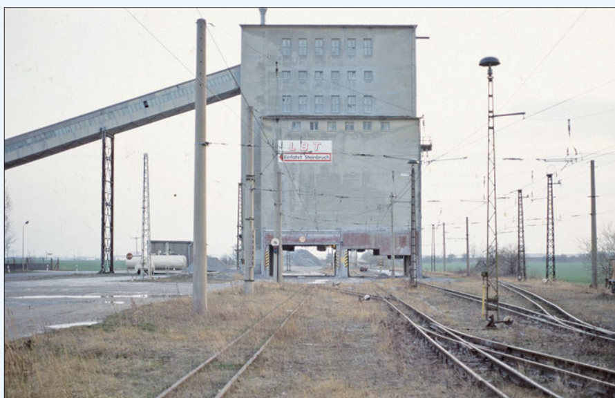
Unten: Der Blick in die Gegenrichtung zeigt das Ende der Strecke mit dem Lokschuppen und der Werkstatt. Die Schüttrampe links sichert eine Beladung im Störfall.
