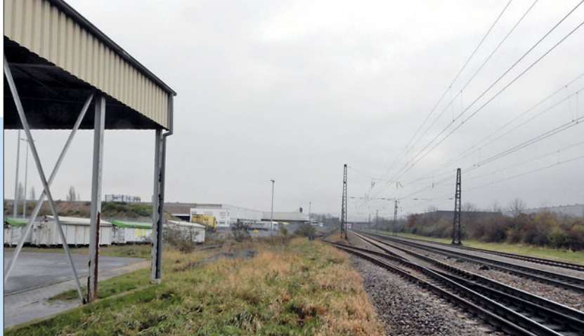
Als Anschlussstelle mit Ausweichgleisen ist der Gleisanschluss des Edeka-Lagers in Heddesheim ausgeführt. Er ist mit einem Streckentelefon und einer verriegelten Weiche gesichert und liegt ebenfalls deutlich unter dem Gleisniveau der zweigleisigen Hauptstrecke Darmstadt–Mannheim. Die Weichen im Anschluss sind alle ortsgestellt.
