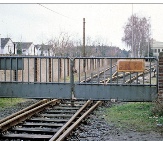
Der ehemalige Betriebshof in Heusenstamm – eine Instandhaltungsstätte der DB – war am Einfahrtstor des Geländes wie eine Zufahrt zu einem privaten Industriegelände mit einem Sh 2- (Schutzhalt) Signal gesichert und besaß zudem noch eine Schutzweiche.
