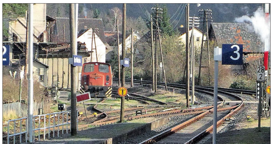
Der ehemalige Betriebshof in Heusenstamm – eine Instandhaltungsstätte der DB – war am Einfahrtstor des Geländes wie eine Zufahrt zu einem privaten Industriegelände mit einem Sh 2- (Schutzhalt) Signal gesichert und besaß zudem noch eine Schutzweiche.
