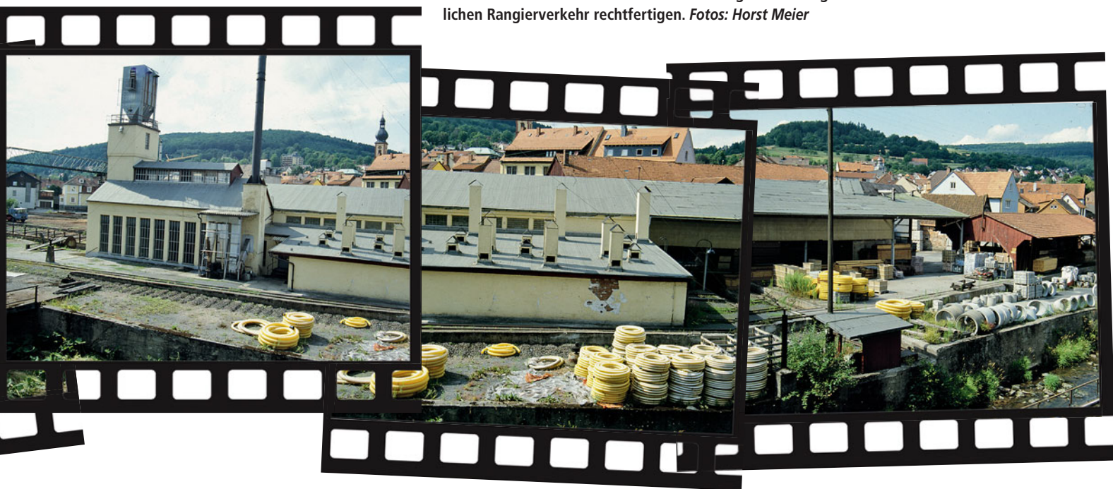
Die Dia-Reihe unten zeigt den Anschluss eines Sägewerks im Spessart, ebenfalls an freier Strecke. Auf den Holzhandel allein verlässt man sich hier nicht, bereits in den 1990er-Jahren hat man die Tätigkeit auch auf den Baustoffhandel ausgeweitet. Eine ähnliche Situation würde sich bestimmt auch bei einer Nachbildung im Modell gut machen und zudem zusätz- lichen Rangierverkehr rechtfertigen. Fotos: Horst Meier
