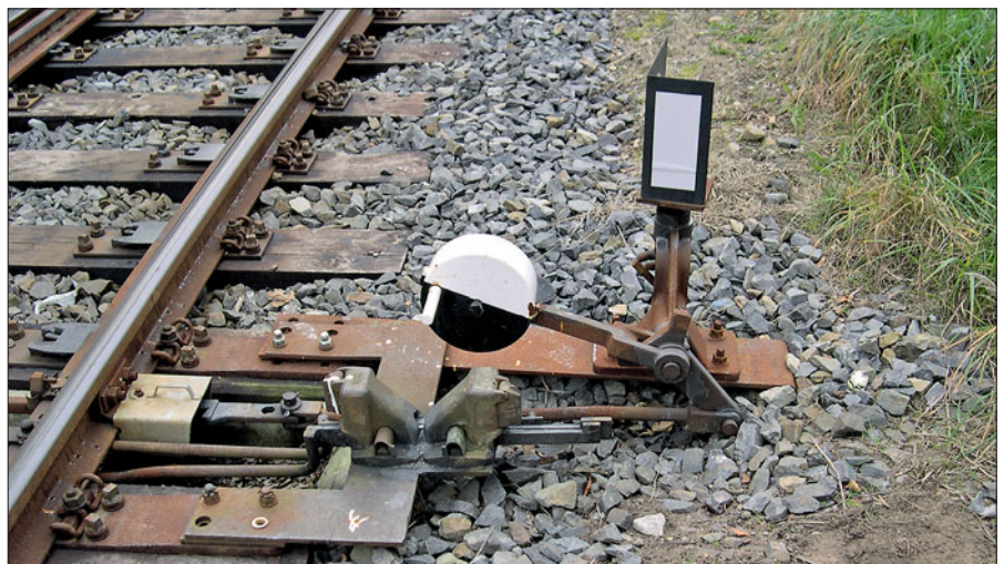
Ortsgestellte Weiche des Gla Süderlügum (Ladestraße) mit folgeabhängigem Weichen- und Kuppelschloss (re). Früher waren bei der DB die beiden abhängigen Schlösser an der Gleissperre zu finden und nicht an der Weiche. Fotos (3): Martin Meiburg, Fa. Outbus
