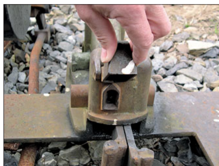
Die Schließvorrichtungen sind fast unscheinbare Höcker, das Schloss hat eine Abdeckung. Das Weichenschloss ist offen und leer.
