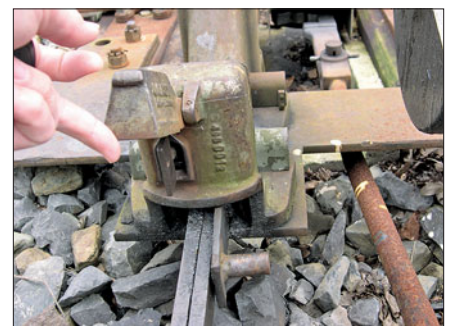
Das Kuppelschloss enthält den für die Gleissperre passenden Schlüssel, hier gegen Entnahme gesperrt.
