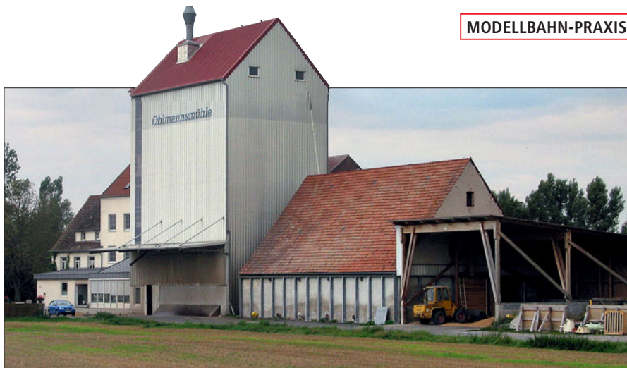
Die Ohlmannsmühle im fränkischen Oberlaimbach besteht aus einem großen Siloturm, einer beachtlichen Lagerhalle sowie einem ungewöhnlichen, da offenen Unterstand für die Getreidezwischenlagerung.
