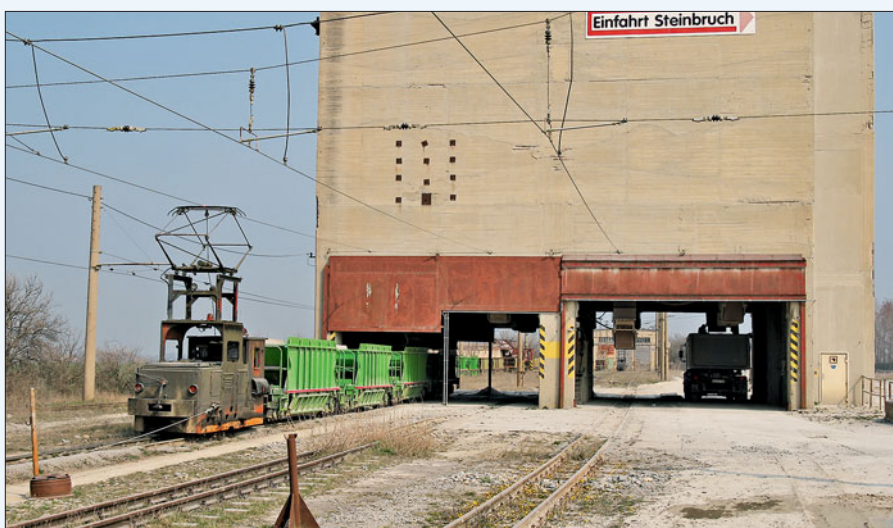
Im Foto vorn rechts die Spillanlage, die für zwei Gleise nutzbar ist. Die Bleche über den Öffnungen am Silo schützen vor der Staubentwicklung bei der Beladung. Die Fahrdrähte sind direkt am Silogebäude befestigt.
