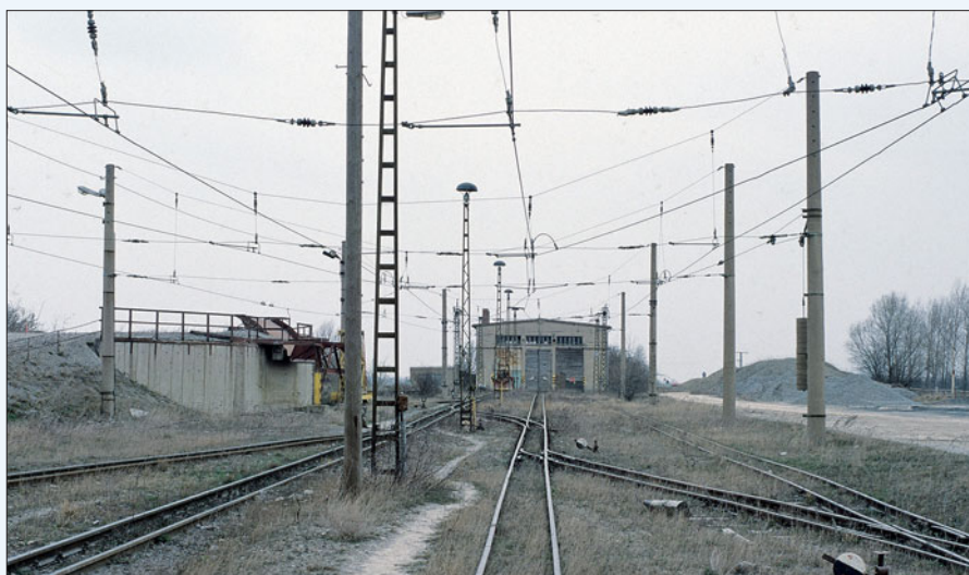
Unten: Verladebahnhof mit dreiständigem Lokschuppen und Silogebäude mit Verladeanlage. Das Förderband für die Beschickung des Silos vom Gelände des Steinbruchs aus überquert die Landstraße. Vorhanden sind zwei Ladestraßen und eine Schüttrampe für Beladungen im Störfall. Zum Rangieren gibt es zwischen den Gleisen eine Seilzuganlage. Die Strecke zum Sodawerk verlässt den Bahnhof in einer Rechtskurve und kreuzt die Regelspurstrecke Schönebeck-Güsten, an der sich eine Ladestraße des Steinbruchs befindet, der kurz vor der Bahnüberführung mit Straßenfahrzeugen erreichbar ist.
