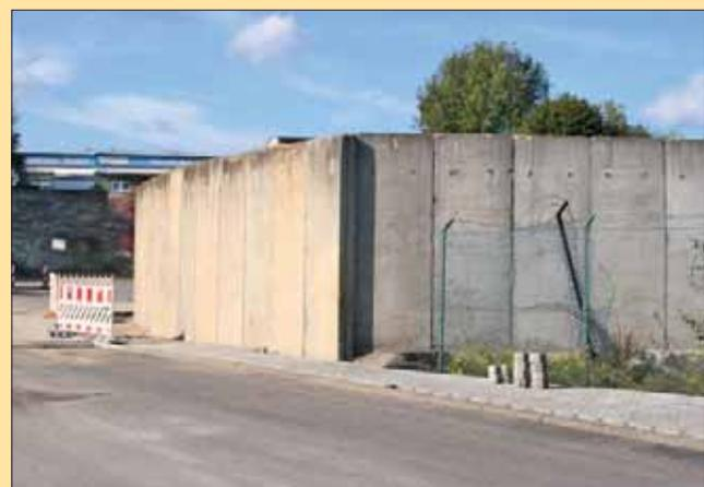
Zum Errichten der Schüttgutboxen sind die Winkelstützen meist drei Meter hoch und so dicht nebeneinander gestellt, dass kein Sand durchrieseln kann. Mit der Zeit altert der Beton.
