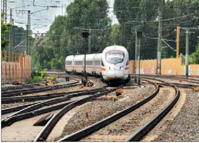
Ein ICE aus Richtung Würzburg in der Einfahrt von Fürth Hbf. Massive Radlenker sorgen für ein sicheres Befahren im Weichenabzweig.
