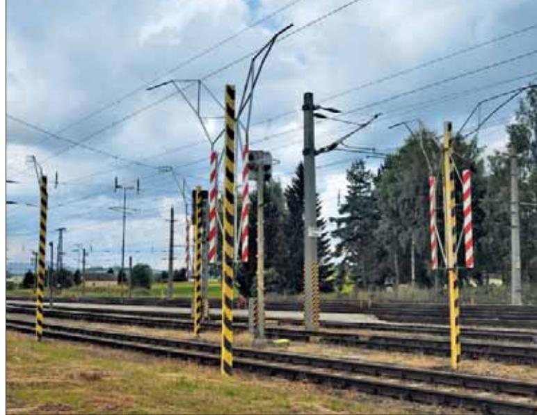
In Summerau gibt es ein mit Fahrleitung überspanntes Ladegleis, dessen Lademaß eine besondere Kennzeichnung erforderte.
