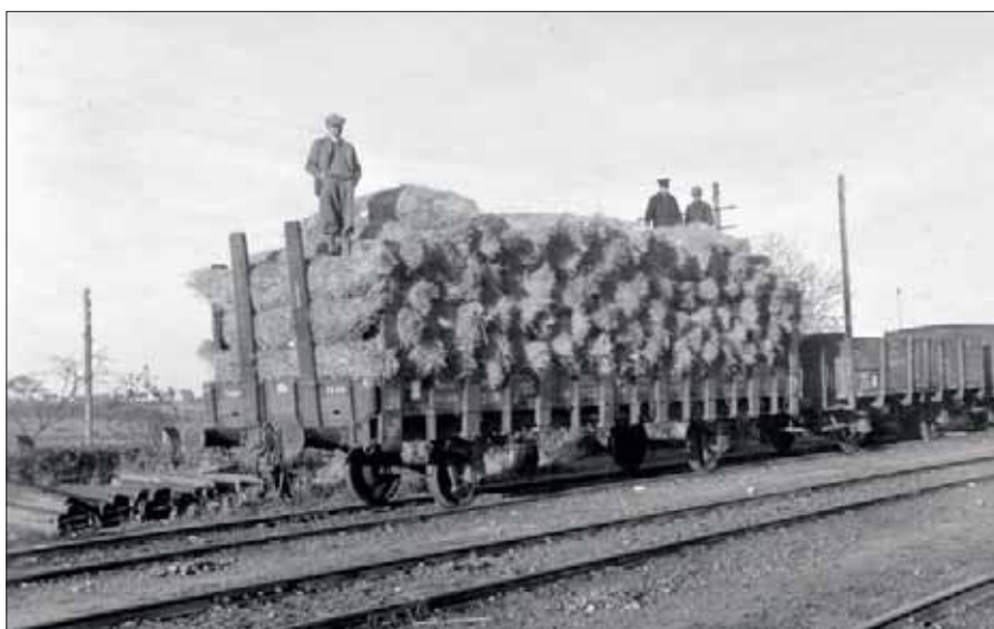
Hier wurden die Jungbäume quer zur Fahrtrichtung auf dem Rungenwagen gestapelt. Die Rungen an der Längsseite sind kaum zu erkennen, da die Ladung etwas übersteht. Die Aufnahme entstand in der ersten Hälfte der 1930er-Jahre.
