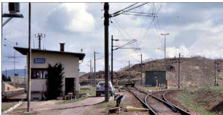
Das obere Foto zeigt die Zufahrt zum Gleisdreieck mit (noch) aktivem Stellwerk (1999), während im Foto unten der Blick auf das Dreieck in der Ausfahrt nach Budweis fällt. Im Bildhintergrund links (einzelnes Bäumchen) liegt die Weiche zum Abzweig in Richtung Bf Summerau.
