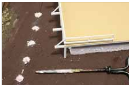
Mit Hilfe der fertigen Terrasse kann man die Position der Pfostenlöcher ermitteln.
