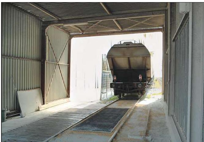
Zum Schutz vor Nässe überdachte Entladeanlage: Die Entladung erfolgt hier in einen Tiefbunker über seitliche Waggonklappen. Eine Spillanlage (im Foto rechts unten sichtbar) dient der Bewegung des Waggons während des Entladevorgangs.
