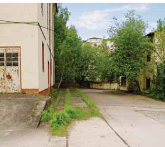
Auf dem an den Bf Alling anschließenden Industriegelände ist das Gleis im Straßenplanum noch vorhanden.
