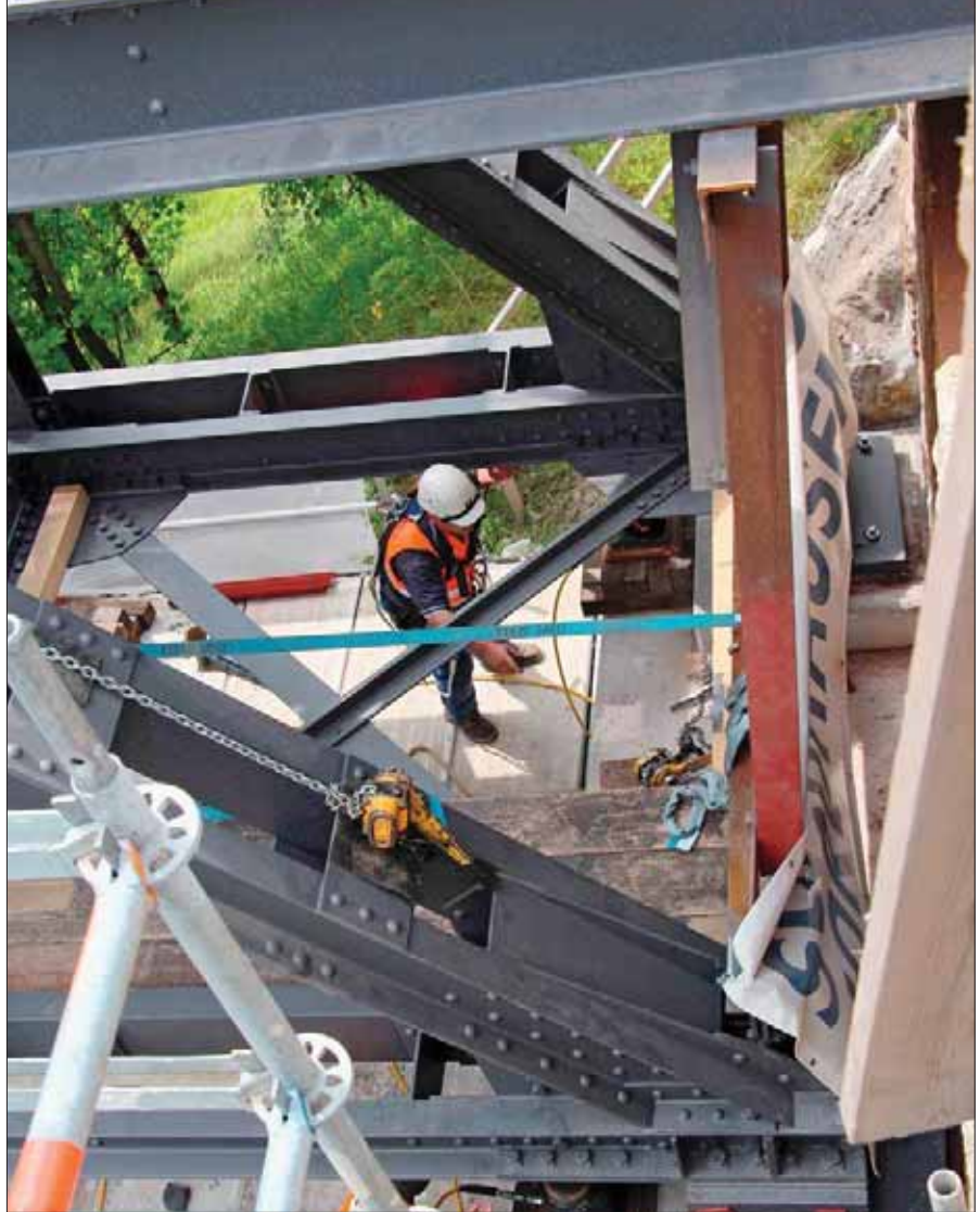
Bei der Brückenkonstruktion von Angelroda bilden zwei gegeneinanderzeigende U-Profile statisch gesehen einen Doppel-T-Träger. Zu einer Einheit sind die Träger mit Platten bzw. U-Profilen verbunden. Siehe auch Beispiele für Querschnitte Mitte in MIBA 3/2014, S. 57.
