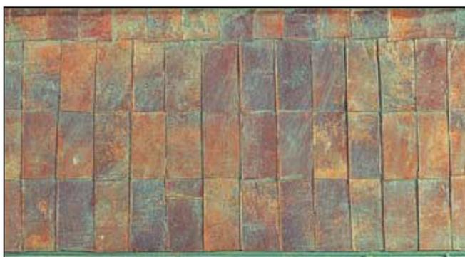
Für die Dacheindeckung wurde Kupferfolie ausgeglüht und in 9 x 20 mm große Schindeln geschnitten.
