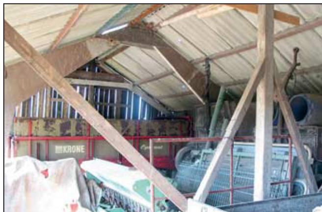
**Die Innenaufnahme** gibt weiteren Aufschluss über die Konstruktion, wobei die Zwischenträger aus alten Schalbrettern entstanden. Die einzelnen Gefache dienen zur Aufbewahrung landwirtschaftlicher Geräte und Materialien.
