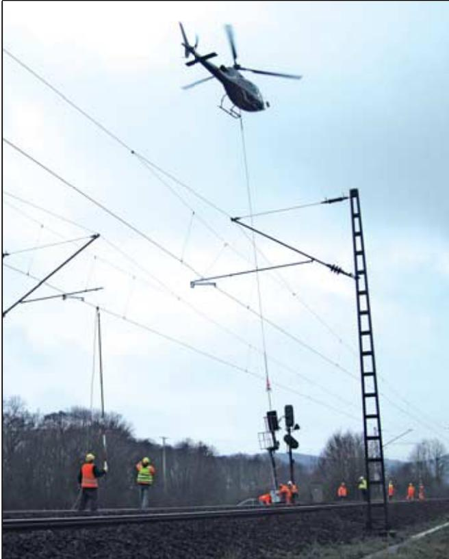
Während mit einer rotweißen Stange plus Kabel die Fahrleitung geerdet wird, hält sich der Hubschrauber in der Standschwebe, damit die drei Monteure den „Fuß“ des neuen Signals auf das speziell vorbereitete Betonfundament aufschrauben können.
