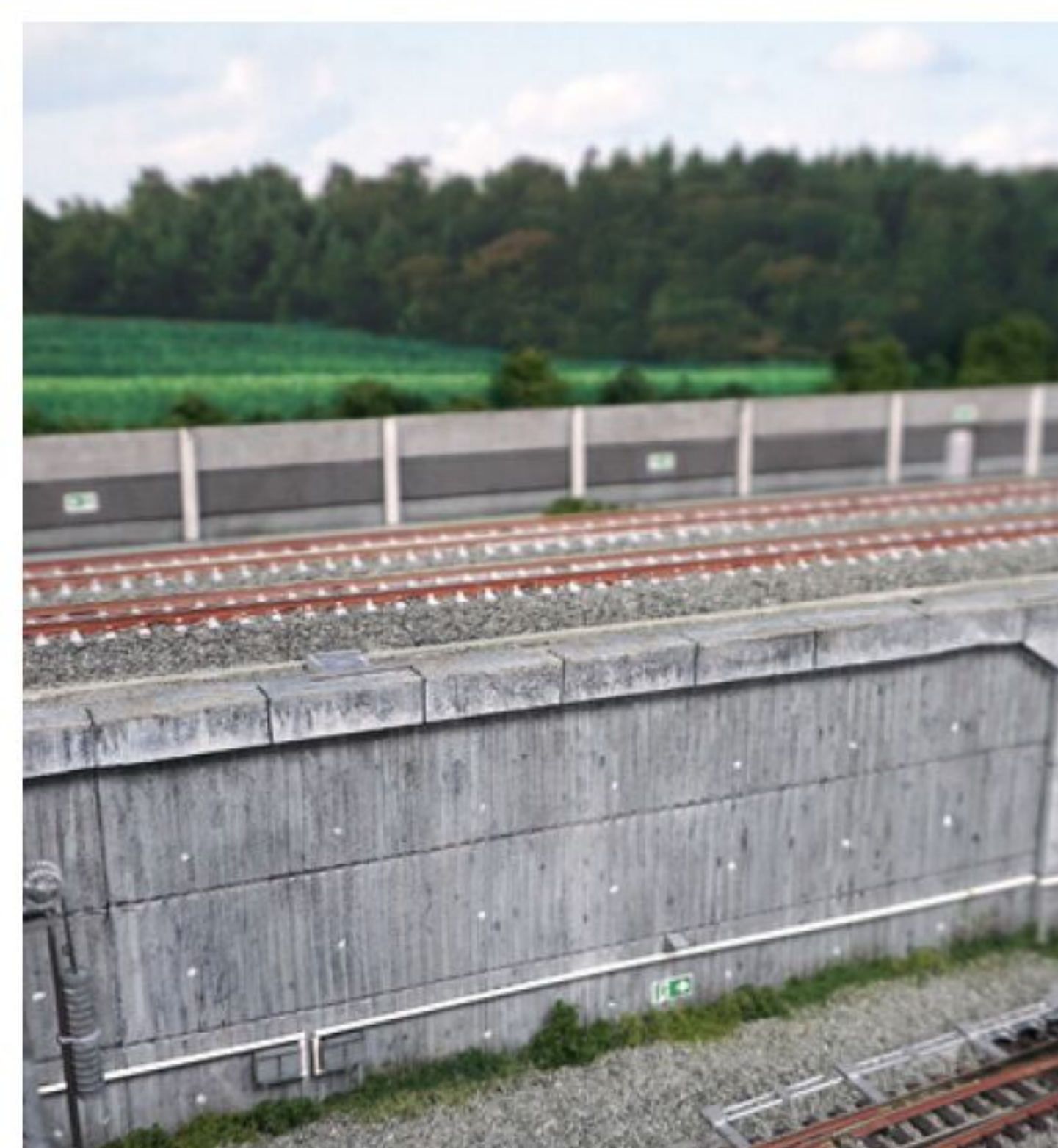
Betonwand: Die Styrodurflächen sind strukturiert und intensiv farblich überarbeitet.
