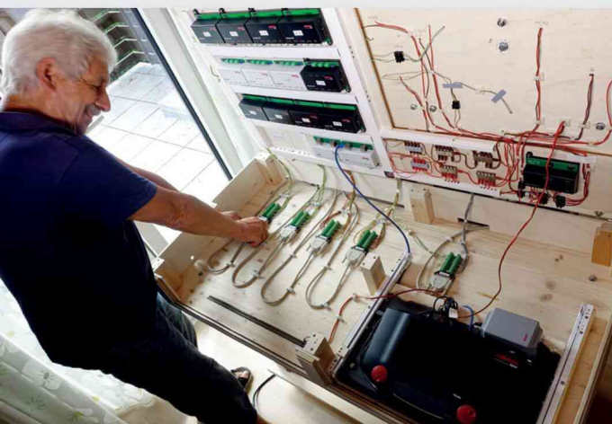
Tiefgeschoss: Unter der Anlage sitzt die geballte Technik – dank Klappmechanismus sehr gut zugänglich.
