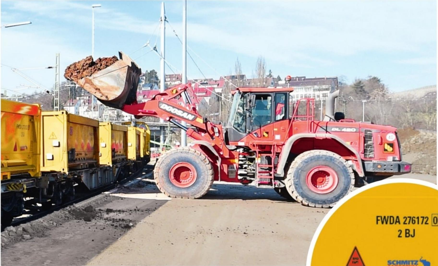
Der S21-Erdaushub wird per Lkw zu den Logistikflächen gebracht – die einzelnen Container befüllt dann ein Radlader. In Spitzenzeiten fahren bis zu 13 Züge pro Tag aus, um den anfallenden Erdaushub von bis zu 15.000 Tonnen täglich abzutransportieren.
