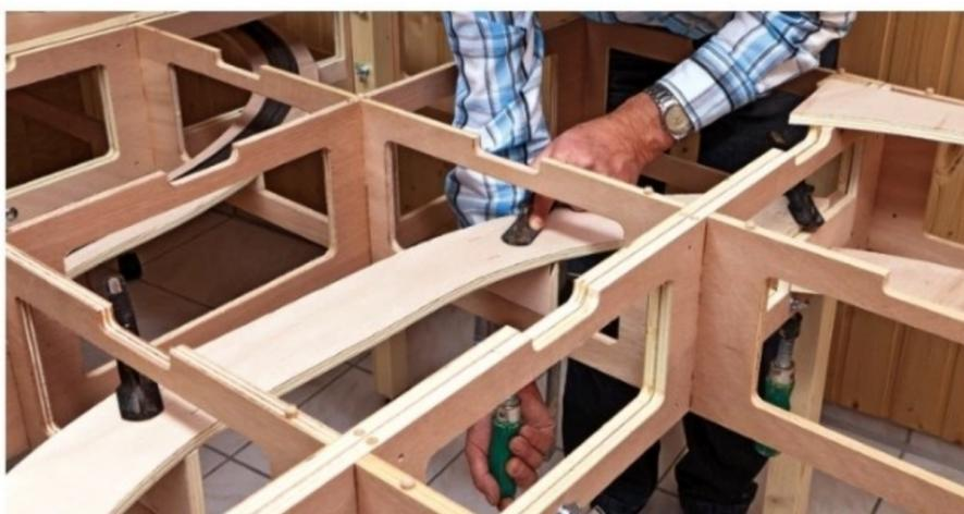
Der Schienenweg entsteht: Die Trassenbretter werden eingesetzt und mit den Abstandshölzern bzw. den Rahmenbrettern verleimt.
