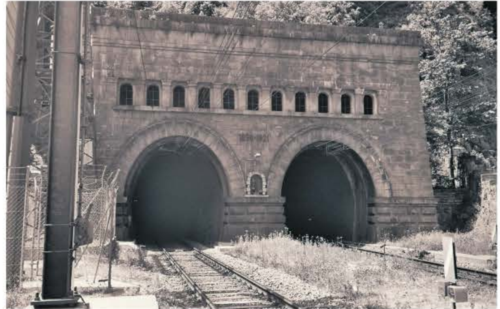
Historisches Gemäuer: das Portal des Simplon-Tunnels (Einspurrohren) auf der Südseite bei Iselle in Italien.
