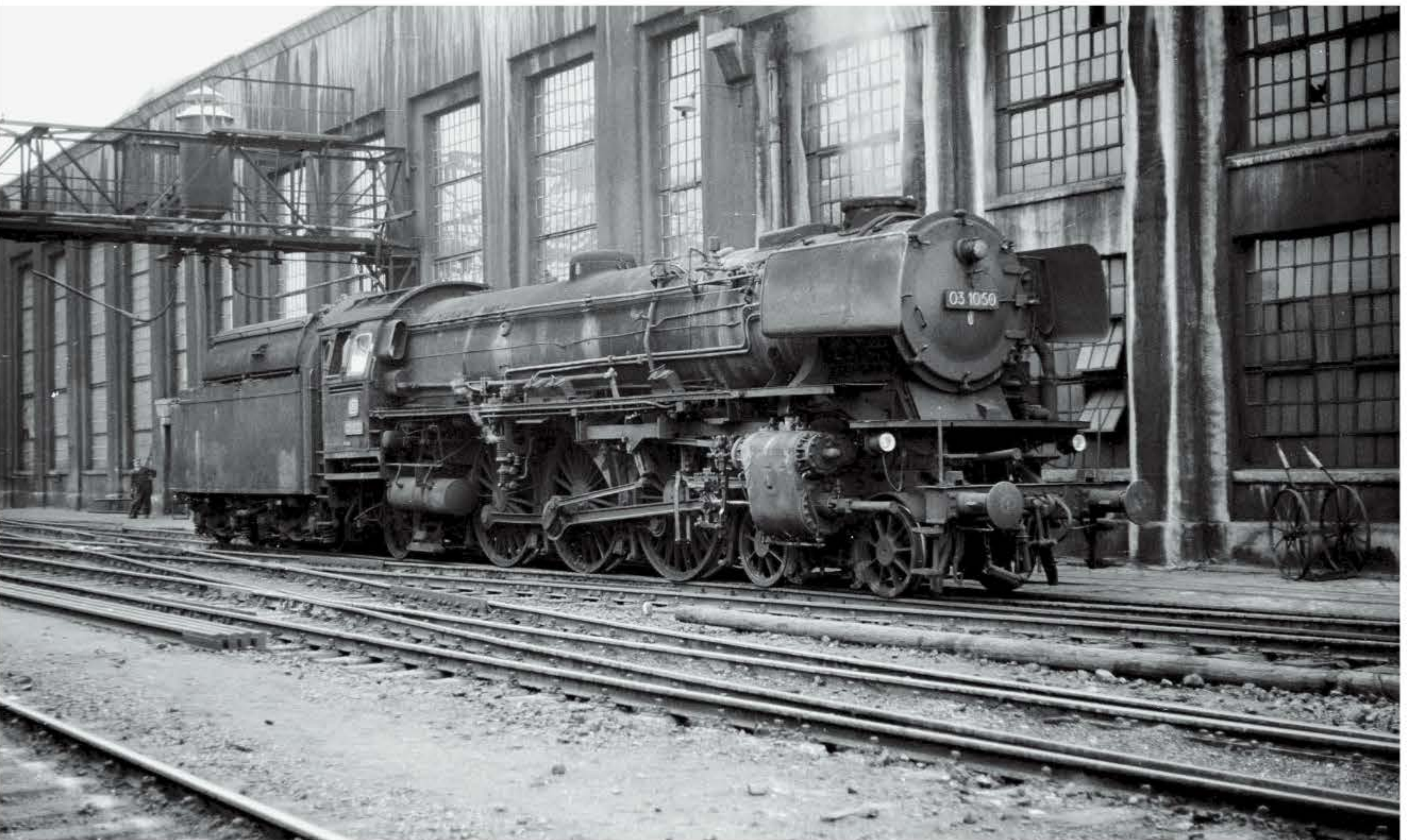
Als eines der letzten Exemplare der Baureihe verließ die 03 1050 im Jahr 1941 die Fabrikhallen von Krupp. Schön zu sehen das Kolbenstangen-Schutzrohr des Innenzylinders über der Pufferbohle.
