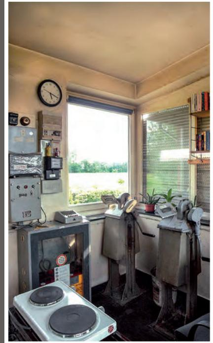
Mit einem Kurbelbock, der sich mit weiterer Ausrüstung in dem Wärterhaus befindet, wird die Feldwegschränke auf Zuruf des Straßennutzers vom Wärter geöffnet und geschlossen.
