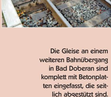
Die Gleise an einem weiteren Bahnübergang in Bad Doberan sind komplett mit Betonplatten eingefasst, die seitlich abgestützt sind.
