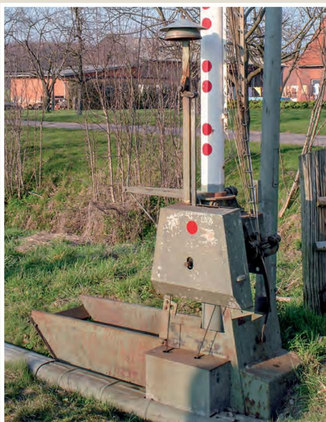
Der Blechkasten zum Versenken des Schlagbaum-Gegengewichts ragt weit aus dem Boden, da das Gelände niedriger liegt als die Trasse.
