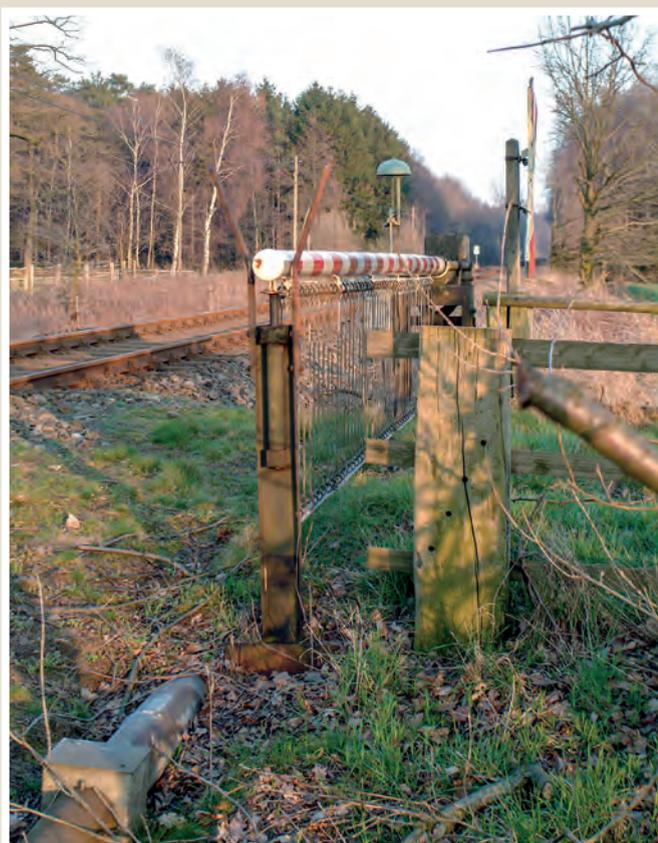
Der seitliche Schutzzaun aus Holz reicht bis an den Schrankenbaum heran. Der Seilzugkanal verläuft im Schrankenbereich unterirdisch.
