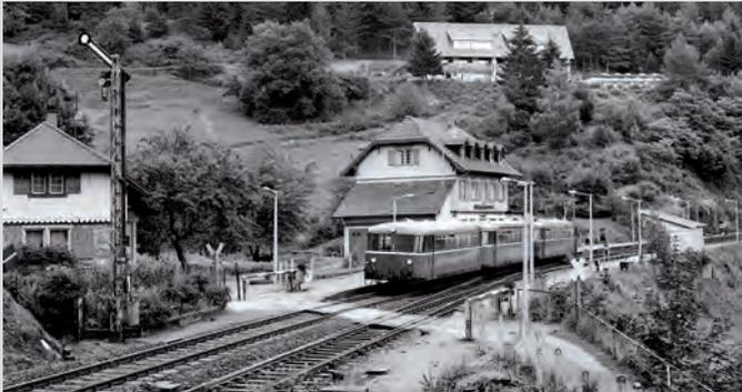
Im Bahnhof Nussbach wird der Fußweg über die Bahnstrecke gleichzeitig als Bahnsteigzugang genutzt und ist beleuchtet sowie gesichert.
