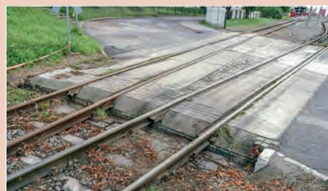
Der Straßenbelag am Bahnübergang vor dem Bahnhof in Bad Doberan besteht aus Betonplatten, deren Zwischenräume mit Pflastersteinen aufgefüllt sind.
