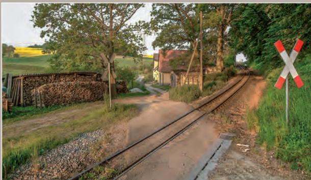
Das schräg angebrachte Blech mit der Systemaufschrift dient in Zarchlin 2016 als Auflaufplatte für eventuell herunterhängende Kupplungen.
