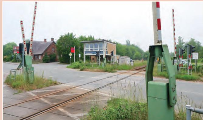
In Lensahn/Holstein ist der Übergang mit standardisierten Betonplatten eingefasst. Der Fußweg ist deutlich von der Straße getrennt.
