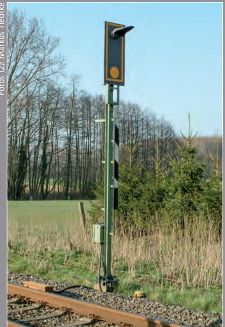
Das Bahnübergang-Überwachungssignal hat direkt neben sich die Kontakte und steht vor dem Bremsweg zum Übergang.
