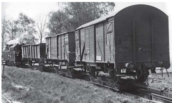
Der Rollwagenzug fuhr 1971 in Kesselsdorf quasi durch die Wiese.
