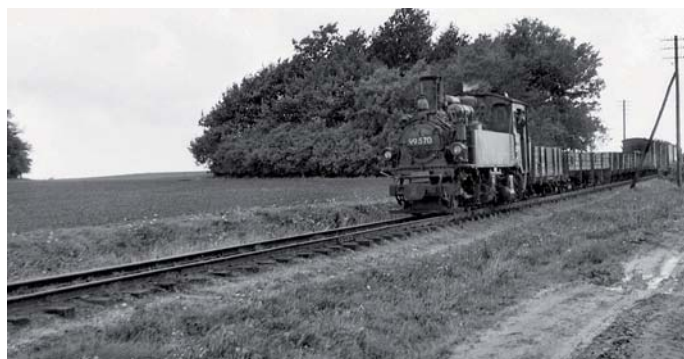
Weniger professionell lag einst das Streckengleis auf Rügen im Sand.
