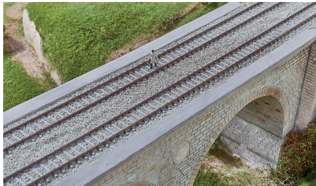
Der Streckenläufer geht das frisch eingeschotterte Gleis mit Betonschwellen ab. Es fehlen an der fast fertigen Brücke mit 24 Gewölben nur noch das Geländer und die Oberleitungsmasten.
