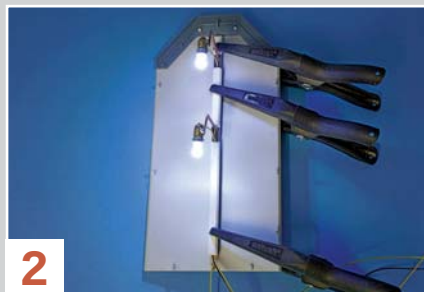
2 Die Befestigung des mehrarmigen Galgens erfolgt an einer Hausseitenwand. Statt Glühbirnen sind auch Schraub-LED denkbar.
