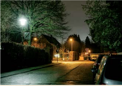
Unterschiedliche Lichtfarben trifft man heute bei Straßenlampen an, je nach verwendetem Lichtkörper und örtlicher Vorschrift.
