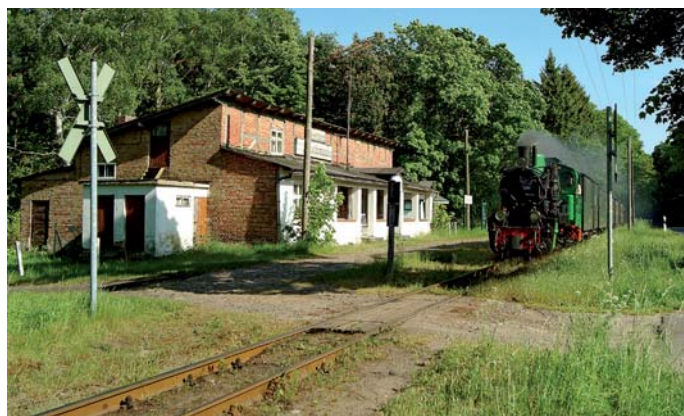
Einfacher Wegübergang auf Rügen, mittig mit Holzplanken gesichert.
