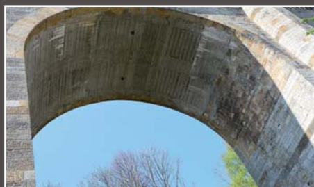
Jedes Gewölbe ist individuell. Die nördlichen Bögen haben kriegsbedingte Ausbesserungen.
