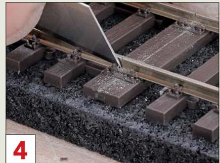
Die kleine Haltenase der Schienenklemmplatte muss für die seitlichen Schienenverbindungsplatten weggeschnitten werden.
