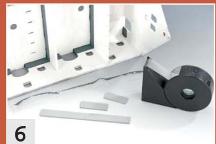
6 Typisch sind die dunkelgrauen, etwa brusthohen Absetzsockel. Mit einem leicht ablös-baren Klebeband deckt man die Wand ab.
