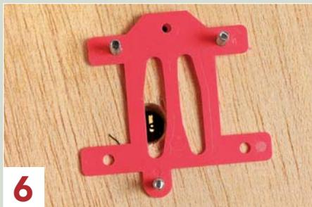
**6** Unter der Anlage hilft eine Positionierschablone bei eventuell schief stehenden Schrauben.
