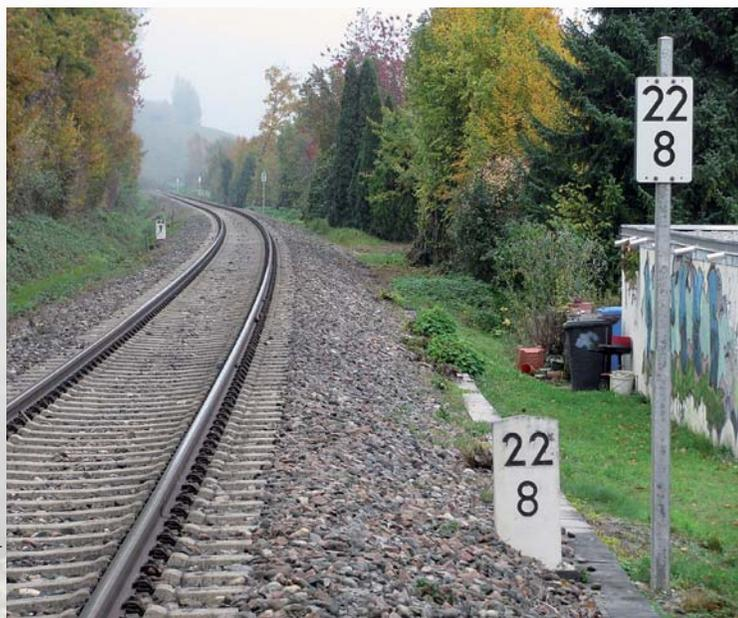
Auf diesem Foto sieht man die auf einer eingeleisigen Strecke alle 100 m wechselnde Aufstellung der alten Kilometersteine gemäß der DRG-Richtlinie, während die modernen Blechtafeln alle 200 m durchgehend rechts stehen.
