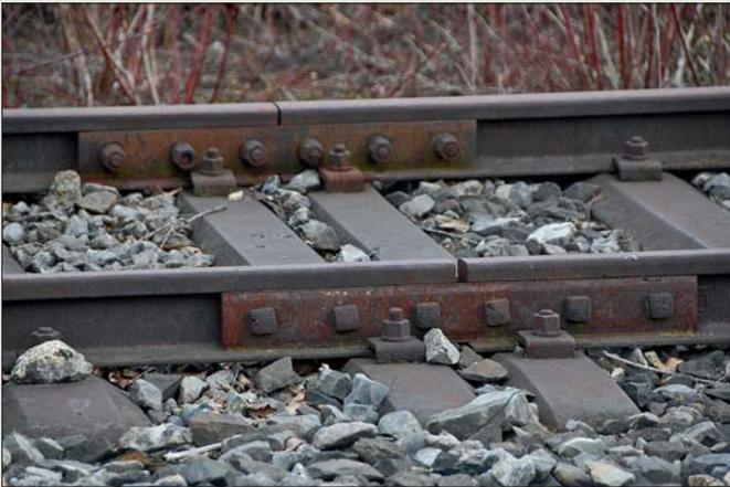
Beim Vorbild wurden vor Einführung der Schweißtechnik die Gleisprofile durch beidseitig eng anliegende, verschraubte Metallplatten miteinander verbunden. Das sorgte für saubere Übergänge.
