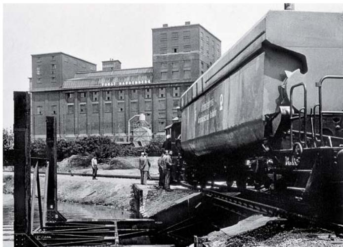
Das Herablassen der schwimmfähigen Behälter zu Wasser mittels eines speziellen Aufzuges steht bei diesem Testlauf unmittelbar bevor.
