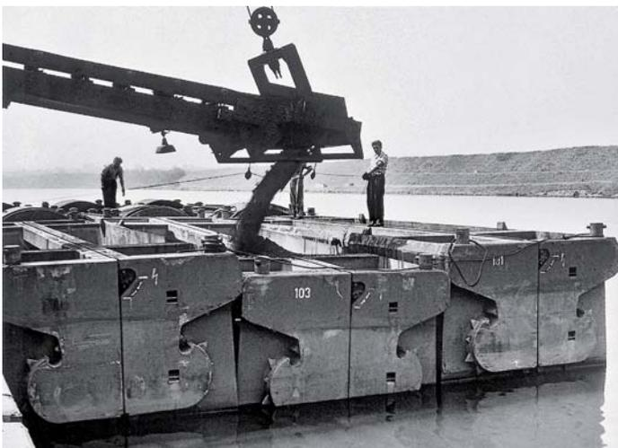
Die schwimmenden Lastrohrbehälter sind zu einer größeren Ladeinheit zusammengefasst und erhalten nun im Kanalhafen ihre Erzladung.
