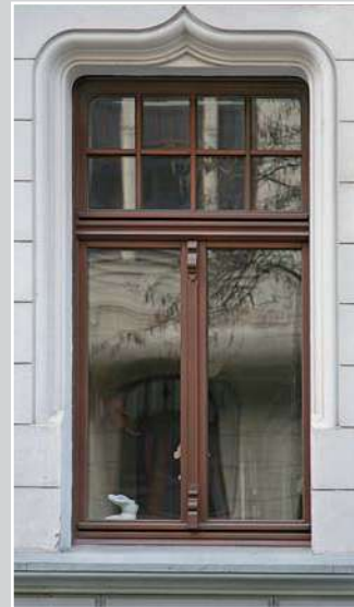
Stadthaus-Fenster mit einem entsprechend der Laibung an den Ecken ausgerundeten oberen Blendrahmen und schmückenden Verzierungen am Kämpfer und der Schlagleiste (Basis und Kapitellchen).
