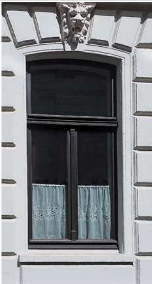
Zweiflügeliges Fenster eines Stadthauses mit Stichbogenoberlicht, profiliertem Kämpfer sowie Schlagleiste, welche eigens zur Verzierung mit Basis und einem Kapitellchen ausgestattet ist.
