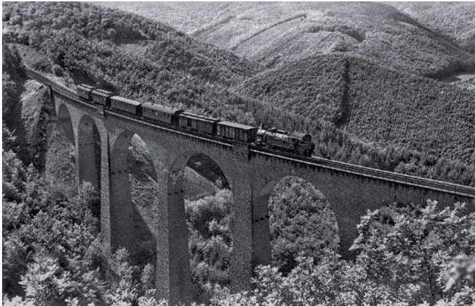
Die Steilstrecke Boppard – Emmelshausen war ursprünglich eine Zahnradbahn. Nach der Umstellung auf Reibungsbetrieb wurden die Loks zur Sicherheit grundsätzlich talseitig eingereiht. Eine 94 rollt hier mit ihrem Zug in den 1930er-Jahren über das Hubertusviadukt.
