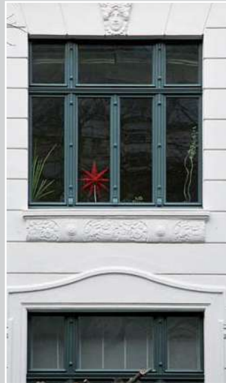
Großes vierflügeliges Fenster, bei dem die mittleren Flügel überschlagend ausgeführt sind und die Seitenflügel an feststehenden, aufrechten Profilen angeschlagen sind. Die Oberlichter sind analog angeordnet.
