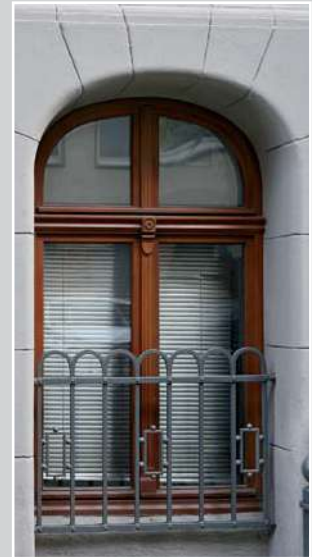
Fenster mit Rundbogenoberlicht und Verzierungen.
