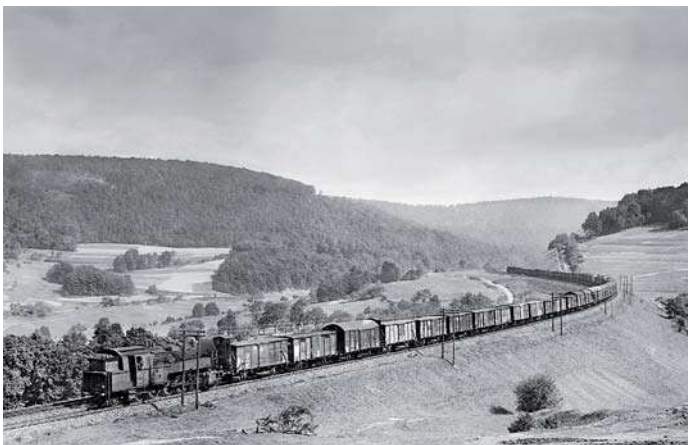
Die Spessart-Rampe Laufach – Heigenbrücken ist keine Steilstrecke, aber auf der wichtigen Magistrale Richtung Würzburg mussten viele schwere Züge mit kräftigen Loks nachgeschoben werden, hier die 95 007 im Blockabschnitt Hain in den 1950er-Jahren.
