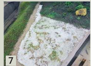
7 Großflächig, aber nicht geschlossen wird der Leim auf den Untergrund aufgetragen.
