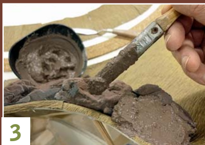
3 Mit einem kleinen Spachtelmesser oder auch einem härteren Flachpinsel wird das Material in dünnen Schichten aufgetragen.
