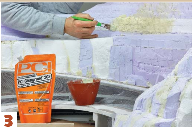
3 Durch das Auftragen von PCI Gisogrund erhalten glatte Kunststoffoberflächen wie Styrodur eine ideale Haftung für den späteren Gips.
