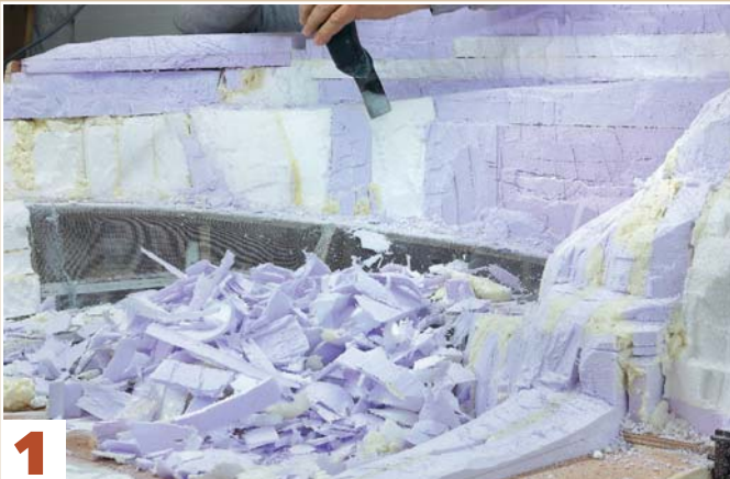
1 Mit dem Tauchsägeblatt eines akkubetriebenen Multifunktionswerkzeugs trägt man schichtweise Schaumplatten ab, formt so den Berg.
