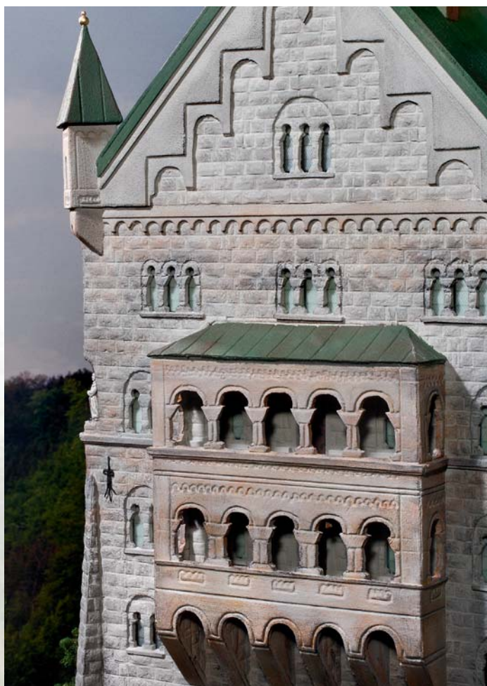
Da nicht vorgesehen war, das Innere der Gebäude zu beleuchten, erhielten die Fensteröffnungen innenseitig nur eine Verblendung.
