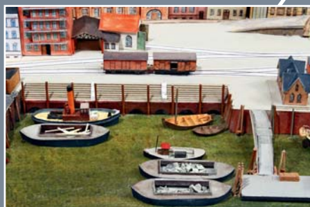
Holzhafen: Diese Kaianlage ist sehr alt und die Kaimauer hier stufenförmig abgesenkt, um Holz und andere Waren auch ohne Kran besser bei kleinen und niedrigen Schiffen und normalem Wasserstand ent- bzw. beladen zu können. Hier liegen die Boote in mehreren Reihen nebeneinander.
