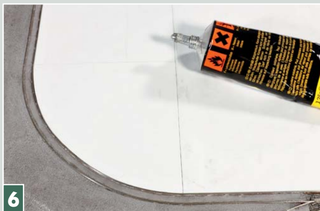
Mit Hilfe eines guten Haftklebers setzt man dauerhaft die so gewonnene Bodenplatte sauber zwischen Schiene und Restboden ein.
