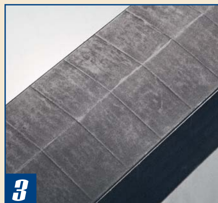
3 Die Farbgebung der Dachhaut erfolgt in einem leicht bräunlich schimmernden Schwarzgrau in Lasur-Maltechnik.
