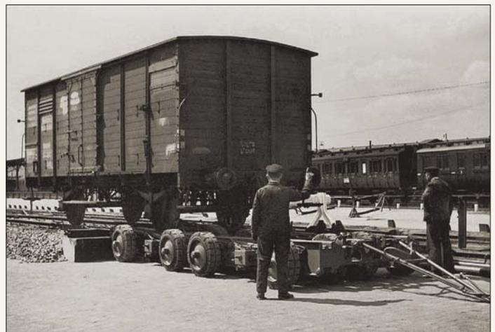
Langsam zog man den Güterwagen auf den zuvor mittels eines Kupplungshakens an der Rampe fixierten Culemeyer-Straßenroller.
