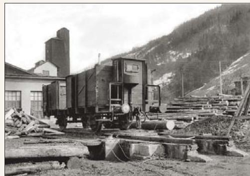
Entschied sich eine Firma für das Culemeyersystem, baute sie ebenfalls die typische Wagenumsetzanlage wie hier ein Sägewerk im Schwarzwald.
