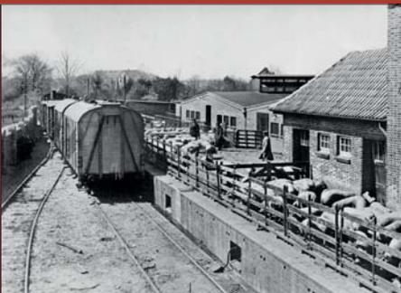
Stationäre Viehrampe mit angeschlossenen Anliefer- und Quarantänestellungen sowie Reinigungsmöglichkeiten für Viehwaggons.
