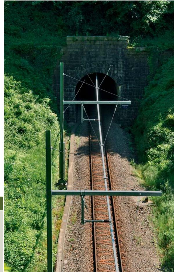
An der Murgtalbahn bestehen die Masten aus H-Profilen, an denen die Ausleger angeflanscht sind. Der normale Fahrdrath läuft unten in einer an den Auslegern angebrachten Schiene.
