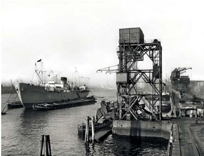
Um die unterschiedlichen Wasserstände durch Ebbe und Flut beim Entladen der mit Kohle beladenen Güterwagen ausgleichen zu können, kombinierte man im Hamburger Kaaken-Hafen, hier 1957, den Wagenkipper für die Binnenschiffe mit einem Aufzug.
