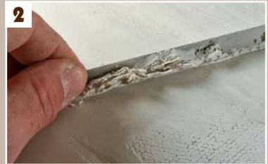
2 Den zur Verfüllung der dicken Teile aufgetragenen Gips schabt man glatt.
