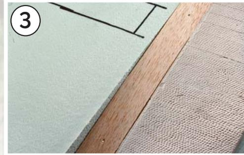
3 Der Bereich des Gehwegs wird mit 2-mm-Balsaholz aufgefüttert.
