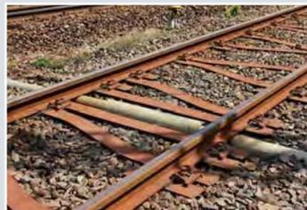
Am Durchlass eines Drahtzuges liegen zwei gegenüberliegende Endschwellenroste.
