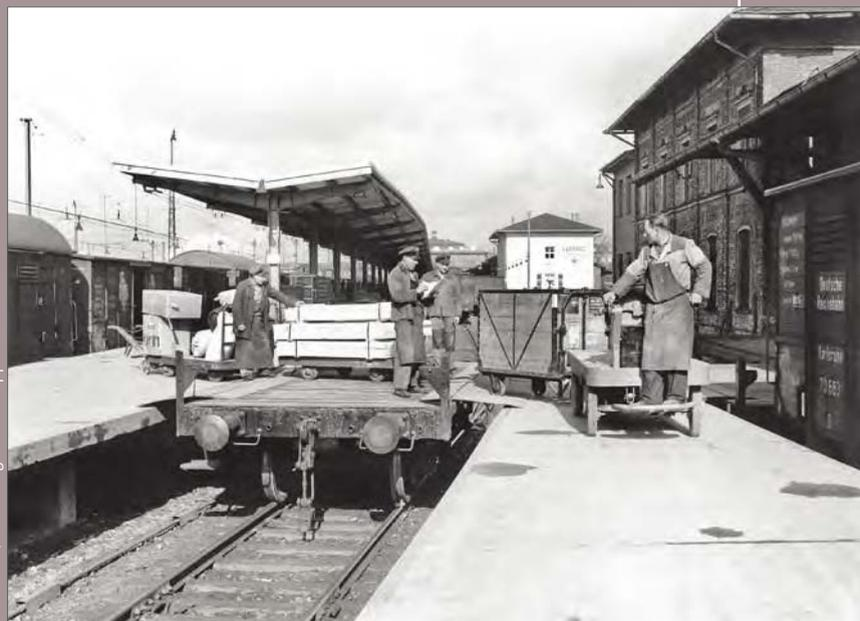
An der Güterabfertigung Augsburg mit separatem Ladebahnsteig diente 1938 ein Güterwagen ohne Bordwand als Überfahr-Hilfe, wenn keine zu beladenden Wagen an dieser Stelle standen.
