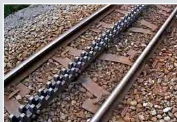
Schweizer Bahnen nutzen Y-Schwellen als tragenden und belastbaren Unterbau für Zahnstangen.
