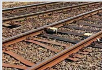
Beim Übergang auf Normalschwellen verwendet man eine Sonderform mit geradem Abschluss.
