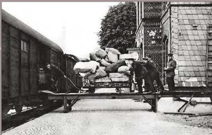
Um Fracht aus dem nicht mit eigenem Gleis versehenen Schuppen in die wartende Leig-Einheit zu verladen, besaß diese Laderampe eine über den Bahnsteig ausziehbare Verlängerung.
