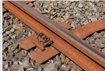
Die Schienenbefestigung erfolgt klassisch mit einer Spannklemme für jede Schienenseite.
