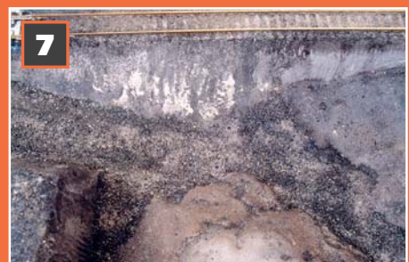
7 In die fertig gestaltete Schlackengrube fügt sich die unbeleuchtete Haube gut ein.
