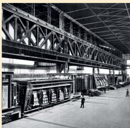
Jeder Ofen hat mehrere Türen, um Schrott mit einem Kranarm zuführen zu können.
