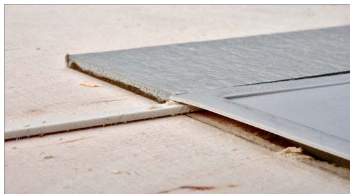
Dünne Kunststoffleisten sichern den Höhenausgleich zwischen dem künftigen Gehweg und der Seuchenwanne der LPG-Einfahrt.
