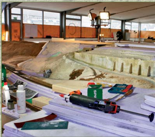
Der Unterbau entsteht aus verklebten Styrodurplatten mit einem Überzug aus gefärbtem Gips sowie verschiedenen Sand- und Erdmischungen.
