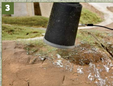
Auf den beflochten Untergrund werden zuerst die langen Fasern dünn aufgebracht.
