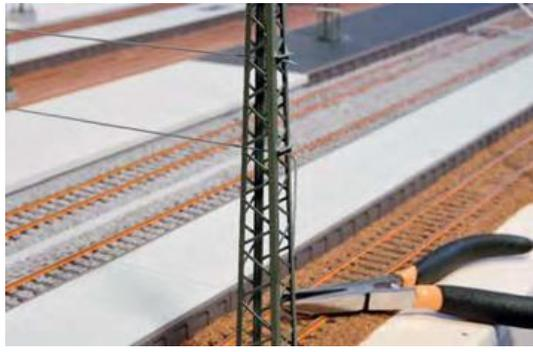
Nach dem Einfädeln in den Turmmast biegt man den Richtseil-Draht mittels Flachzange rechtwinklig.
