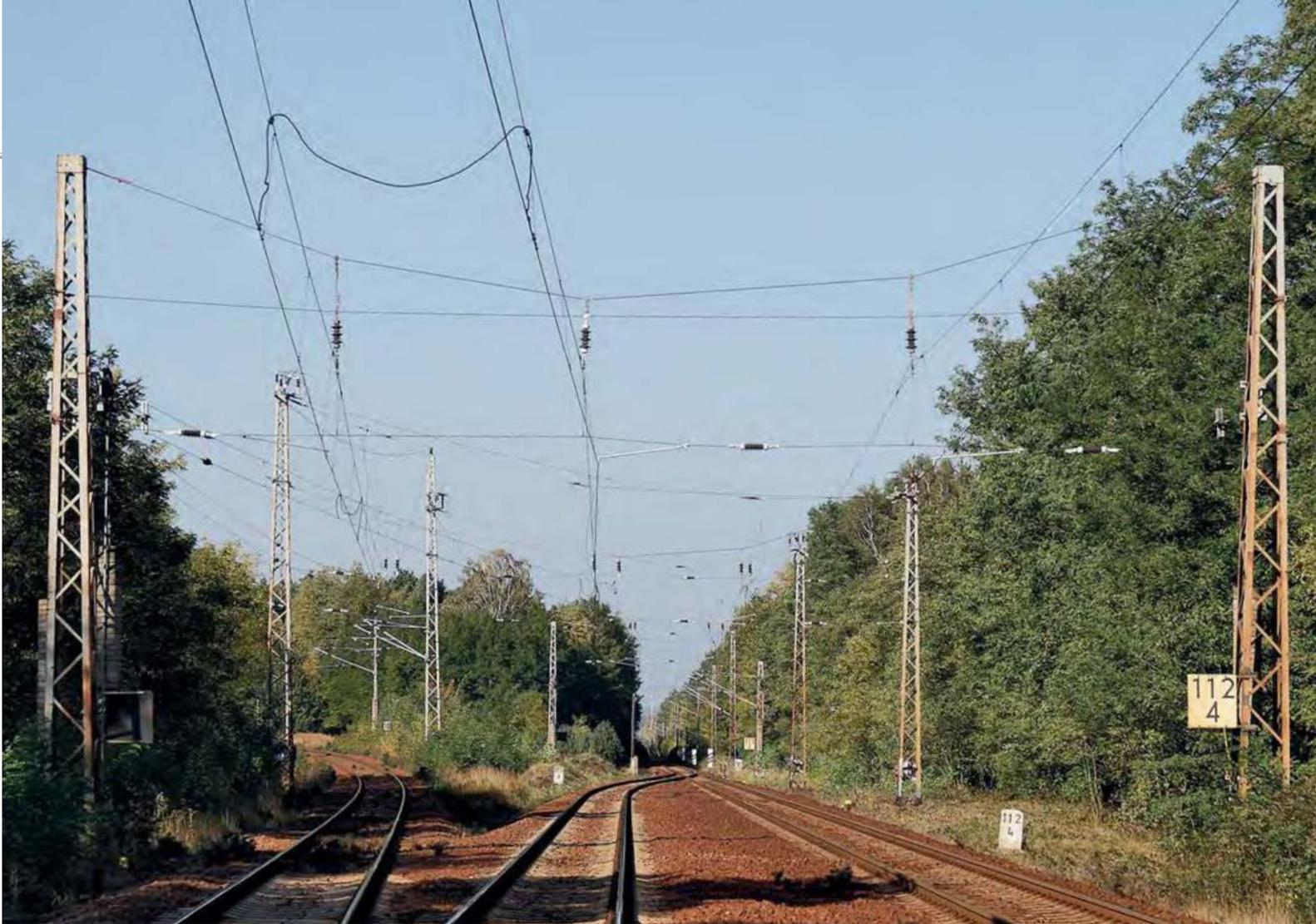
Niedrige Quertragwerke an einem Abzweig. Im Vergleich zur anschließenden Strecke werden Vorteile wie die bessere (Signal-)Sicht deutlich.
