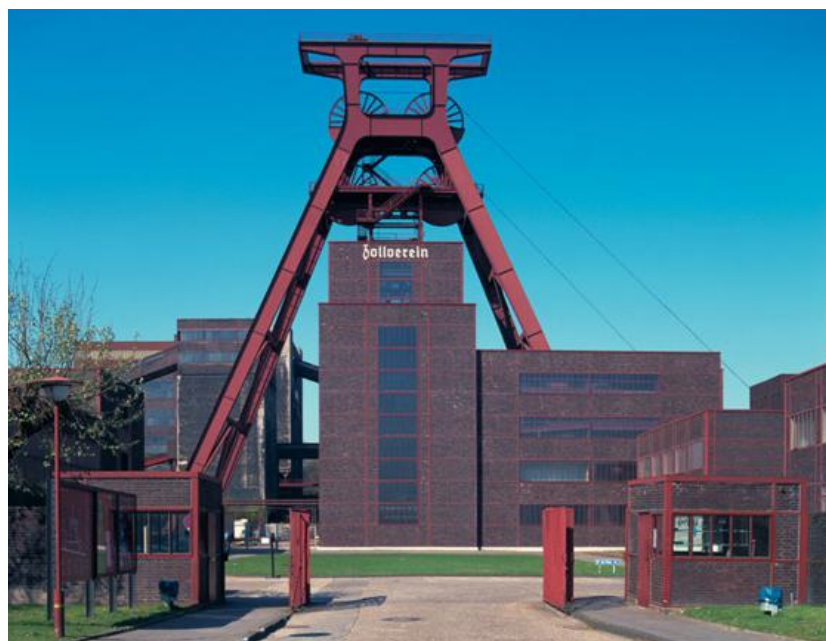
Ab 1925: Statt Fach- werk Vollwände aus Blech, hier 1929 erst- mals als Doppelstre- bengerüst der Zeche Zollverein.
