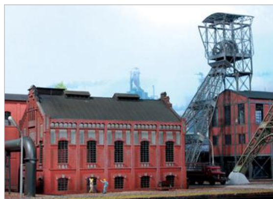
Ab 1900: Deut- sches Strebenge- rüst mit Doppel- förderung (Bau- art Promnitz 2).
