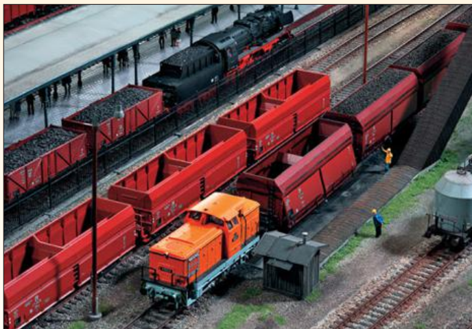
Führt die Bahn die Kohle heran, entlädt man die Kohle in einem Tiefoansen und führt sie mittels Förderband zum Hochbunker.
