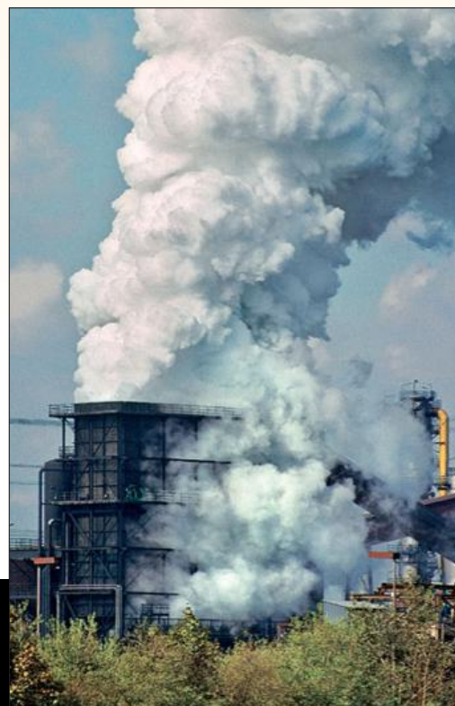
Beim Löschen bildet sich im Turm eine mächtige, weit sichtbare Wasserdampfwolke.
