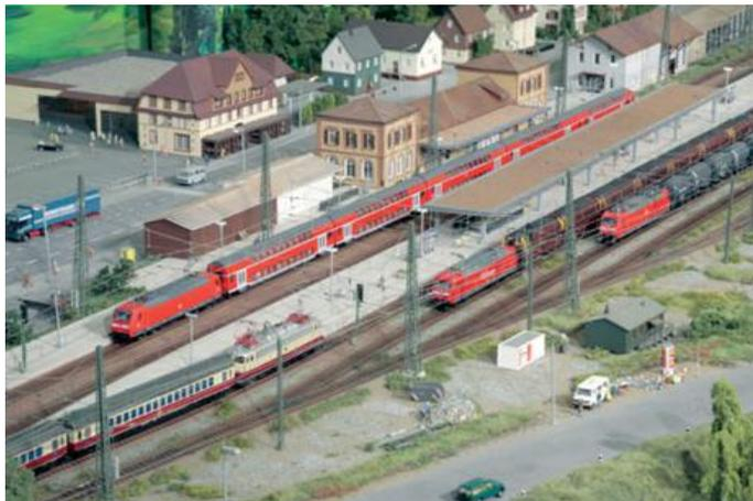
In Bahnhöfen mit vielen Gleisen setzt man Quertragwerke ein, an denen die Fahrleitungen an querlaufenden Richtseilen hängen.
