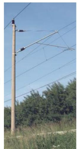
Eine Re 2 der DR für Geschwindigkeiten bis 120 km/h mit Betonmasten. Fahrdrabt und Tragseil werden gemeinsam abgespannt.
