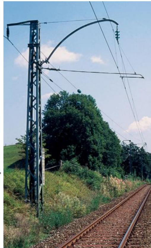
An der Strecke Murnau-Oberammergau stehen auch heute noch Gittermasten mit starrem Rundausleger und Nachspanneinrichtung.
