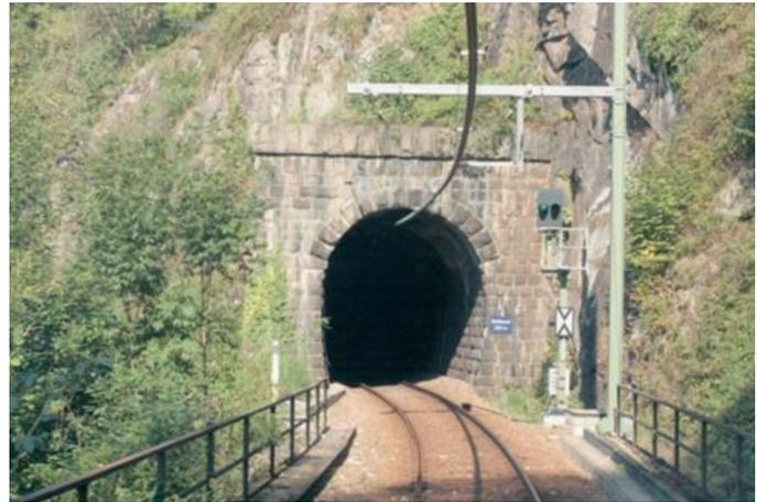
Dank der Deckenstromschiene konnte ohne große Umbaumaßnahmen der alte Tunnel der Murgtalbahn elektrifiziert werden.
