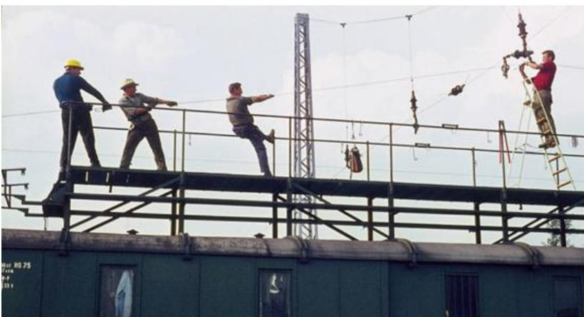
Fahrdrähte und Seile mussten wie beim DB-Fahrleitungstrupp der 1960er-Jahre bei der Montage oft mit Muskelkraft gespannt werden.
