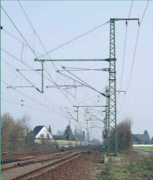
Quertrageeinrichtungen wie dieser Rohrausleger bei der DB können mehrere Gleise überspannen.
