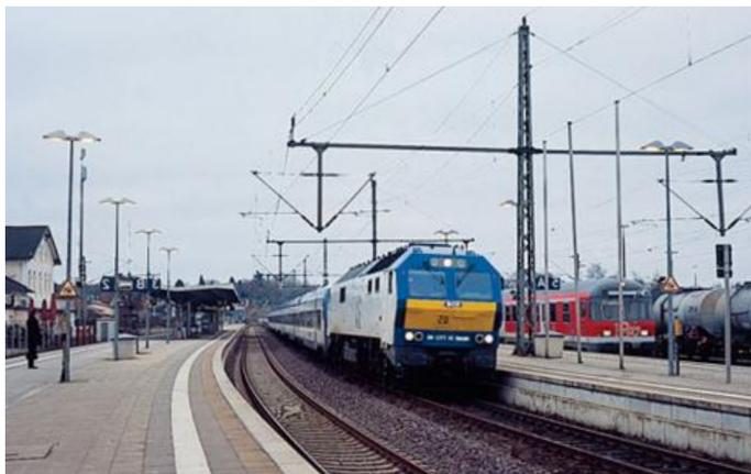
In Itzehoe verwendete man Gittermasten mit beidseitigen Rohrauslegern als Quertrageinrichtung, die oben mit Seilen abspannen.
