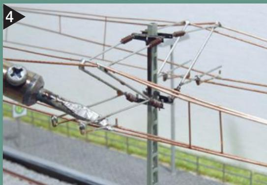
3 Die Seitenhalter werden zum Anlöten mit Klebeband fixiert. Die genaue Position liefert die Montagelehre.
