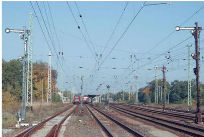
Je mehr Gleise überspannt werden müssen, desto höher sind die seitlich stehenden Gittermasten mit ihren Quertragwerken.
